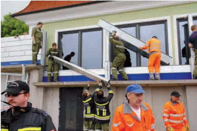
Abb. 9: Einsetzen der Damm Balken
