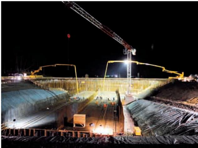
Einbringen von 3.200 m<sup>3</sup> Beton für die Sohle des Mittelteils
