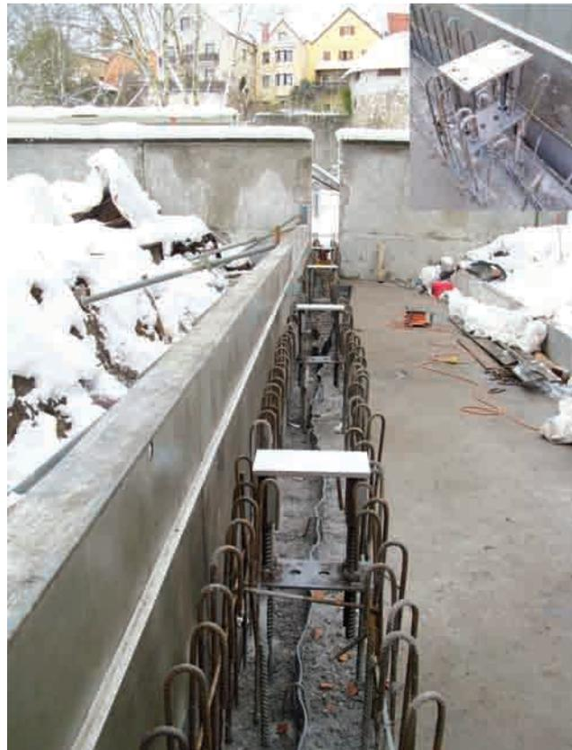
Abb. 4: Versetzen von Ankerplatten
