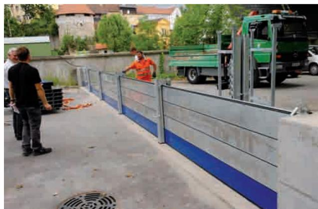
Abb. 5: Komplettaufbau einer mobilen Wand
