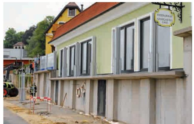
Abb. 8: Montierte Mittelstützen
