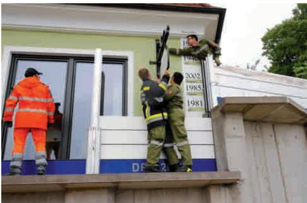
Abb. 10: Weiteraufbau des mobilen Hochwasserschutzes
