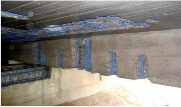
Obj. A1.00C – Betoninstandsetzung an Tragwerksunterseite
