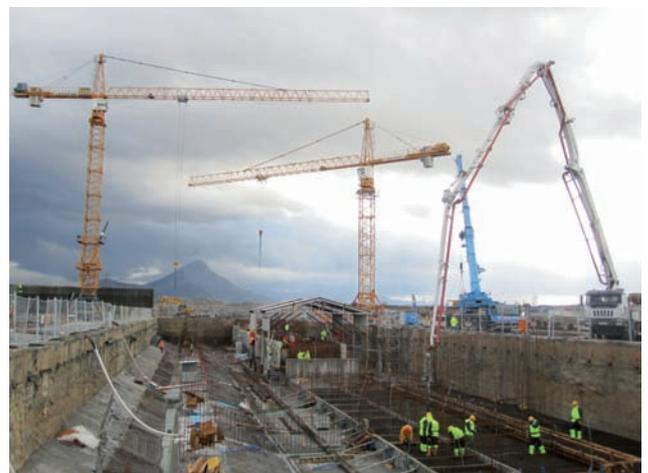
Erste Betonage in trockener Baugrube
