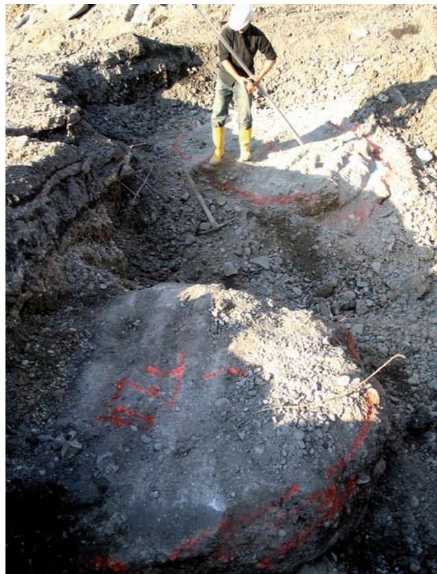
Abb. 1: Freigelegte Probesäulen
