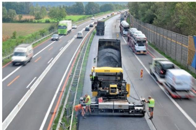
Asphalteinbau unter beengten Platzverhältnissen
