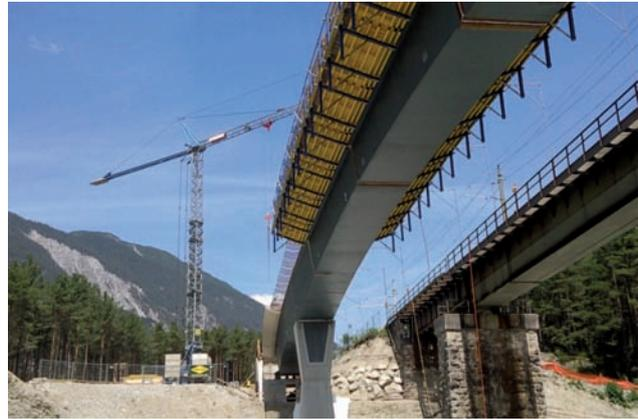
Schalwagen Verbundplatte – Betonierabschnitt Brückenmitte
