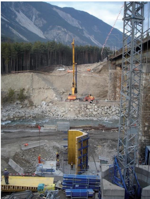
Bohrpfahl- und Schalungsarbeiten Pfeilerbauwerke
