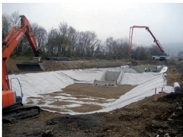
Gewässerschutzanlage – Betonage Absetzbecken, Einbau Bodenfilter in Sickerbecken
