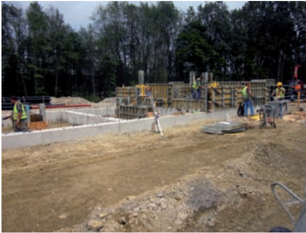
Betonbau Betriebsgebäude Bild: PORR
