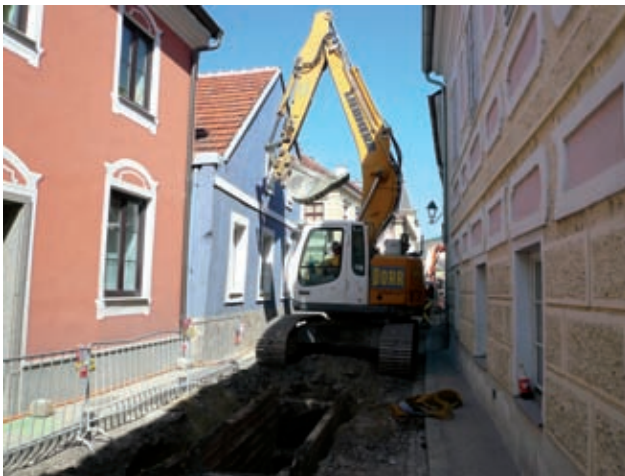
Sehr enge Platzverhältnisse in der Innenstadt von Mautern Bild: PORR
