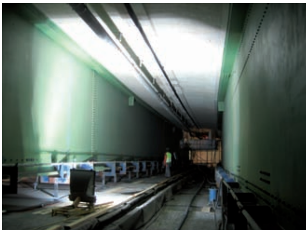
Betonanierung der Mittelfuge Bild: PORR
