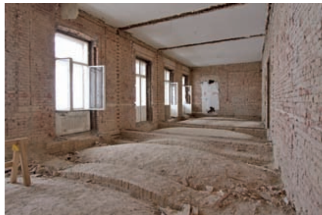
Abbrucharbeiten im 1. OG – zukünftiger Zimmerbereich Bild: Irene Schanda
