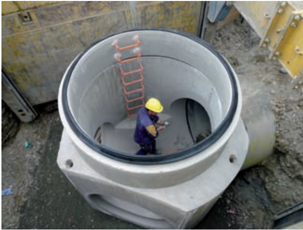
Schachtunterteil DN2000 mit DN1600 Hauptgerinne Bild: PORR
