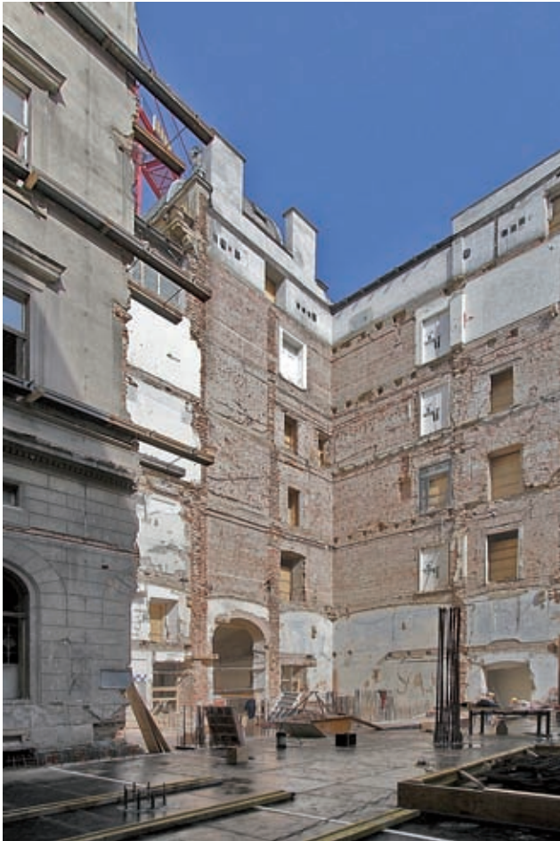
Gebäudeabbruch Innenhof Bild: Irene Schanda
