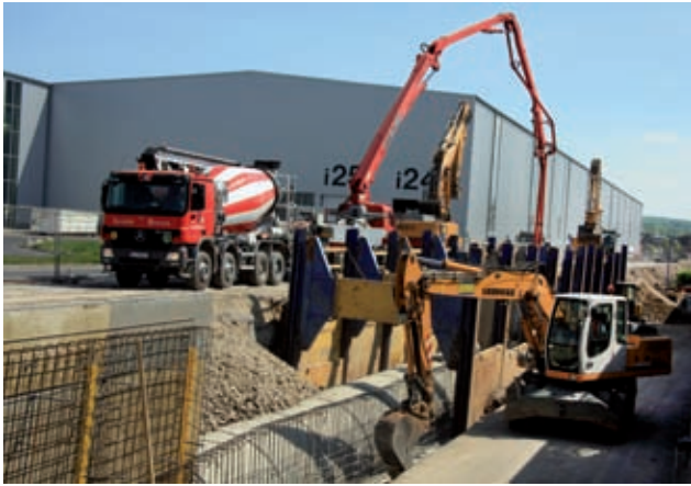
Errichtung der aufgesetzten Stützmauer Bild: PORR
