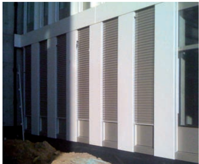
Elementfassade Raffstoreanlagen Bild: Alu-Sommer
