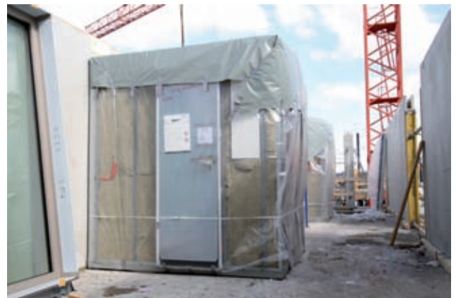
Einbau Fertigbadzellen
