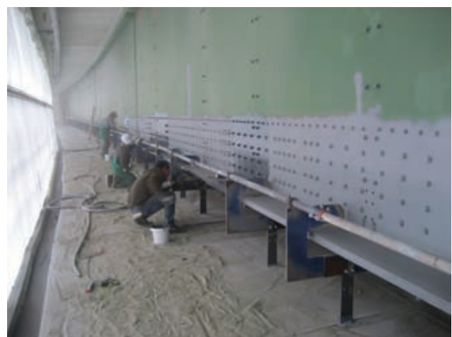
System 2 (untere 70 cm) und System 3 (darüberliegend) Bild: PORR
