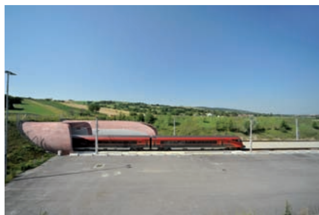
Messfahrt Portal / Freie Strecke, Übergangsbereich Feste Fahrbahn zu Schotteroberbau Bild: PORR
