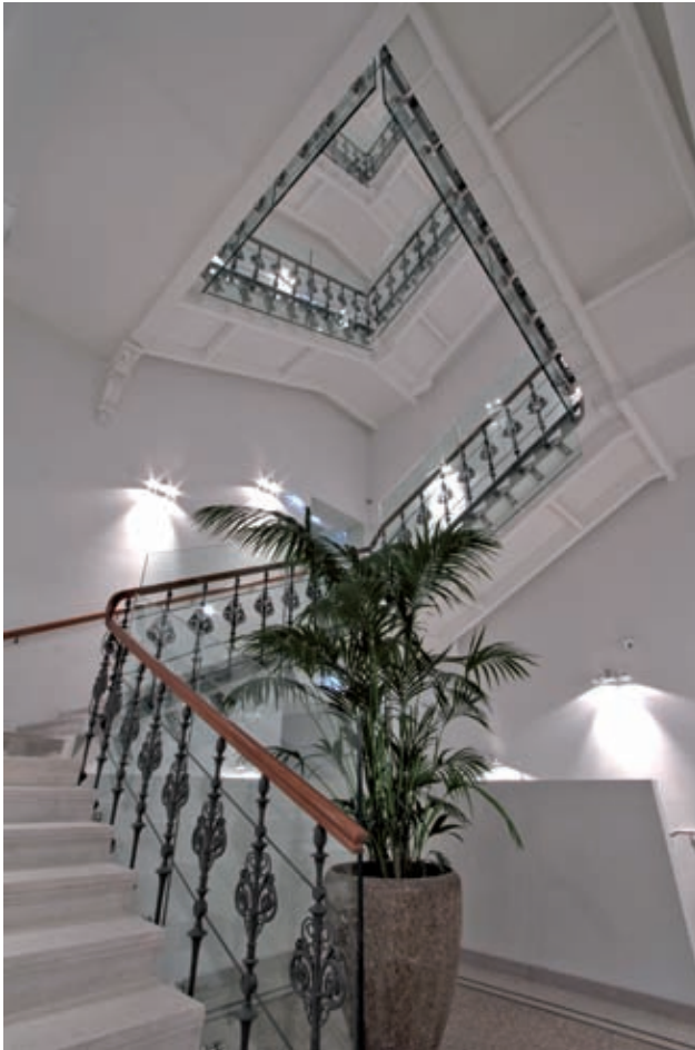
Historisches Stiegenhaus – mit restauriertem Geländer, Glasgeländer und Unterfangung der originalen Keilstufen Bild: Irene Schanda
