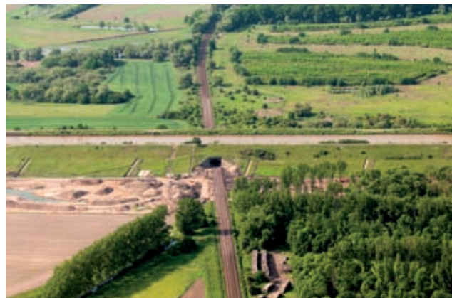
Bestandstunnel und Bahnstrecke, März 2010 Bild: J. Bunte
