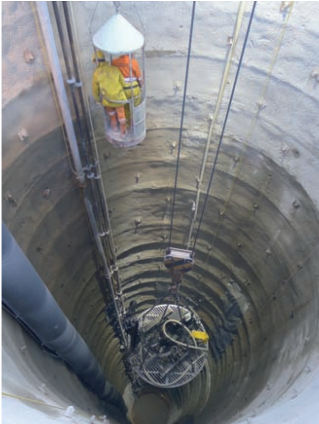
Abbildung 8: Lotschacht Wasserschloss Schoberboden, Schacht abteufen Bild: PORR
