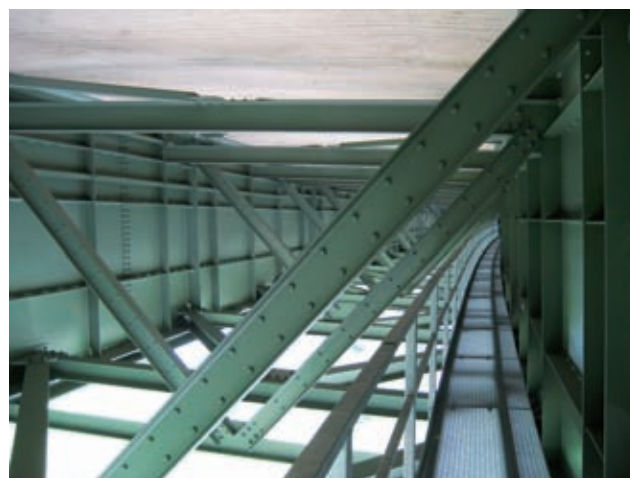
Fertigstellung Korrosionsschutzarbeiten – Stahltragwerk innen mit Revisionssteg Bild: PORR
