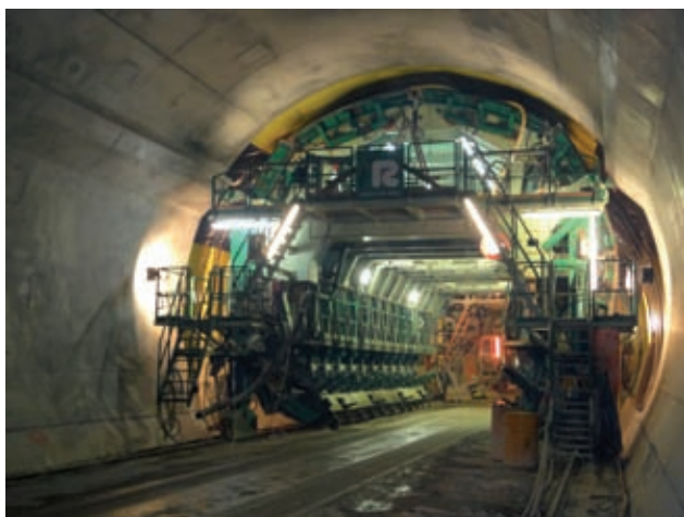
Gewölbeschalwagen Bild: PORR
