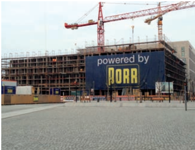
Rohbau Bild: PORR
