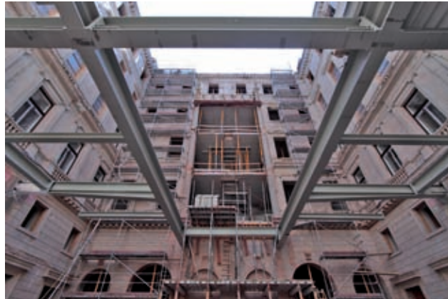
Stahlkonstruktion Innenhofüberdachung inkl. Aufzugsturm Bild: Irene Schanda
