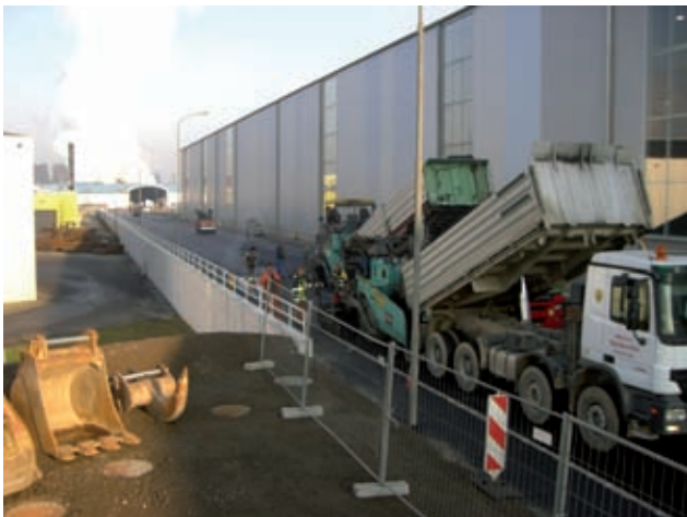
Fertige Stützmauer Bild: PORR
