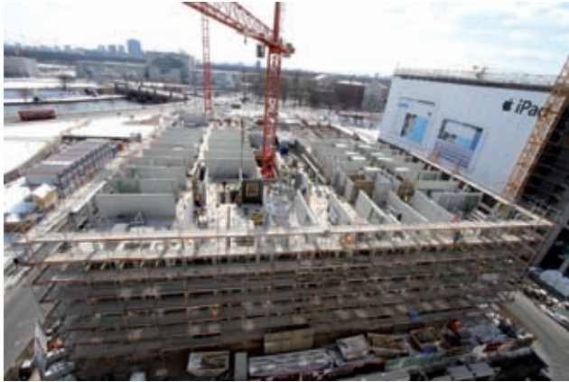
Rohbau Bild: PORR
