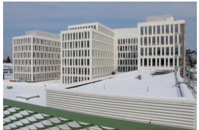
Fertig gestelltes Gebäude Bild: Alu-Sommer
