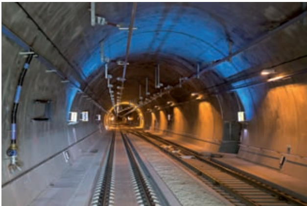
Lainzer Tunnel Überleitstelle Bild: PORR
