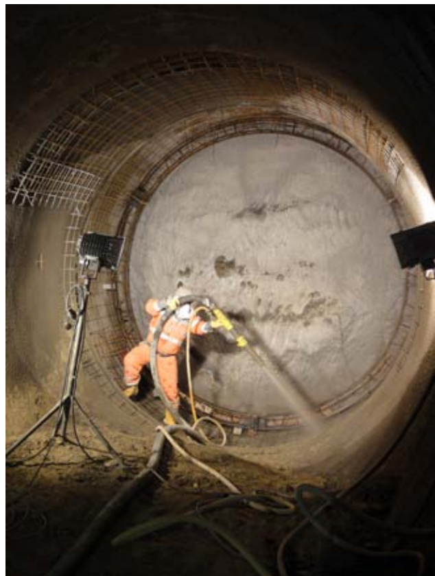
Spritzbetonsicherung – Querschlag unter Vereisung Bild: PORR
