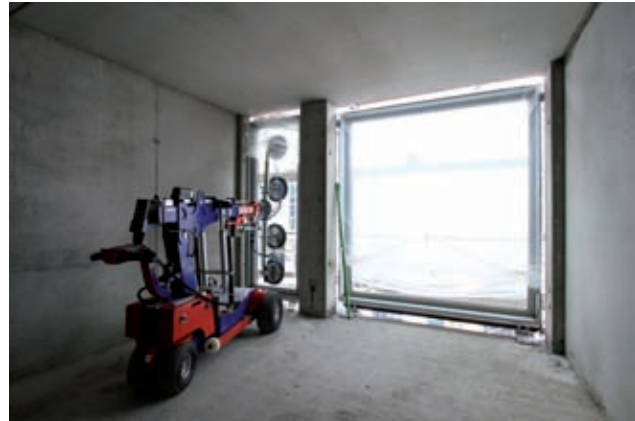
Einbau Fenster Bild: PORR
