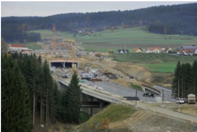
Lärmschutz tunnel beim Baulos 4.1 (Freistadt Süd) Bild: PORR
