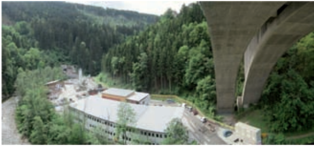
Baustelleneinrichtungsfläche Sillschlucht Bild: PORR
