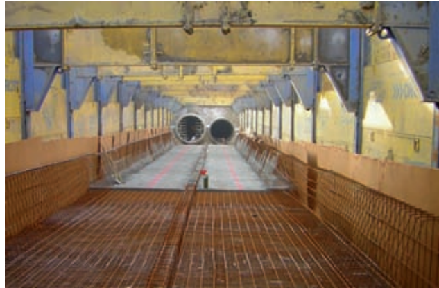
Regelquerschnitt DN2600/DN2200 in MEGA-Doppelgleitschienenverbau Bild: PORR
