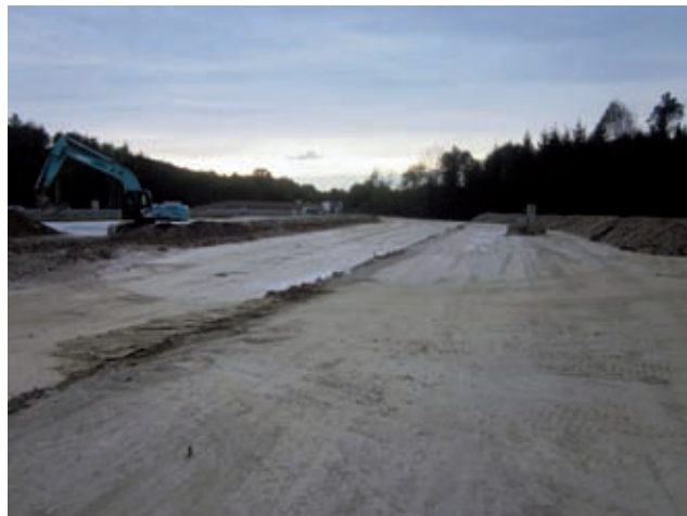
Bodenverbesserung Bild: PORR
