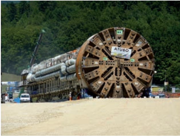
Transfer TVM Röhre Ost Bild: PORR
