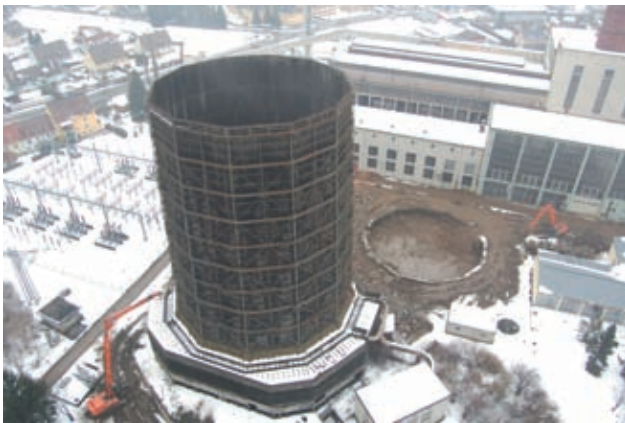
Kühlturmdemontage mit 2 Abbruchbaggern Bild: PORR
