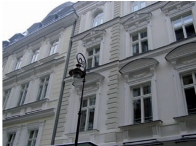
Sorgsam rekonstruierte Fassade Bild: PORR
