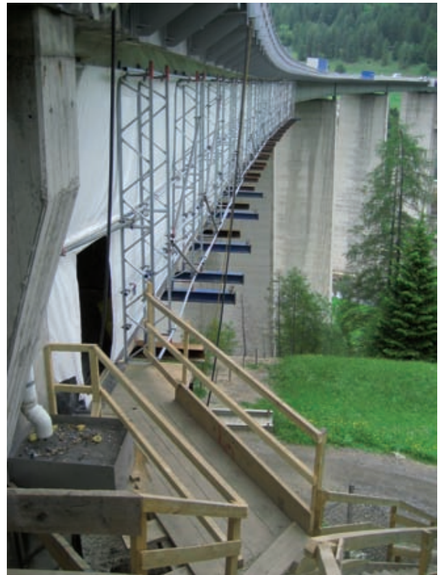
Rüstung Brückenfeld 7 mit Eingangsbereich Bild: PORR
