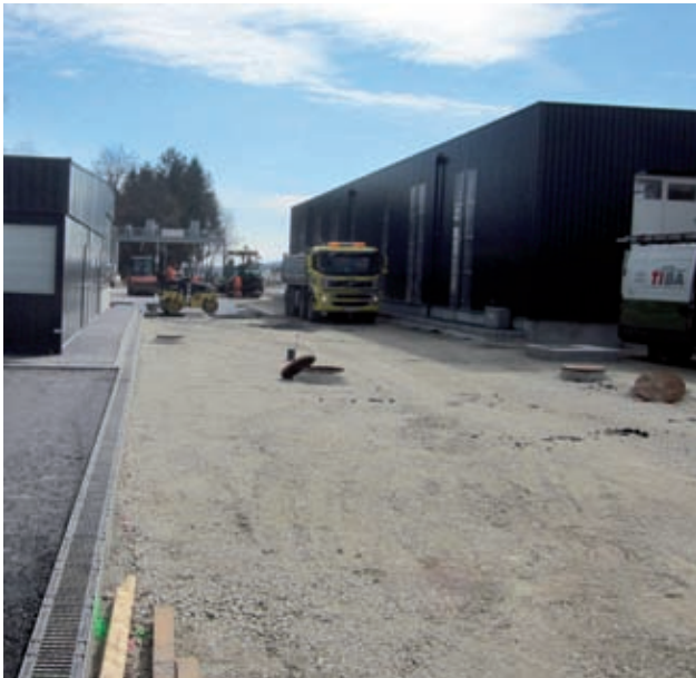
Asphaltierungsarbeiten Bild: PORR
