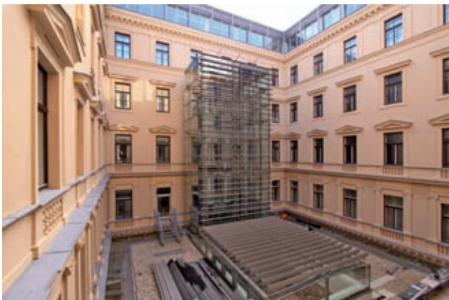
Fassadenansicht – Innenhof inklusive Aufzugsturm Bild: Irene Schanda
