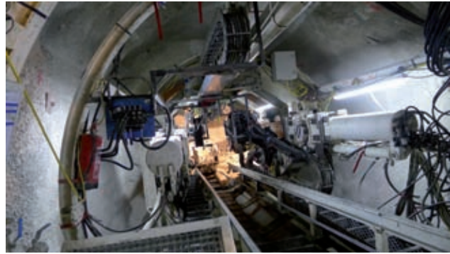
Abbildung 9: Ausbruch Kraftabstieg, Schachtabteufeinheit, 42° Neigung Bild: PORR
