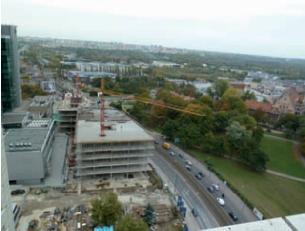
Rohbau Bild: Paweł Młodkowski
