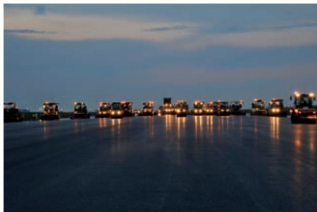
Pistensanierung Flughafen Wien Bild: PORR
