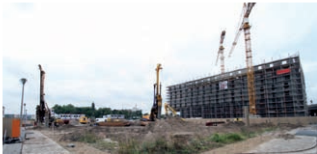
Baugrube Bild: PORR
