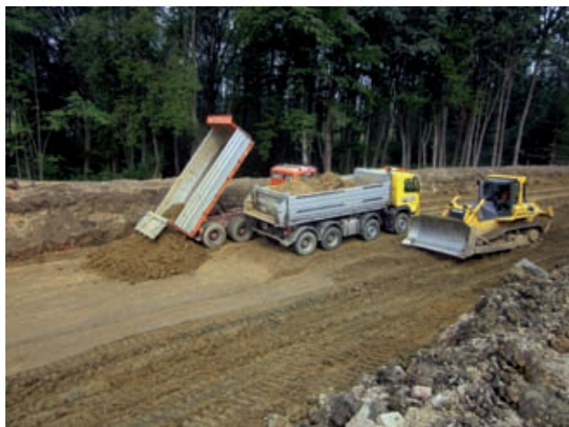
Bodenverbesserung Bild: PORR
