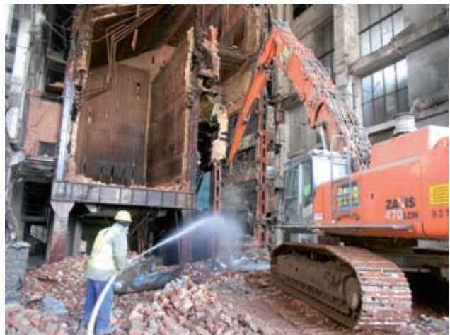
Kesseldemontage mit Staubniederschlagung Bild: PORR
