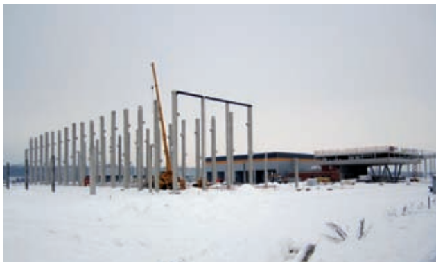
Rohbauarbeiten Zubehörhalle Bild: PORR
