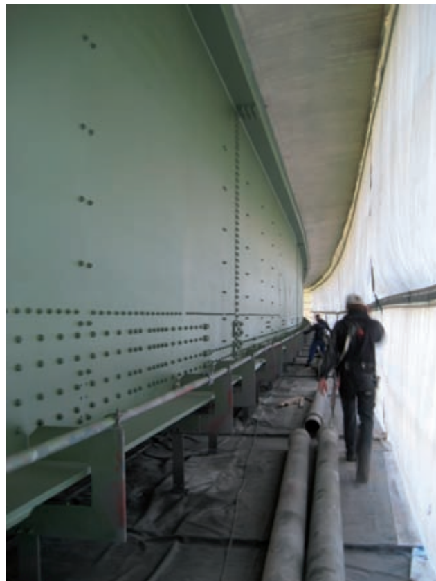
Beschichtungssystem 3 nach letzter Deckschicht Bild: PORR
