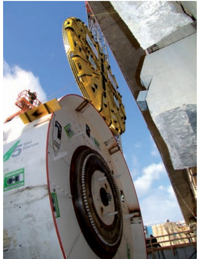
Montage Schneidrad TVM Bild: PORR
