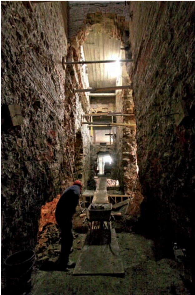
Grabungsarbeiten Durchfahrtsbereich Tiefgarage Bild: Irene Schanda
