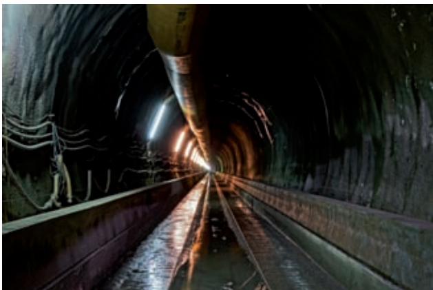
Sohlgerinneherstellung nach vier von fünf Arbeitsschritten Bild: PORR
