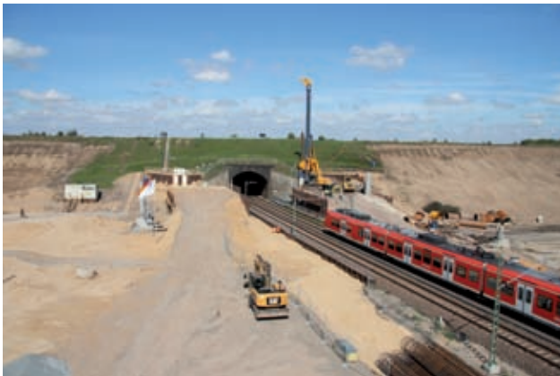
Arbeitsebene mit Herstellung Bohrpfehlwand, Sept. 2010 Bild: PORR
