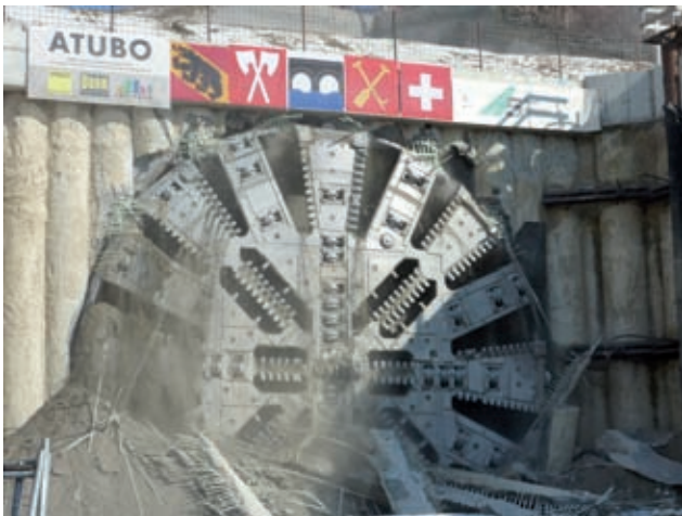
Durchstich Längholtunnel Röhre Ost Bild: PORR
