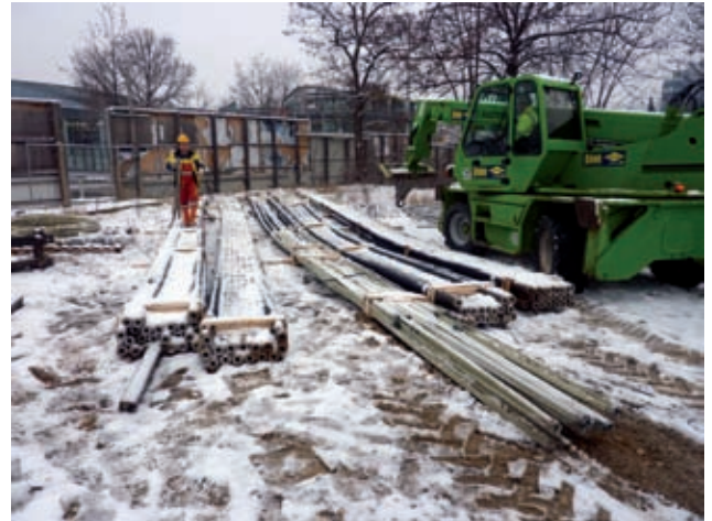
Die GFK-Anker auf der Lagerfläche, Spannköpfe und Freispielstrecken Bild: PORR
