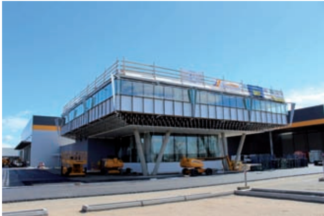
Auskragung Verwaltungsgebäude Bild: PORR
