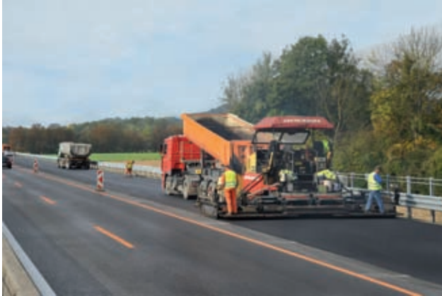
Die TEERAG-ASDAG AG kann sich mit Straßenbau-Expertise erneut durchsetzen. Bild: PORR
