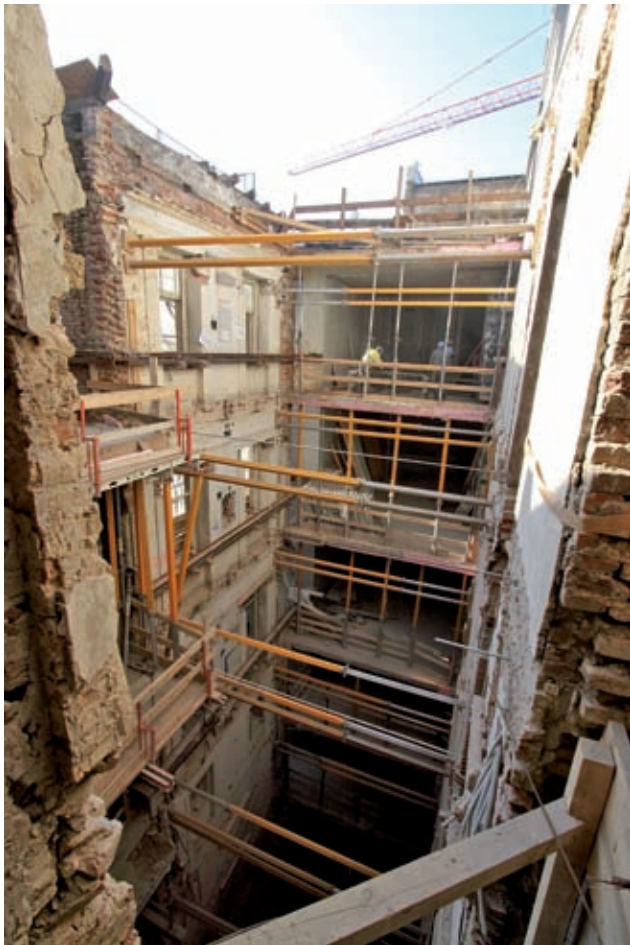
Gebäudesicherung im Bauzustand Bild: Irene Schanda
