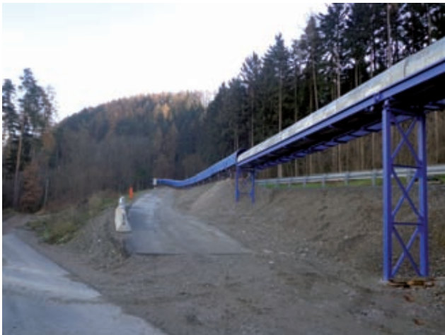
Förderbandkonstruktion Bild: PORR
