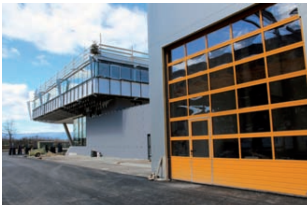
Verwaltungsgebäude und Werkstatt Bild: PORR
