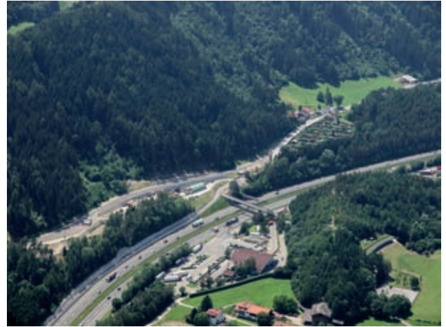
Portal Ampass mit verlegter Landesstraße und Werkstatthalde Bild: PORR
