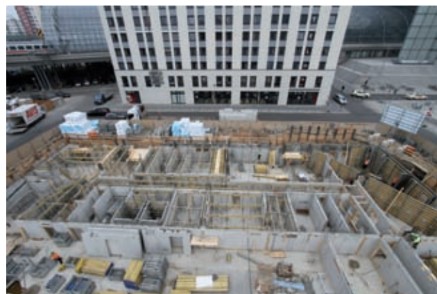
Rohbau Bild: PORR
