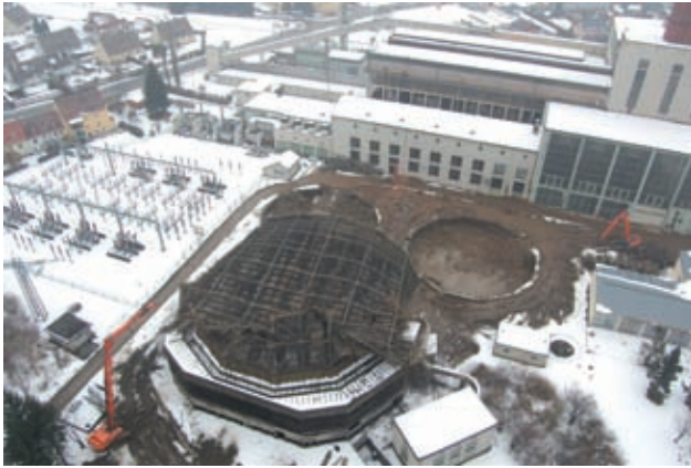
Kühlturmdemontage mit 2 Abbruchbaggern Bild: PORR
