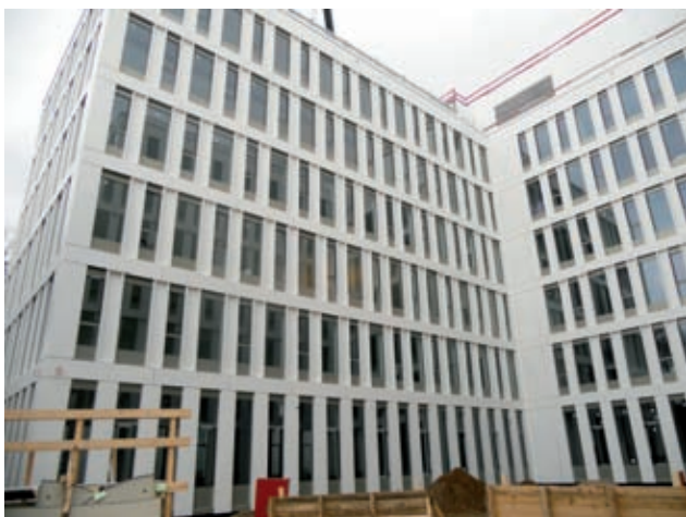
Bauteil Büro, Element- und Blechfassade Bild: Alu-Sommer
