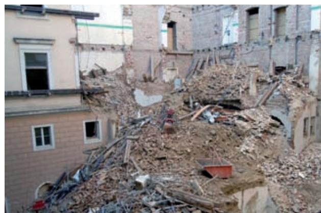
Abbrucharbeiten Innenhof Bild: Irene Schanda
