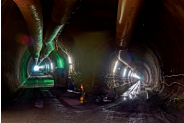
Kreuzungsbereich Erkundungsstollen Innsbruck-Ahrental mit der Verlängerung Nord Bild: PORR
