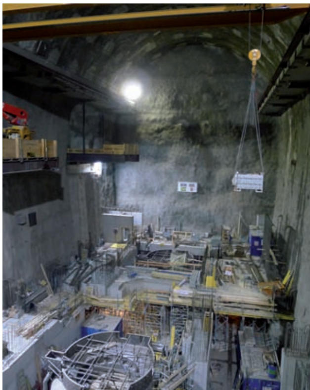
Abbildung 13: Innenausbau Kraftkaverne Bild: PORR
