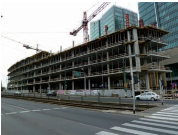
Rohbau Bild: Paweł Młodkowski
