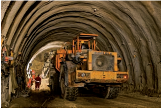
Vortriebsarbeiten Bild: PORR
