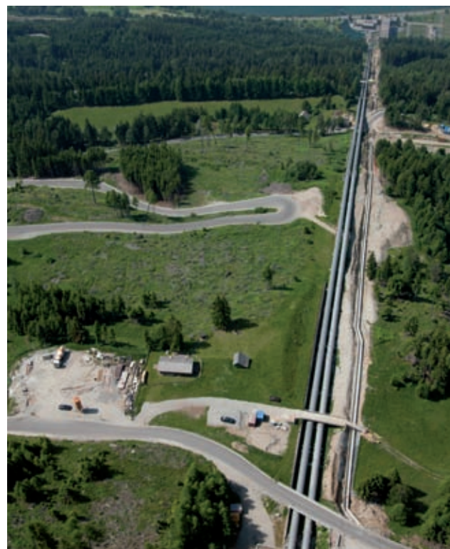
Abbildung 14: Energieableitung entlang der bestehenden Druckrohrleitung, Versorgung über Seilbahn Bild: PORR
