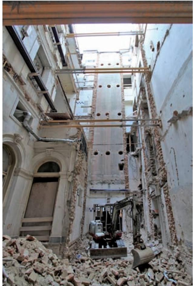
Stiegenhausabbruch Bild: Irene Schanda
