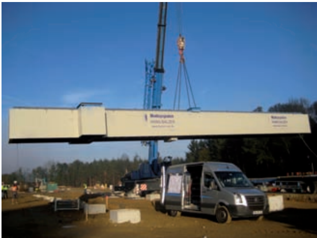
Versetzen Prüfgrube Bild: PORR
