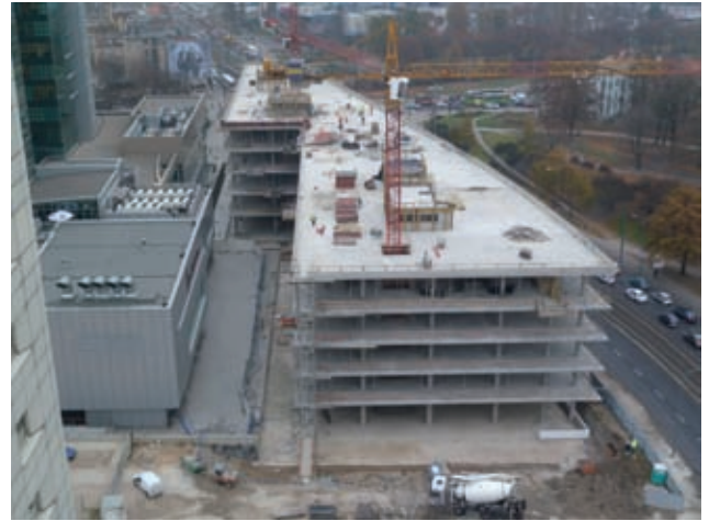
Rohbau Bild: Paweł Młodkowski
