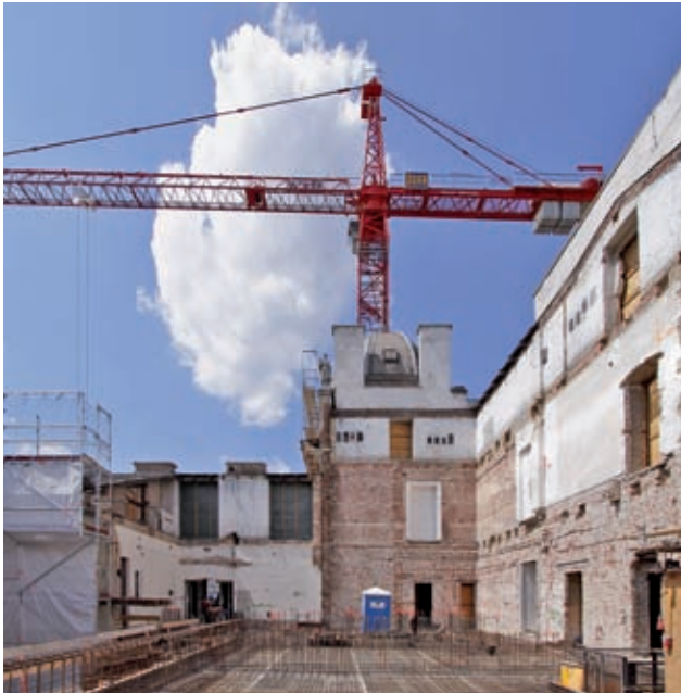
Stahlbetonarbeiten Neubau im Innenhof Bild: Irene Schanda
