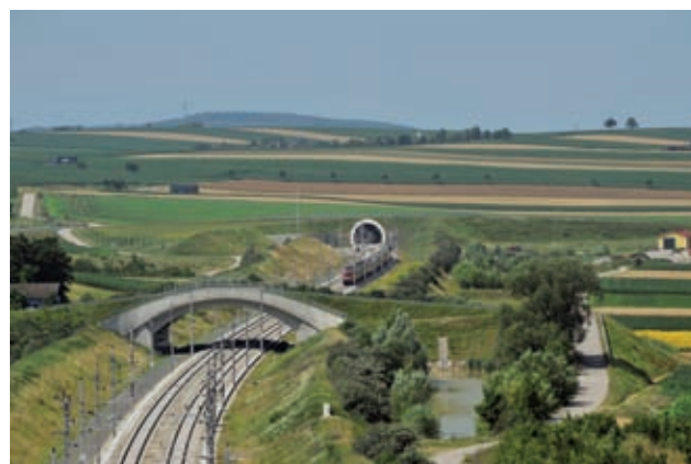
Neubaustrecke Kunstbauten Bild: PORR
