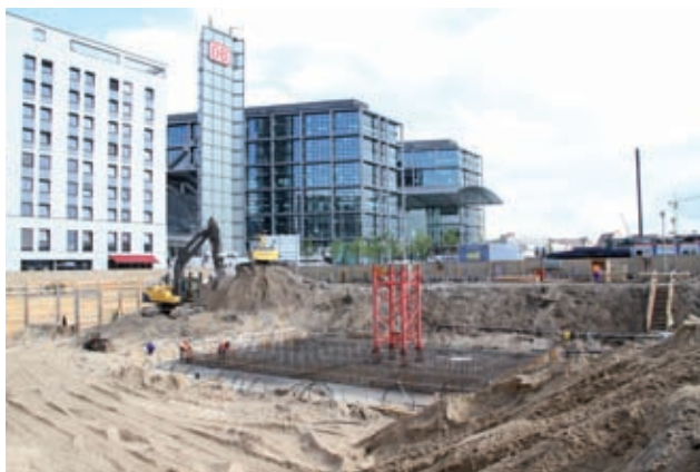
Baugrube Bild: PORR
