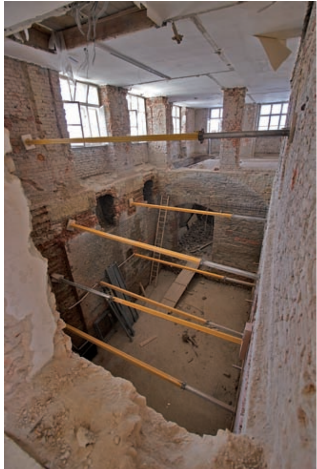
Gebäudesicherung im Bauzustand Bild: Irene Schanda
