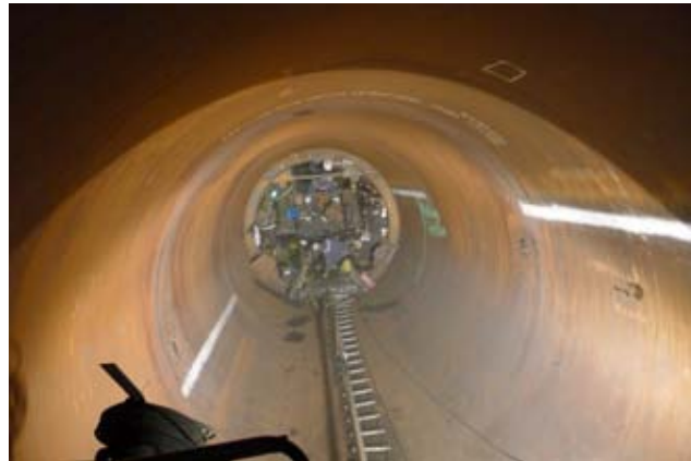
Abbildung 10: Ausbau Kraftabstieg, Innenausbau mit Stahlpanzerung Bild: PORR
