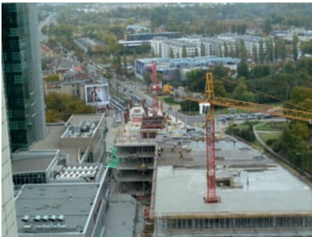
Rohbau Bild: Paweł Młodkowski
