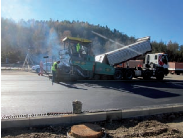
Asphaltierung Bild: PORR
