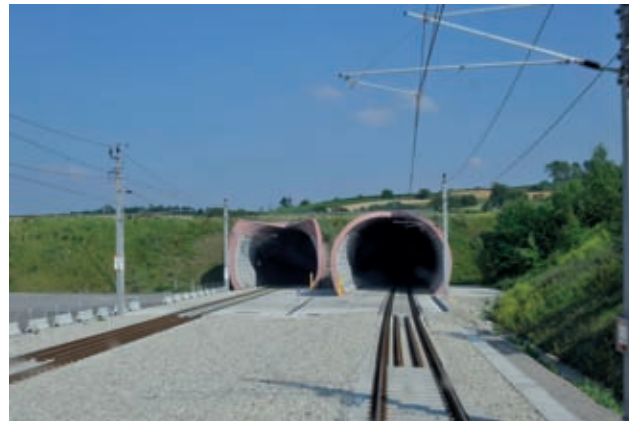
Wienerwald Tunnel West Portal Bild: PORR
