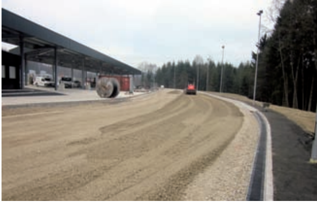
Ungebundene obere Tragschicht mit Flugdach Bild: PORR
