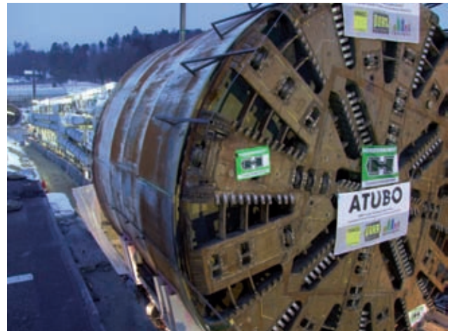
Transfer TVM Röhre West Bild: PORR
