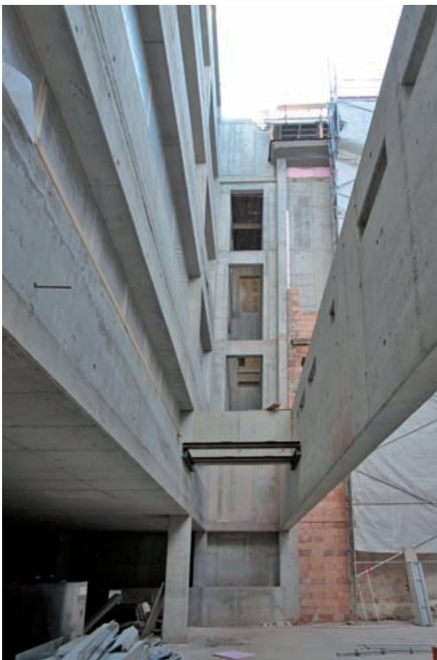
Stahlbetontragwerk Neubau Innenhof Bild: Irene Schanda
