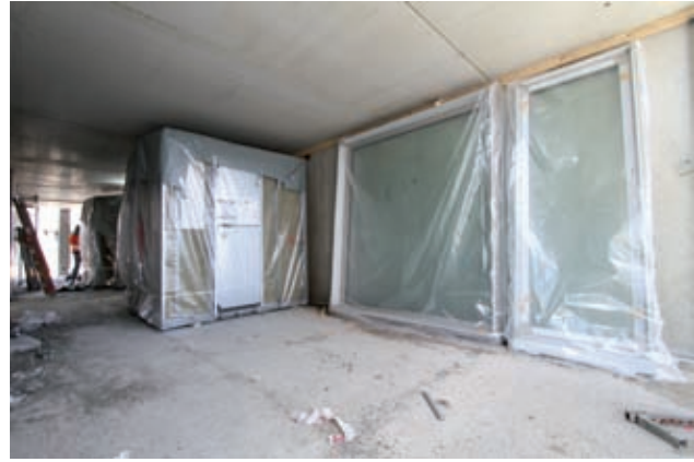
Einbau Fenster Bild: PORR
