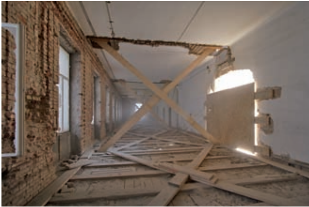
Gebäudesicherung im Bauzustand Bild: Irene Schanda
