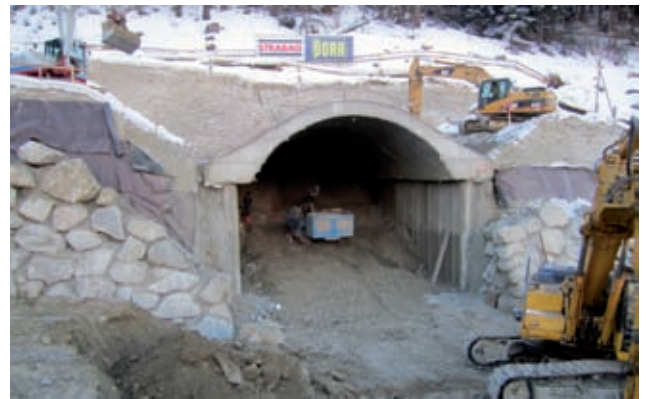
Deckelbauweise und Bohrpfähle beim Portal Ampass Bild: PORR
