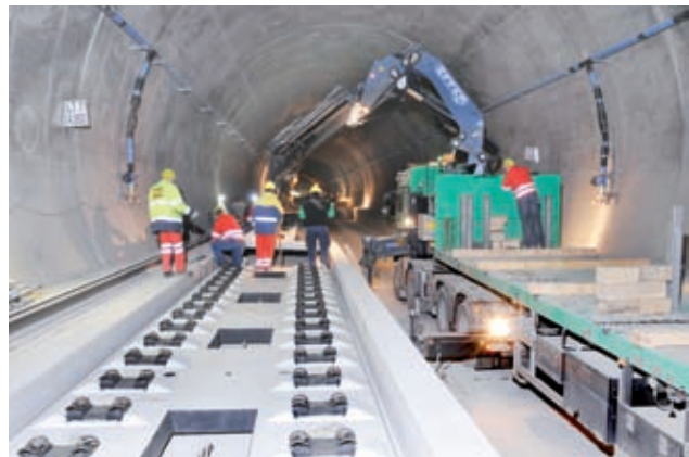
Verlegung Gleistragplatten Bild: PORR
