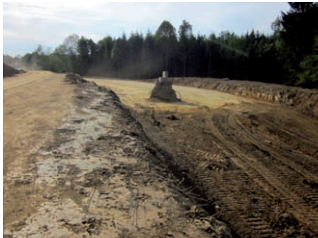
Bodenverbesserung Bild: PORR
