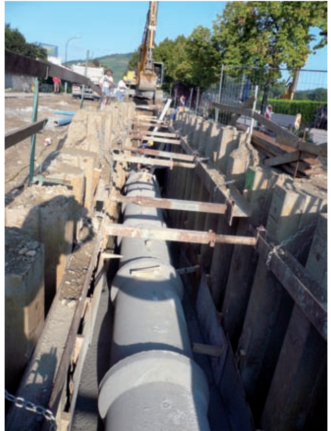
Künette mit Spundwänden und Unterwasserbetonplombe für Rohrverlegung im Grundwasser Bild: PORR
