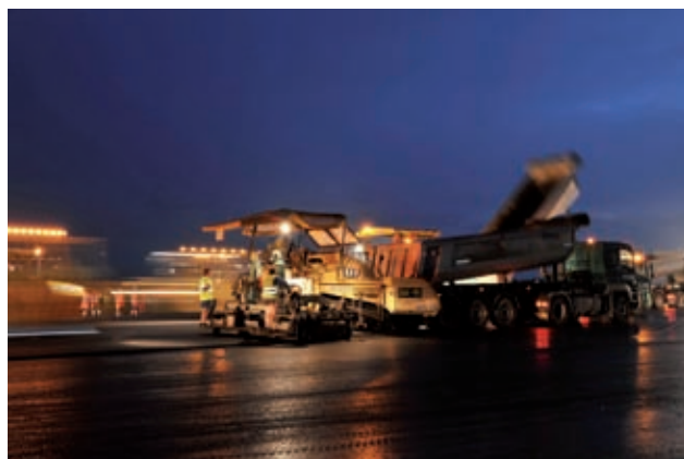
Pistensanierung Flughafen Wien Bild: PORR
