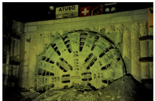
Durchstich Längholztunnel Röhre West Bild: PORR
