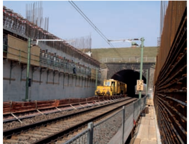
Rahmenstiele 1. Bauabschnitt mit Verschiebbahn, März 2011 Bild: PORR
