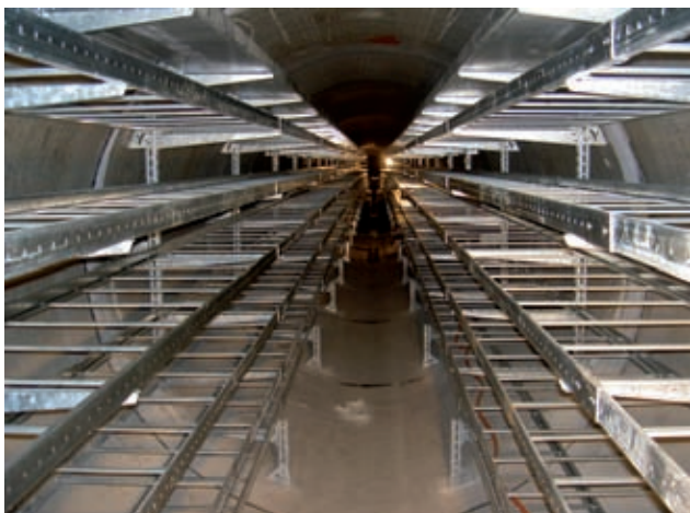
Innenleben des 30 kV E-Kollektors DN2600 Bild: PORR
