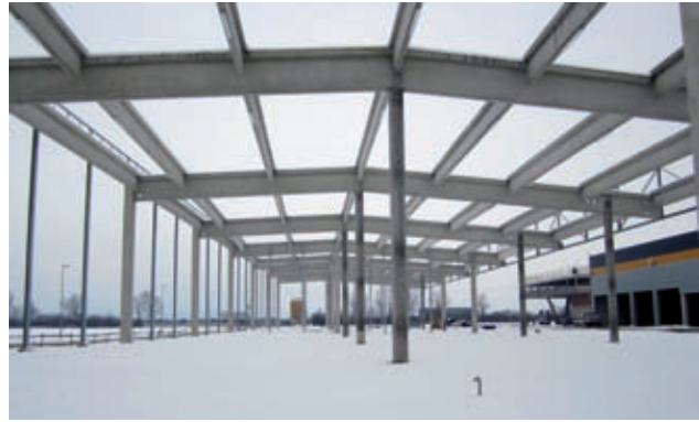
Tragwerk Halle C Bild: PORR
