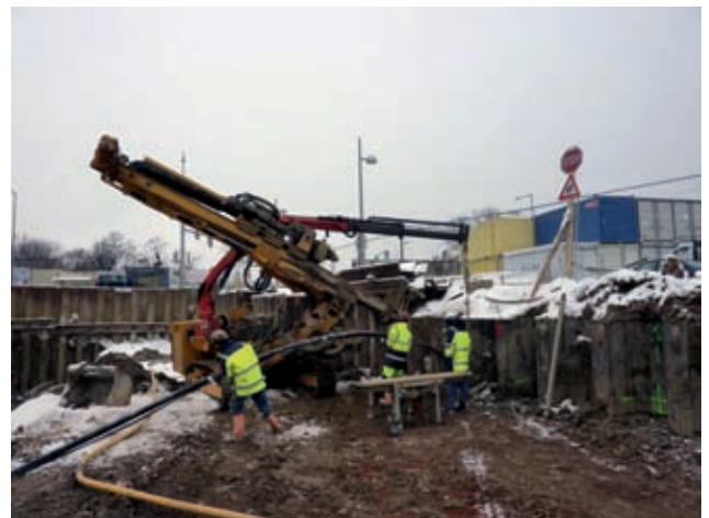
Einbau des Ankers in die fertig gestellte Bohrung Bild: PORR
