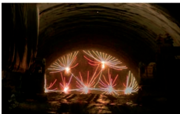
Sprengung einer Ortsbrust Bild: PORR
