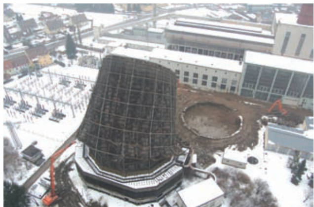
Kühlturmdemontage mit 2 Abbruchbaggern Bild: PORR
