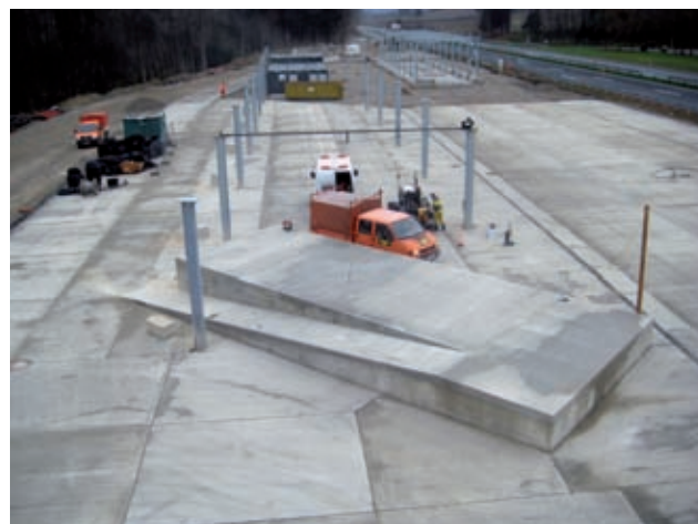
Baufeld Bild: PORR
