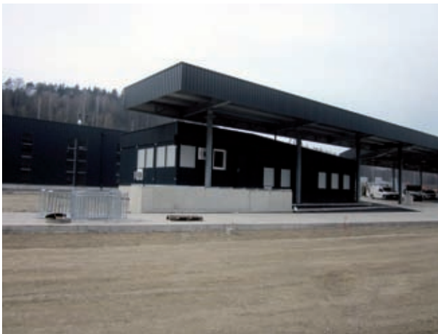
Betriebsgebäude mit Flugdach Bild: PORR
