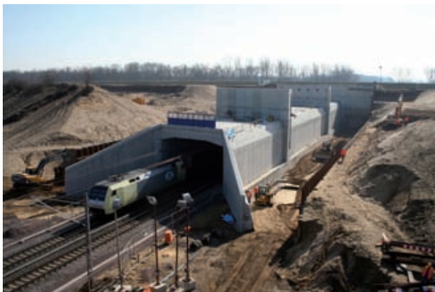
Baugrube und Rahmenbauwerk des 2. Bauabschnitts, März 2013 Bild: PORR
