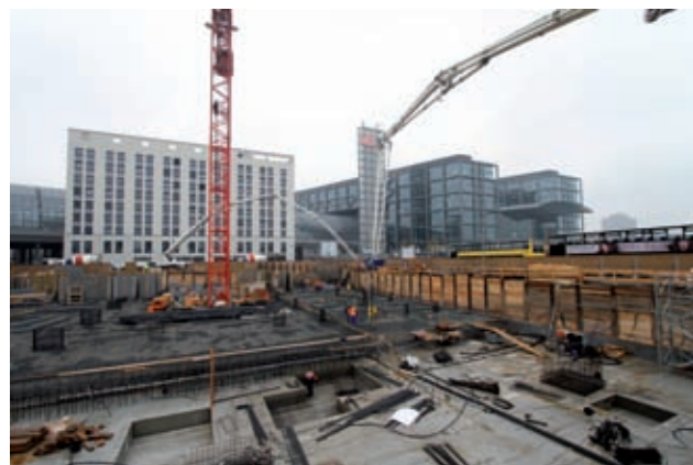
Rohbau Bild: PORR
