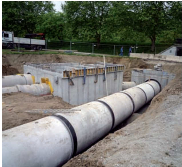
Stark bewehrte Druckrohre im Muffenbereich mit Stahlring verstärkt Bild: PORR
