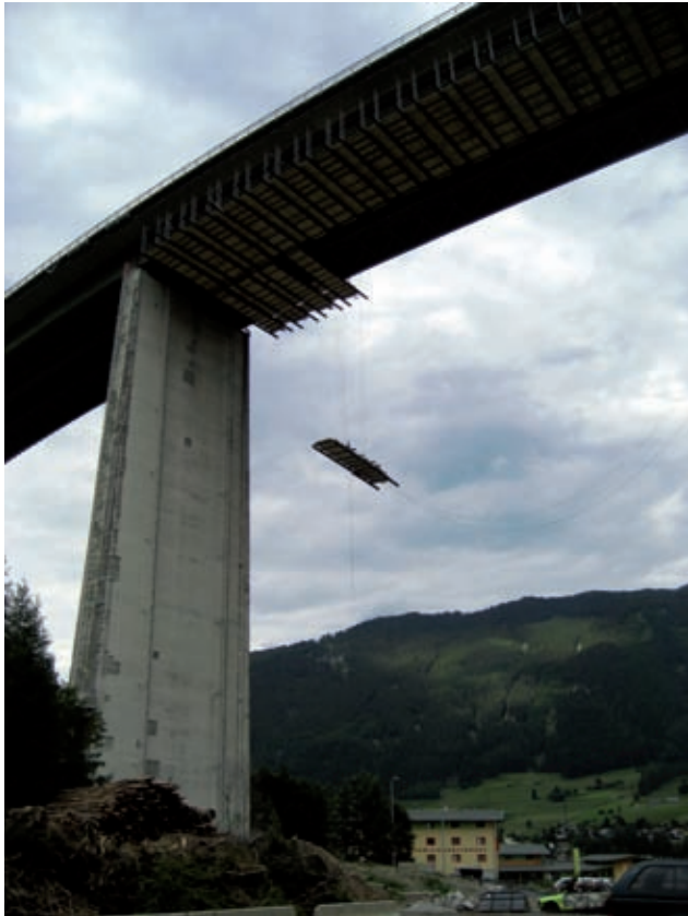
Rüstungsarbeiten Brückenfeld 4 Bild: PORR
