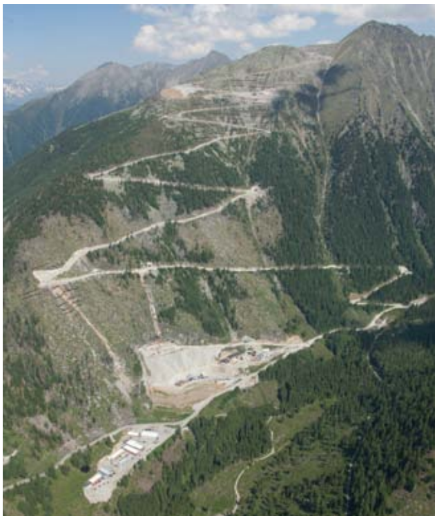
Abbildung 2: Hauptbaustelleneinrichtung im Mühldorfer-Graben, Aufschließungsstraße Schoberboden Bild: PORR
