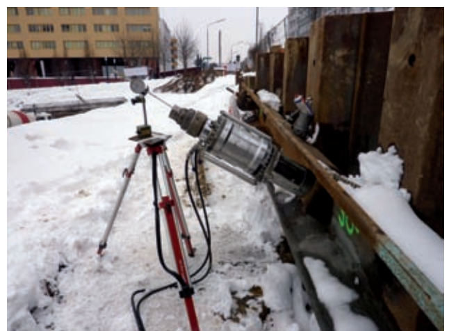
Das Spannen des Ankers erfolgt mit einer Standard-Spannpresse und kurzen Stab-Spannstählen, die beim Rückbau des Ankerkopfes problemlos ausgebaut werden können. Bild: PORR
