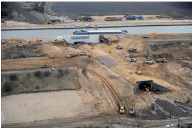
Abbruch Bestandtunnel, März 2012 Bild: J. Bunte
