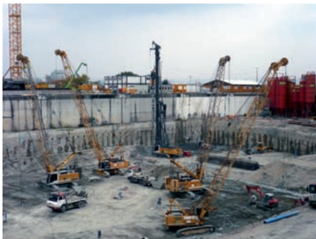
Geballter Maschineneinsatz für die Herstellung der bis zu 40 m tiefen Schlitzwandbarrette des Donau-City Tower 1 Bild: PORR
