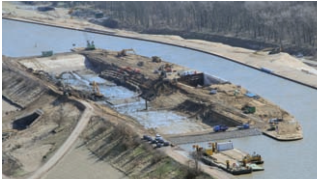
Bodenrückbau zum Abbruch des Bestandtunnels, März 2012 Bild: J. Bunte
