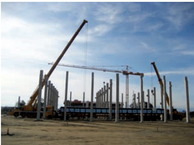
Verheben der Montagegruben Bild: PORR
