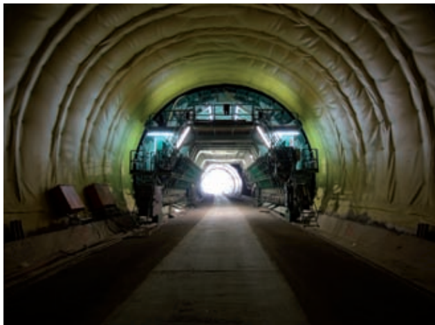
Gewölbeschalwagen Bild: PORR
