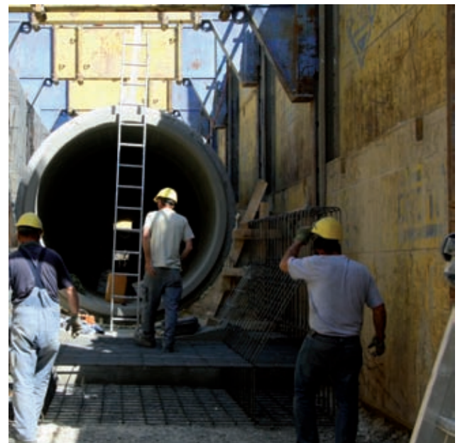
Regelquerschnitt DN2400 in MEGA-Doppelgleitschienenverbau Bild: PORR
