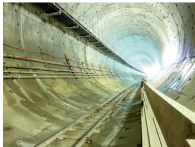
Tunnelröhre mit Tübbingschale Bild: PORR
