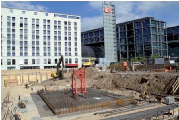
Baugrube Bild: PORR
