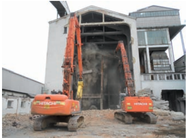
Kesseldemontage Kesselhaus Block 1 und 2 Bild: PORR
