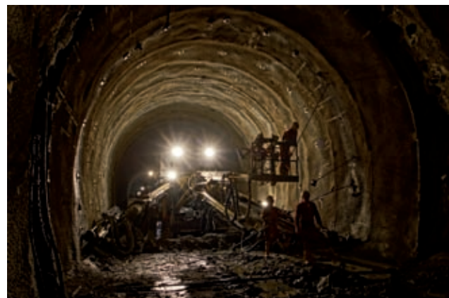
Ankerungsarbeiten Bild: PORR
