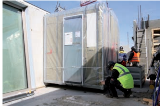
Einbau Fertigbadzellen
