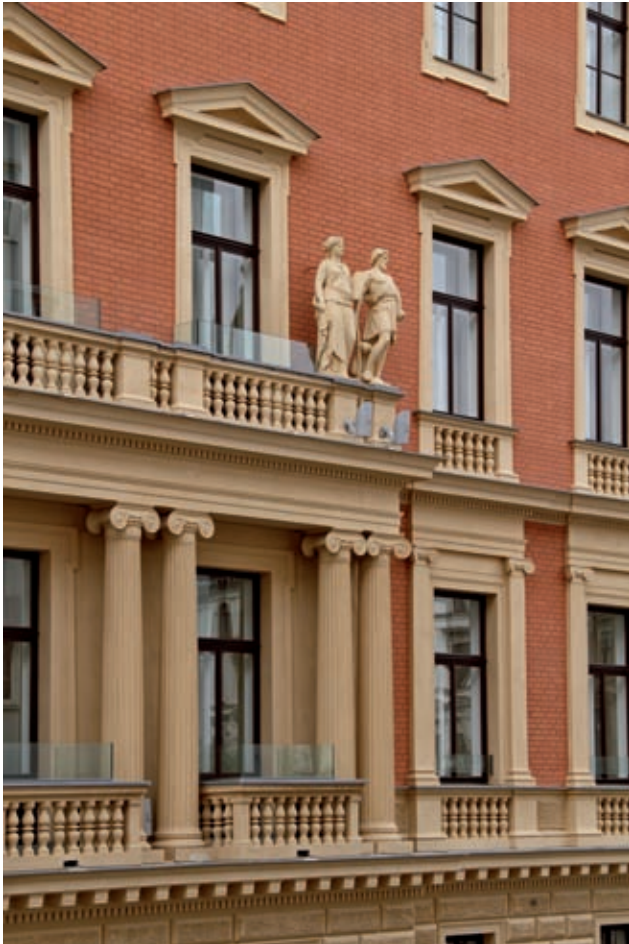
Ansicht Hauptfassade, Balkon inklusive Figuren Bild: Irene Schanda
