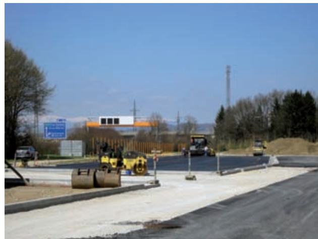
Außenanlagen Bild: PORR
