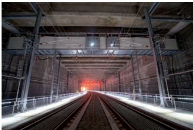
Lainzer Tunnel Bild: PORR
