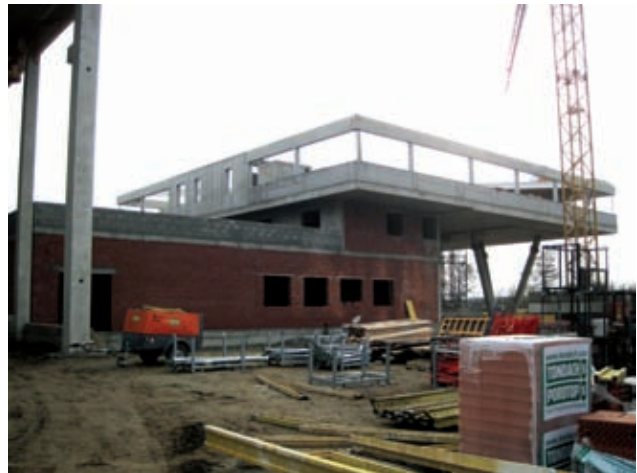
Rohbau Verwaltungsgebäude Bild: PORR
