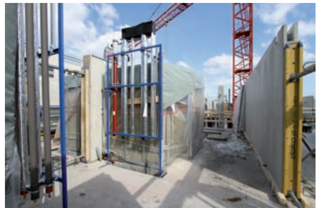
Einbau Fertigbadzellen
