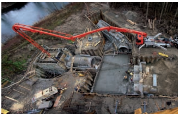
Dükerbauwerk und Verteilbauwerk Bild: PORR
