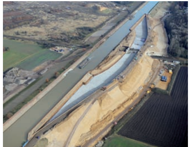
Tunnel 1. Bauabschnitt vor der Flutung, Nov. 2011 Bild: J. Bunte
