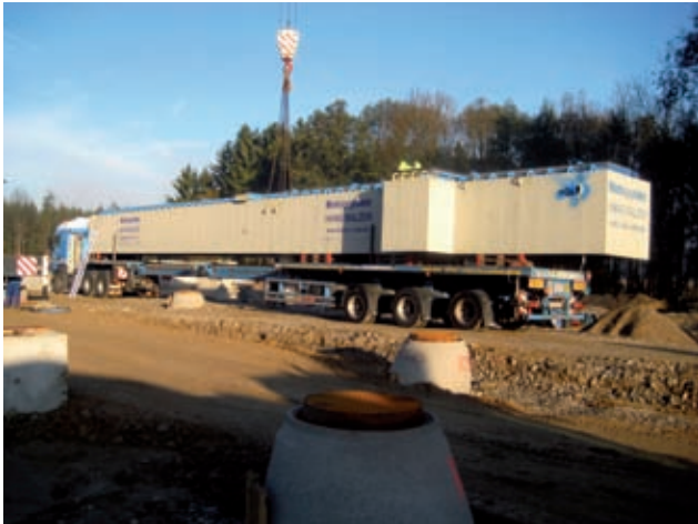
Versetzen Prüfgrube Bild: PORR
