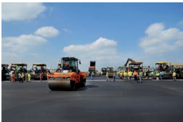
Pistensanierung Flughafen Wien Bild: PORR
