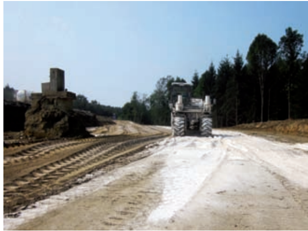
Bodenverbesserung Bild: PORR
