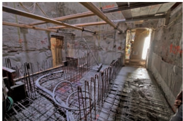
Stahlbetonarbeiten im Gebäudeinneren Bild: Irene Schanda
