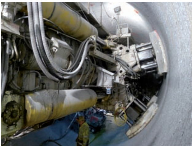
Abbildung 5: Maschineller Vortrieb Druckstollen, Vorschubzylinder (gelb) und Verspannung (Gripper) Bild: PORR
