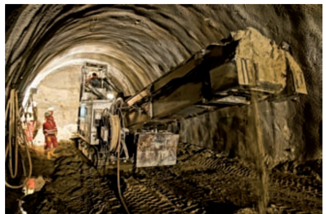
Tunnelvortriebsmaschine ITC 312 im Einsatz Bild: PORR
