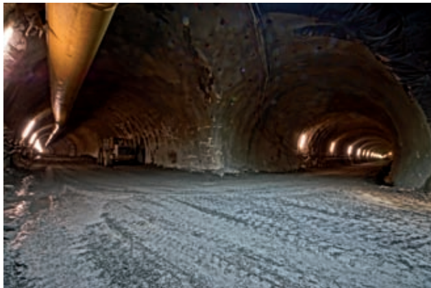
Kreuzungsbereich Zufahrtstunnel Ahrental und Erkundungsstollen Bild: PORR
