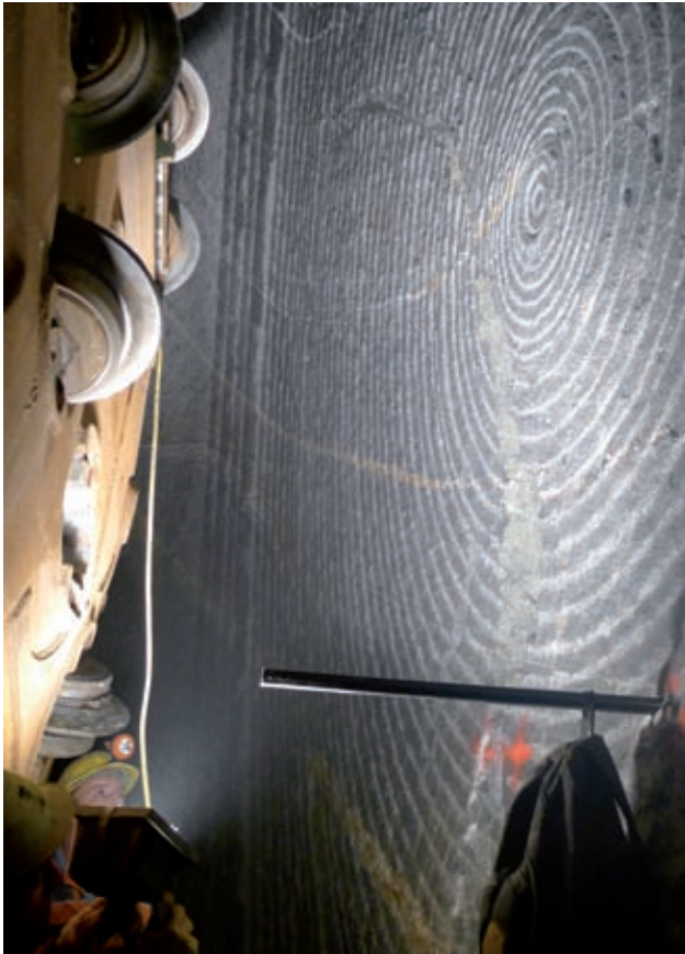
Abbildung 4: Maschineller Vortrieb Druckstollen, Meißelspuren an der Ortsbrust Bild: PORR
