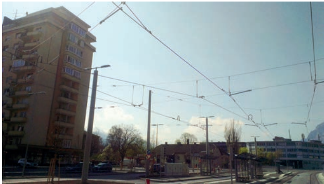
Betonmaste und neue Oberleitung Bild: PORR
