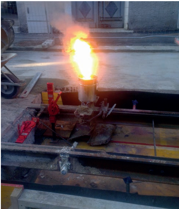
Verschweißen der Gleisstöße Bild: PORR
