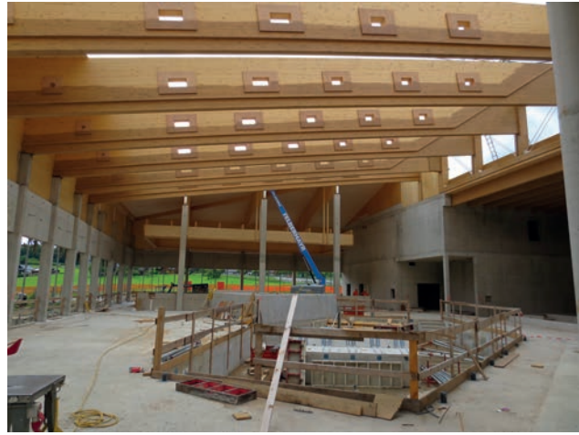
Hallendachkonstruktion Badehalle Bild: PORR
