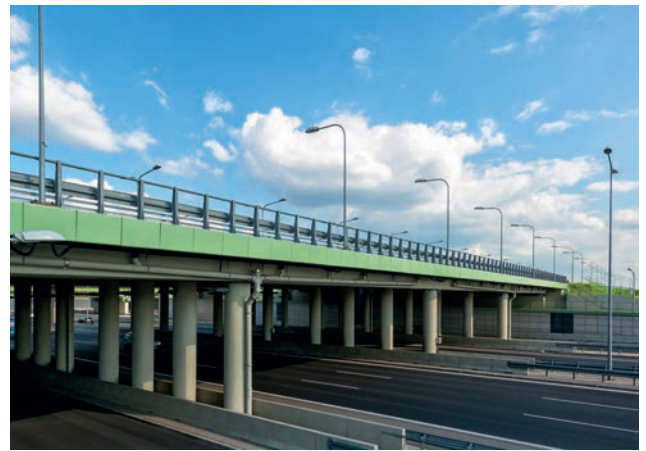
Dichtwanne und Objekte WD-19B und WD-19C Bild: PORR
