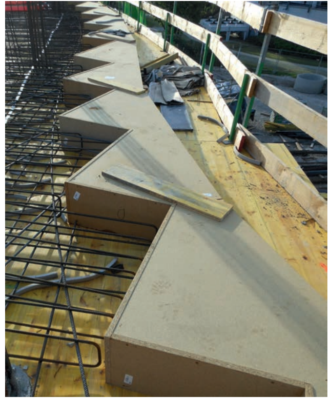
Außenkontur Rohbaudecke Bild: ALU-SOMMER
