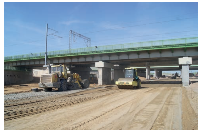
Stabilisierung des Grundes mit dem Zement in der Dichtwanne – im Hintergrund Bahnüberführungen Bild: PORR
