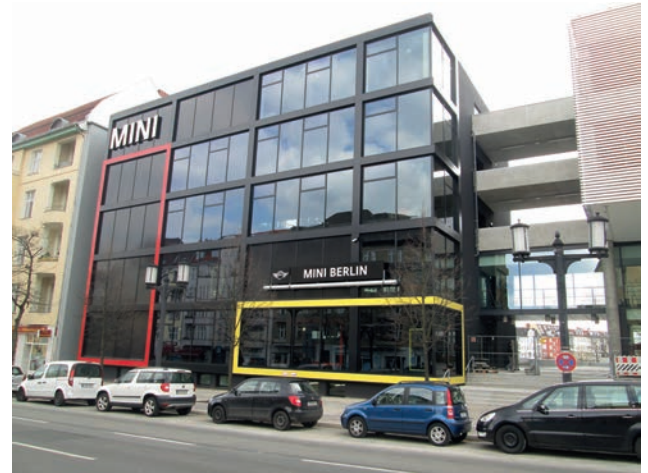
MINI Kubus Bild: PORR
