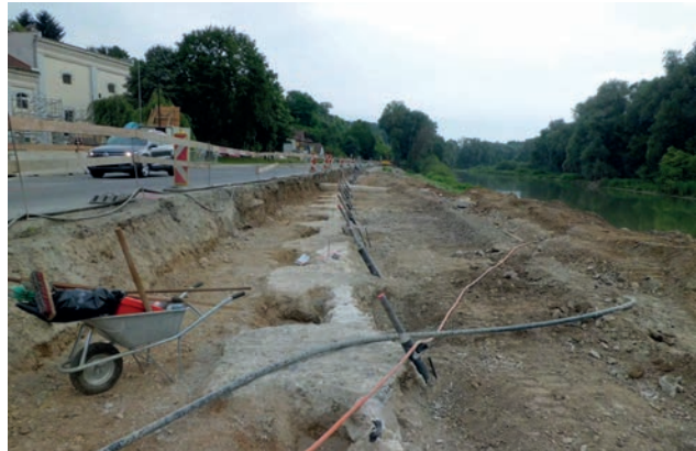
Freigelegte Untergrundabdichtung mit GEWI-Pfählen Bild: PORR
