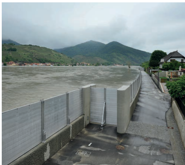
Bereits realisiertes Projekt: Hochwasserschutz Rossatz Bild: PORR
