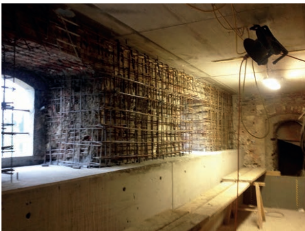
Bewehrungsarbeiten im Gebäudeinneren Bild: PORR
