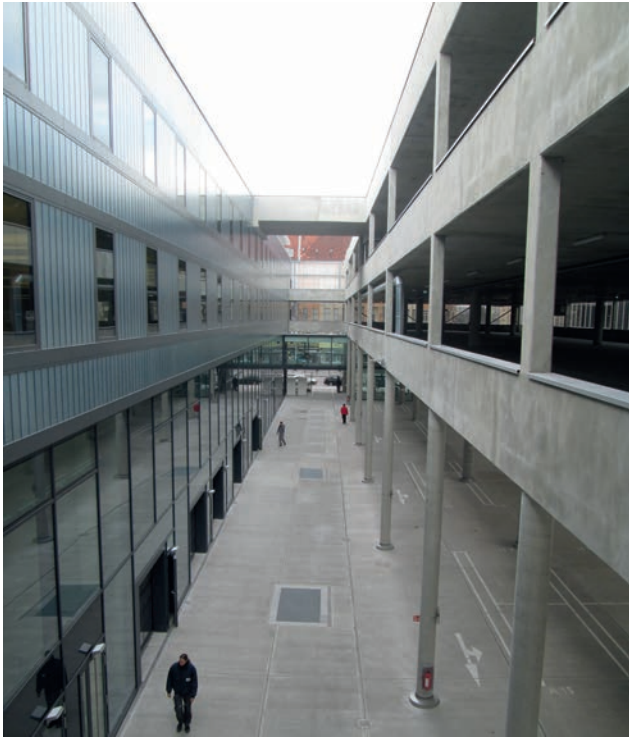
Lichthof zwischen Ausstellungsgebäude und Parkhaus Bild: PORR
