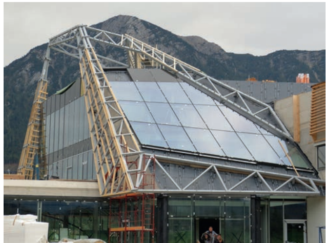
Montage Turm Bild: PORR
