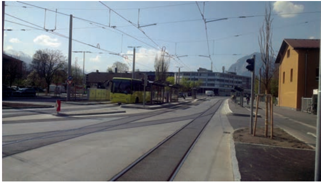
Haltestellenbereiche mit Wetterschutzeinrichtungen Bild: PORR
