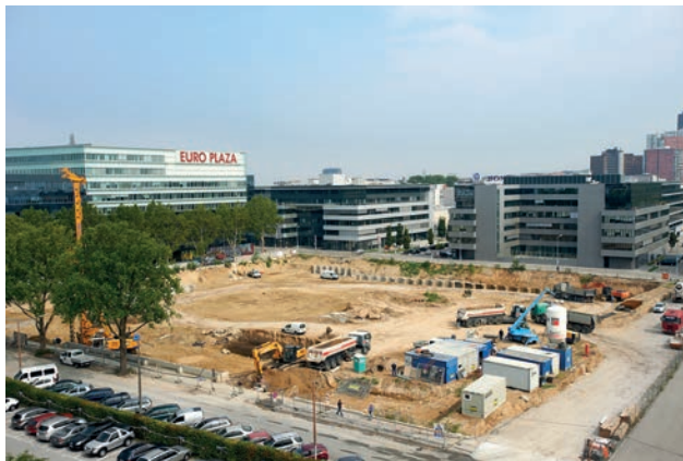
Voraushub und Baugrubensicherung mittels SOB-Pfählen. Bild: Toni Rappersberger
