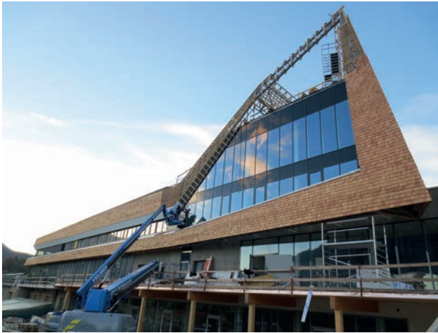
Montage Turm Bild: PORR
