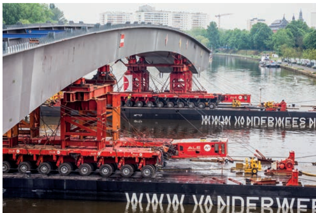
Einschwimmen der Carl-Ulrich-Brücke Bild: PORR
