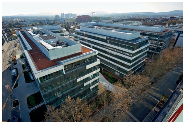
Dachdraufsicht BT J; BT I; BT H samt Schallschutzeinhausungen Bild: Toni Rappersberger
