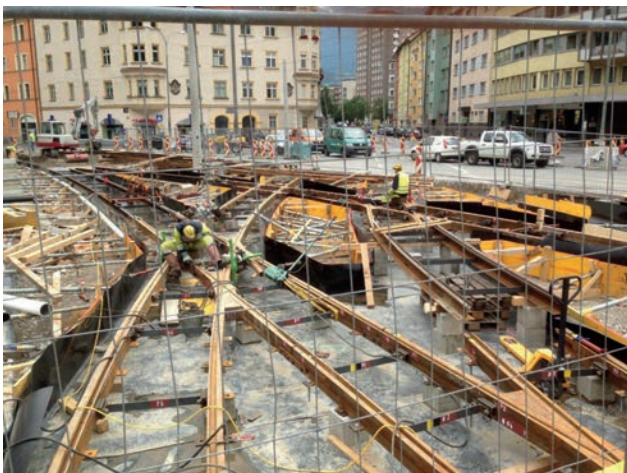
Gleisknoten Leipzigerplatz Kreuzung Amraserstraße/Defreggerstraße Bild: PORR
