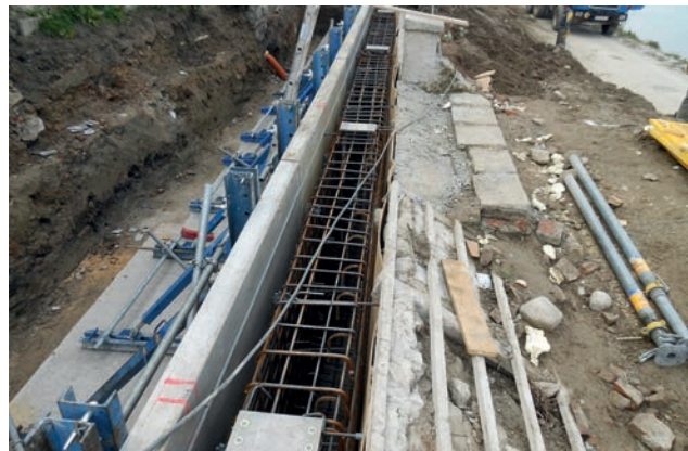
Fertig versetzte Ankerplatten vor den Betonierarbeiten Bild: PORR
