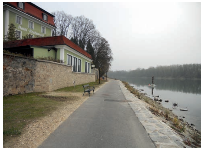
Wiederhergestellte historische Stadtmauer Bild: PORR
