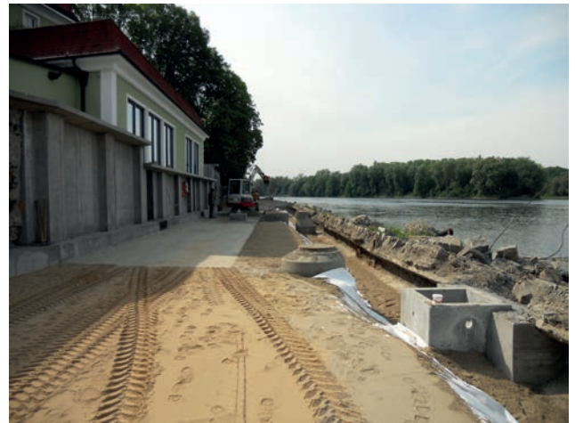
Vorgemauertes Granitsteinmauerwerk Bild: PORR
