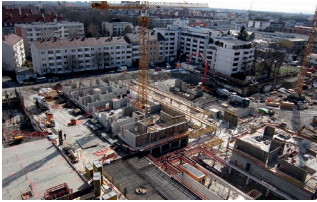
Am Westpark – Rohbau 2 Bild: PORR
