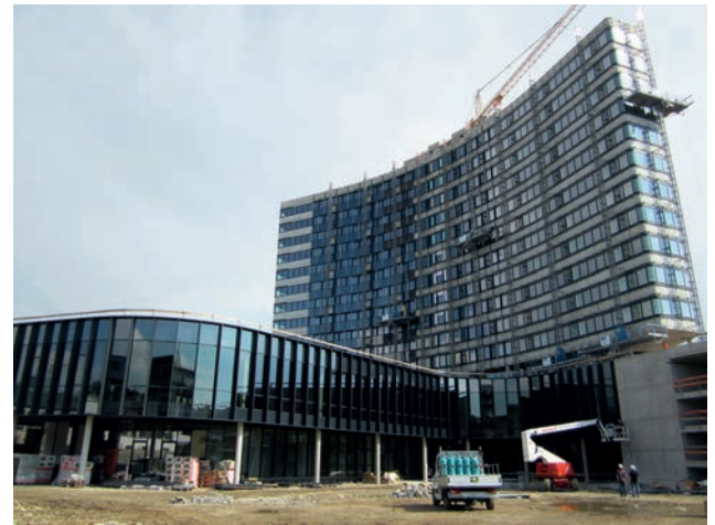
Fassadenarbeiten mit Mastbühnen Bild: PORR
