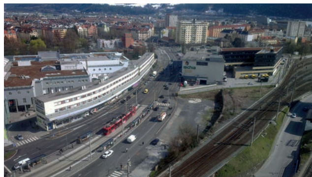
Straßenzug nach Beendigung der Arbeiten Bild: PORR
