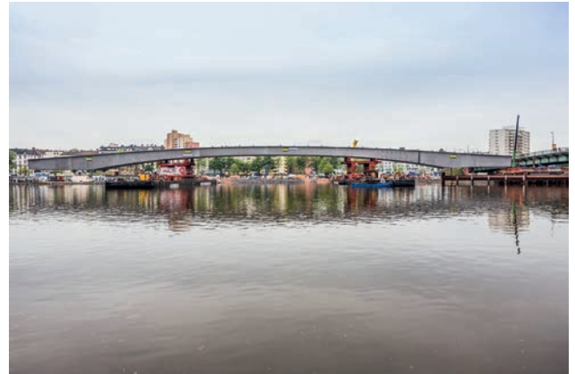
Einschwimmen der Carl-Ulrich-Brücke Bild: PORR
