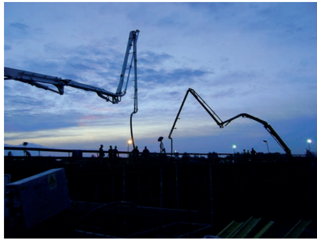
Betonieren der Tragkonstruktion WD-20 Bild: PORR
