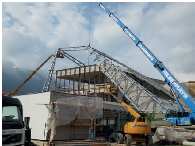
Montage Turm Bild: PORR
