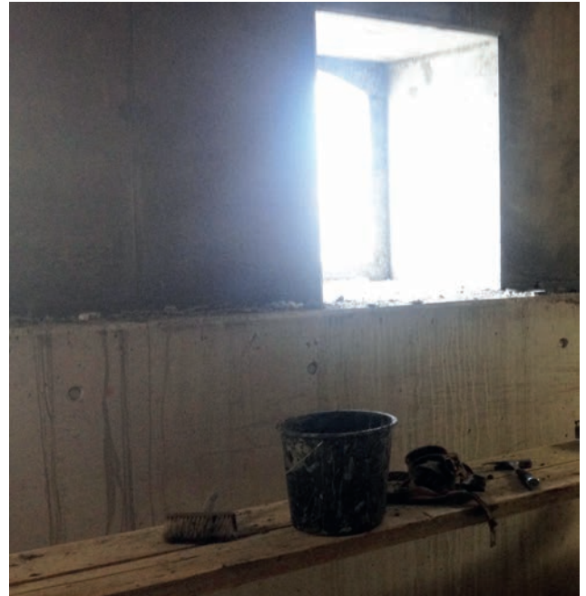
Sichtbetonwand mit SCC-Beton Bild: PORR
