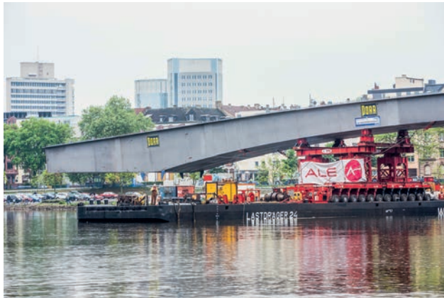
Einschwimmen der Carl-Ulrich-Brücke Bild: PORR
