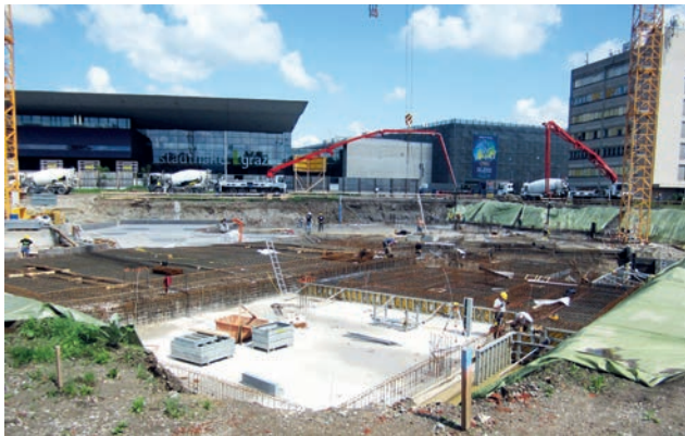
Baugrube mit Bodenplatte und im Hintergrund „Braune Wanne“ Bild: PORR
