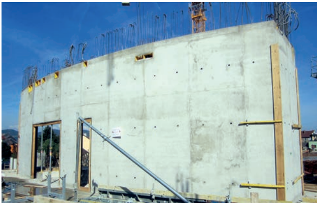
Teile der Sichtbetonwand Bild: PORR
