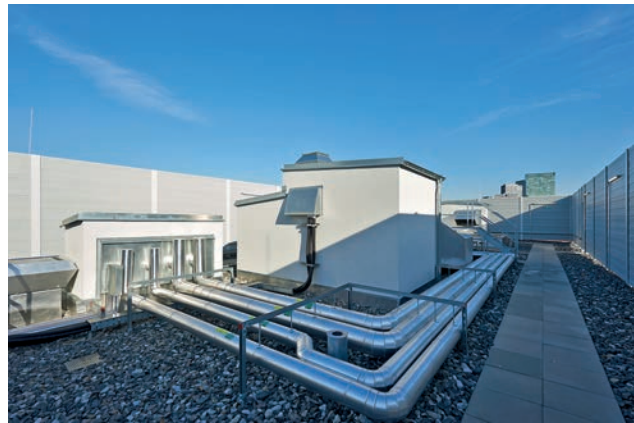
Versorgungsleitungen und Anbindungen am Dach BT J Bild: Toni Rappersberger
