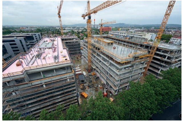
Stahlstützenmontage und Umkehrdachausbildung Bild: Toni Rappersberger
