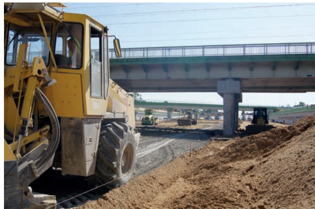
Zementstabilisierung des Untergrundes in der Dichtwanne Bild: PORR
