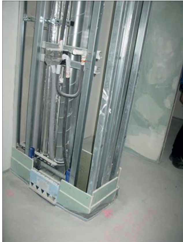
Versorgungsstrang mit bodengleichem Einlauf Bild: PORR
