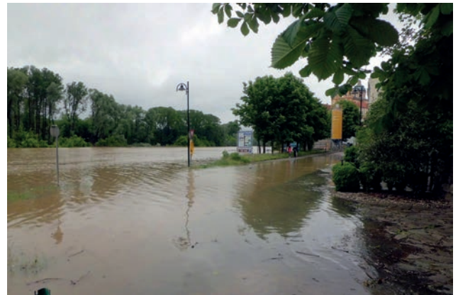
Gefluteter Baubereich Bild: PORR
