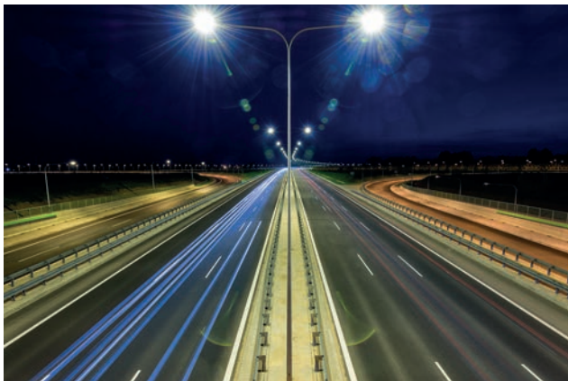
S2 – Richtung Westen bei Nacht Bild: PORR
