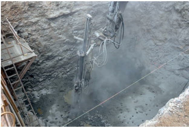
Vorbohren für den Einsatz von Treibmitteln Bild: PORR
