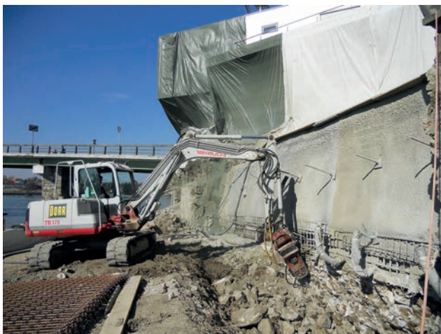
Abtrag Granitmauer und gleichzeitige Herstellung Spritzbetonwand Bild: PORR
