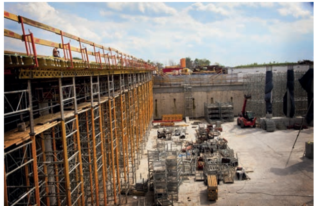
Hohe Stütze des Objektes WD-20 in der Wanne Bild: PORR
