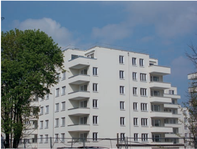
Am Westpark – Fassade 1 Bild: PORR
