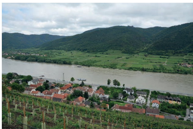
Bereits realisiertes Projekt: Hochwasserschutz Spitz an der Donau Bild: PORR
