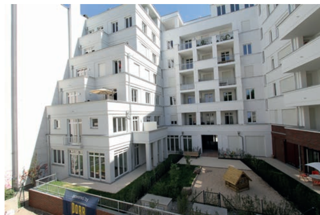
Fassade Hofseite Bild: PORR
