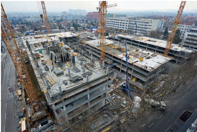
Beton- und Stahlbetonarbeiten in den Obergeschossen Bild: Toni Rappersberger
