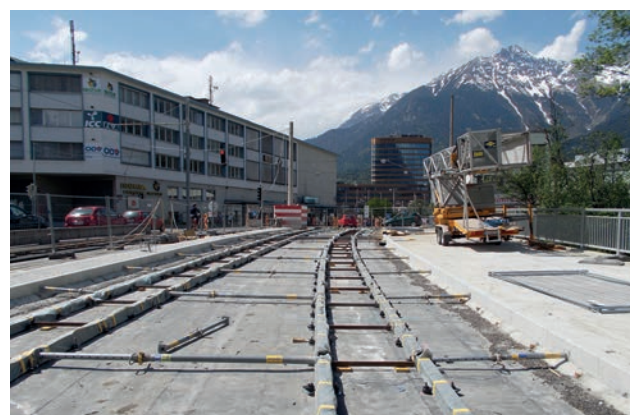
Gleisbefestigung und -umwicklung auf der Brücke Bild: PORR
