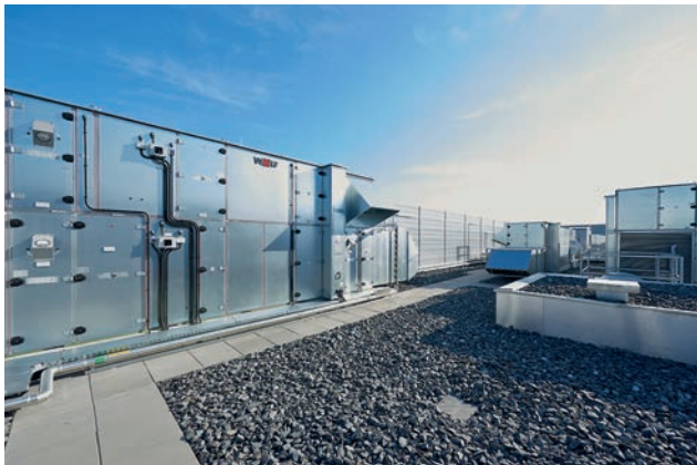
Lüftungsanlagen am Dach BT J Bild: Toni Rappersberger
