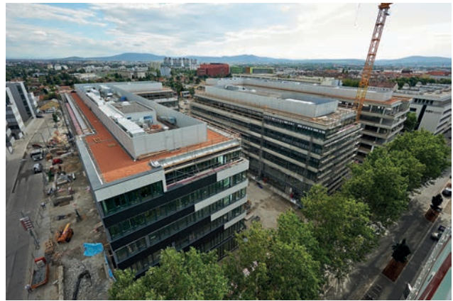
Fertigstellung der Dachlandschaft Bild: Toni Rappersberger
