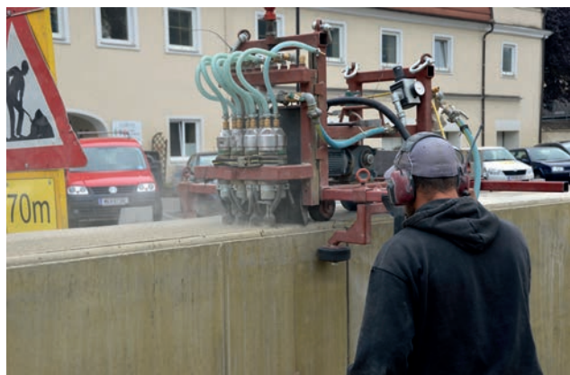
Stocken der Mauerkrone Bild: PORR
