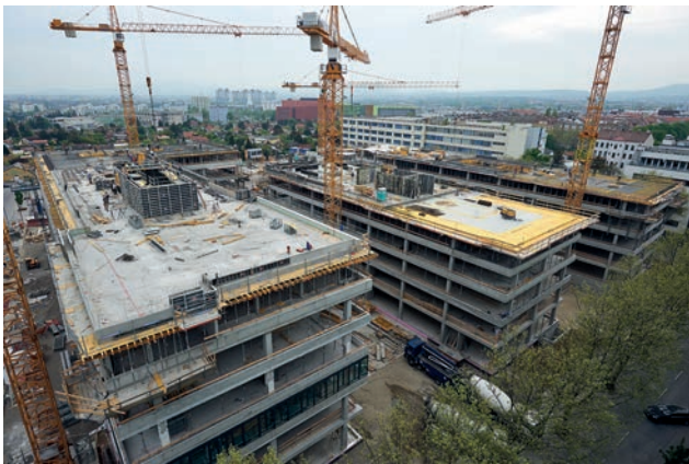
Zügiger Fortschritt in den letzten Geschossen Bild: Toni Rappersberger
