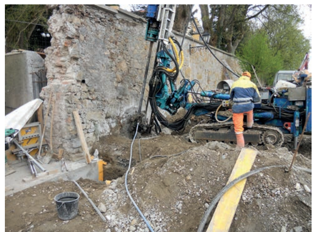
Untergrundabdichtung unter der Stadtmauer mittels Düsenstrahlverfahren (DSV) Bild: PORR
