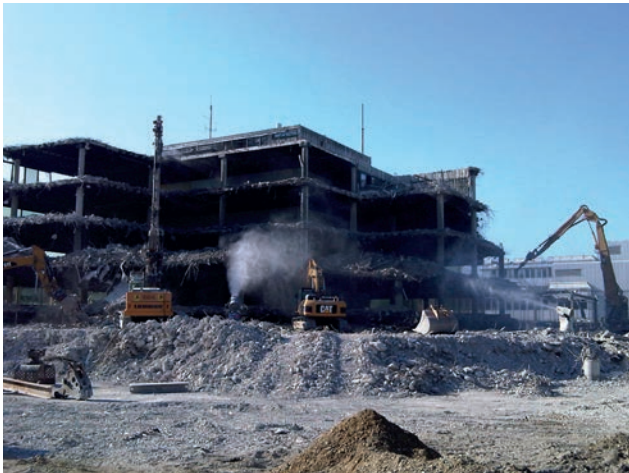
Am Westpark – Abbruch Bestand 1 Bild: PORR
