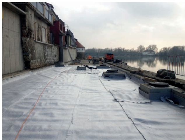
Verlegte Folie mit Drainagematte im Polder 1 Bild: PORR
