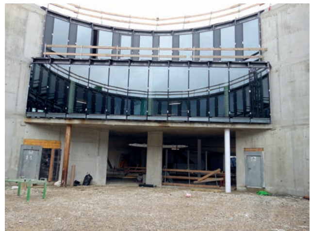
P/R-Fassade in Elementbauweise im Innenhof (18.12.2012) Bild: ALU-SOMMER
