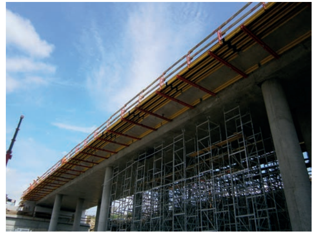
Schalung der Kappen/Randwege WD-20 Bild: PORR
