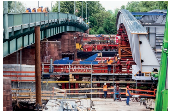
Einschwimmen der Carl-Ulrich-Brücke Bild: PORR
