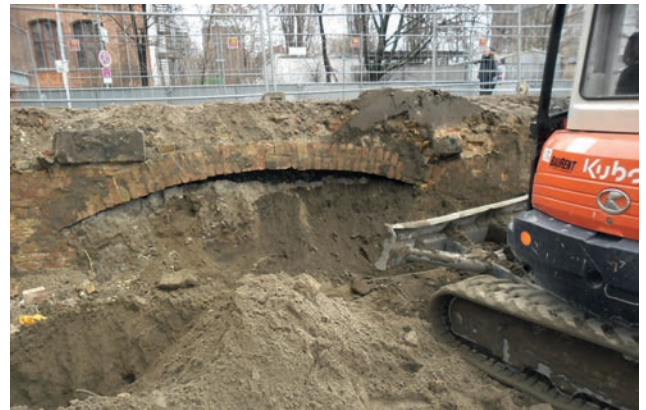
Baugrube Bild: PORR
