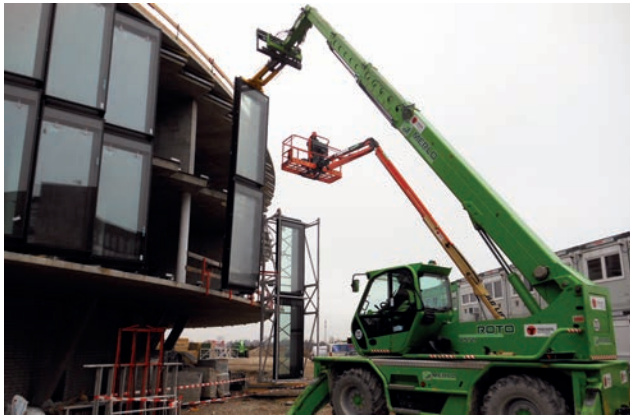
Montage Zackenfassade (22.11.2012) Bild: ALU-SOMMER
