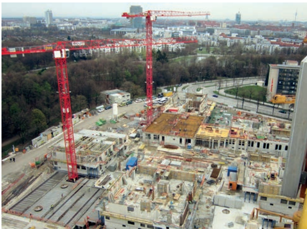
Am Westpark – Rohbau 1 Bild: PORR
