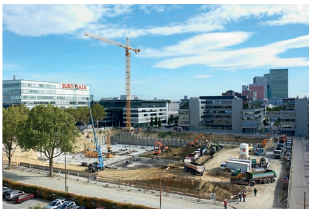
Erste Bodenplattenabschnitte und Erdaushub Bild: Toni Rappersberger
