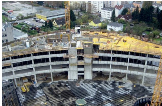
Die zwei Bauabschnitte des Regelgeschosses Bild: PORR
