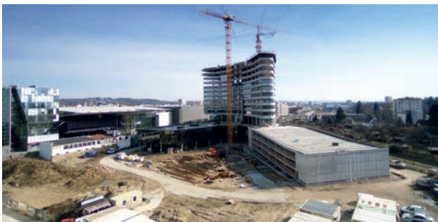
Gleichzeitigkeit der Rohbau- und Fassadenarbeiten Bild: http://smc.netzcam.net
