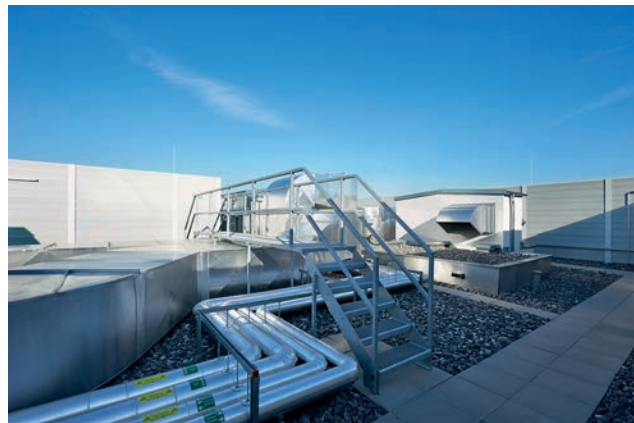
Wartungsstege über Haustechnikleitungen am Dach BT J Bild: Toni Rappersberger
