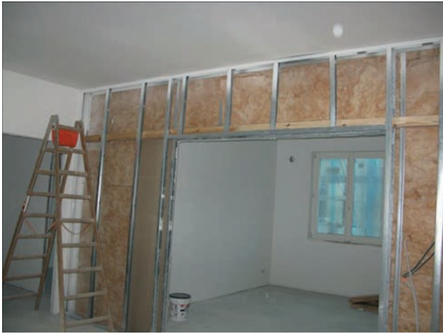
Sturzhöhenänderung Bild: PORR
