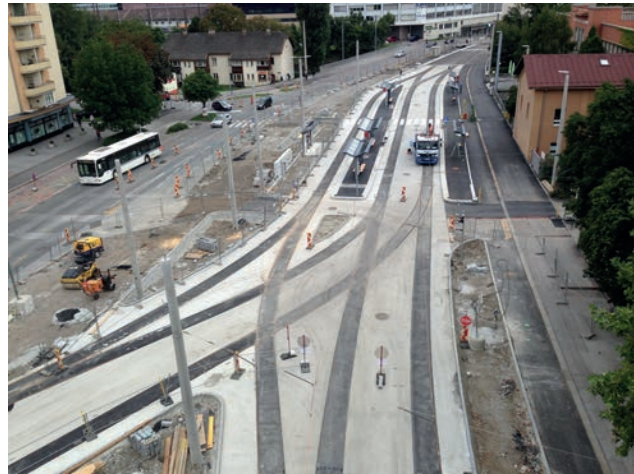
Halbstarrer Fahrbahnbelag im Haltestellenbereich Bild: PORR
