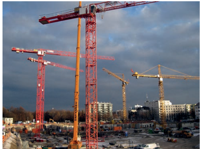
Am Westpark – BE 1 Bild: PORR
