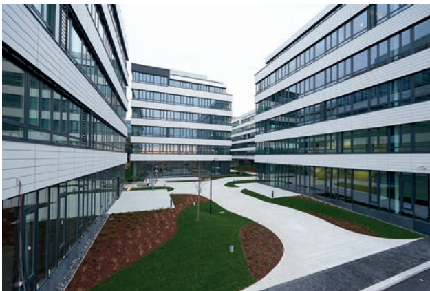
Fertigstellung der Außenanlagen u. Begrünungsarbeiten Bild: Toni Rappersberger
