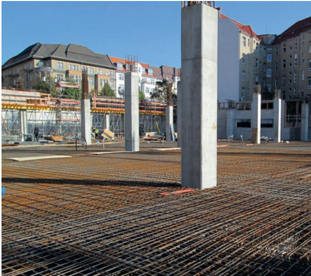
Bodenplatte Bild: PORR
