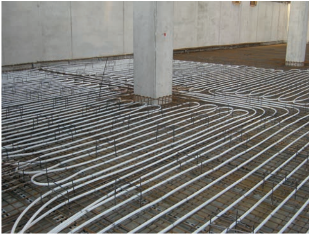
Betonkerntemperierung Bild: PORR
