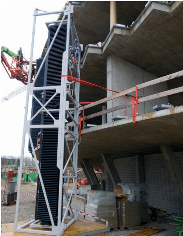
Montage Zackenfassade (22.11.2012) Bild: ALU-SOMMER
