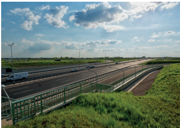
S2 in Richtung Knoten Konotopa (A2/S8) Bild: PORR
