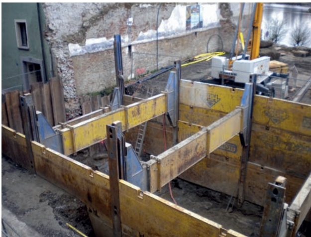
Ausgehobene Baugrube Pumpwerk Wieningerstraße Bild: PORR
