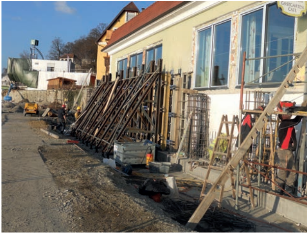
Schalungsarbeiten für Hochwasserschutzmauer im Vorland (Polder 2) Bild: PORR
