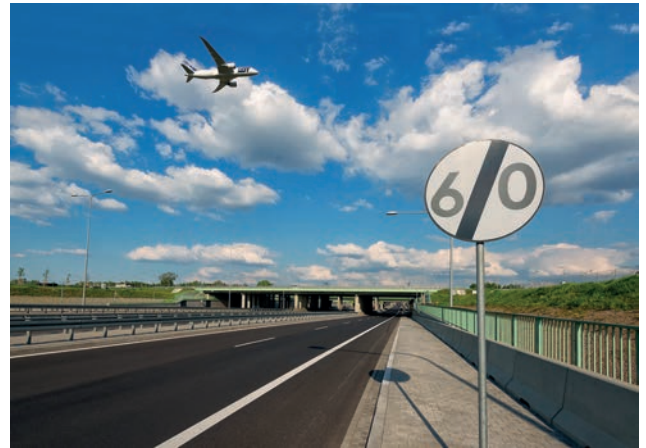
S2 – Sicht in Richtung Dichtwanne Bild: PORR
