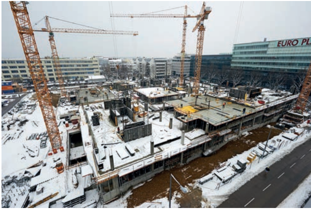
Harte Bedingungen durch Winterbaumaßnahmen Bild: Toni Rappersberger
