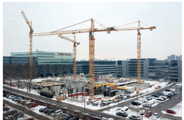
Schnee und Eisräumarbeiten durch Wintereinbruch Bild: Toni Rappersberger
