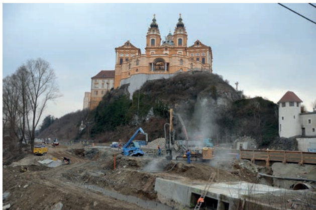
Stift Melk – Arbeiten zur Untergrundabdichtung Bild: PORR
