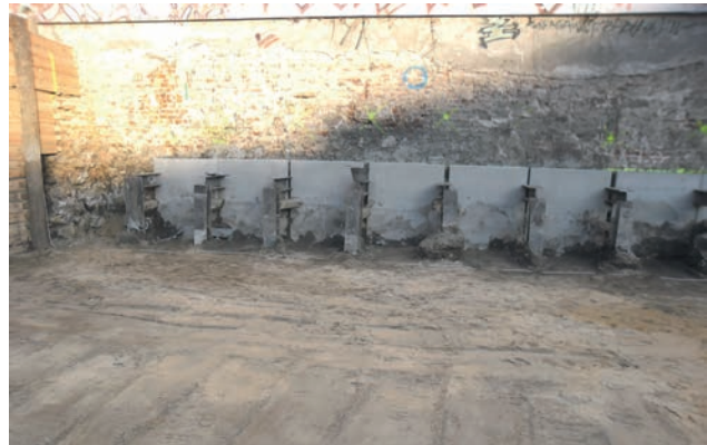
Baugrube Haus 10 Bild: PORR
