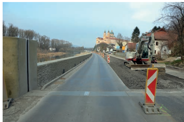
Sanierung der Bundesstraße nach Herstellung der HWS-Wand Bild: PORR
