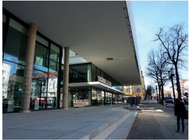
Überbauung U-Bahnzugang – Endzustand Bild: PORR
