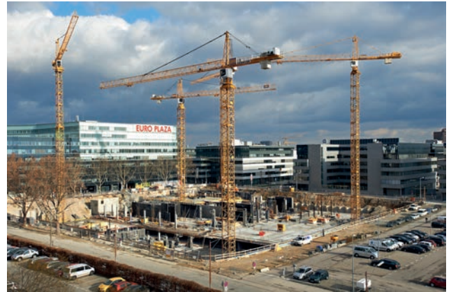
Beton- und Stahlbetonarbeiten im 2. Untergeschoss Bild: Toni Rappersberger
