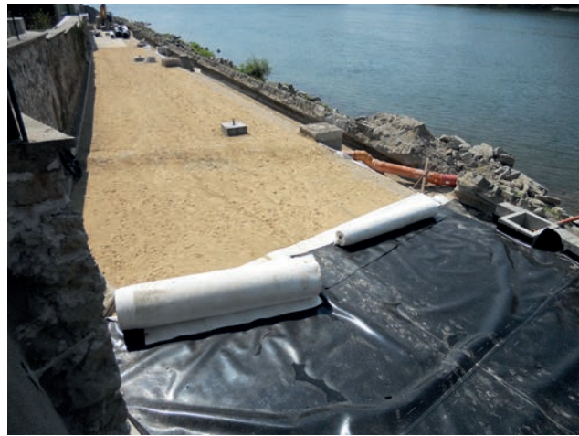
Hergestelltes Sandbett für Folienverlegung im Polder 2 Bild: PORR
