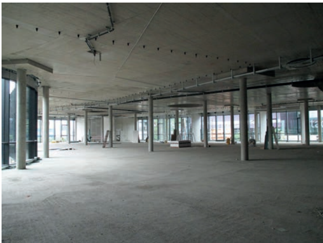
Zukünftiger Newsroom Bild: PORR
