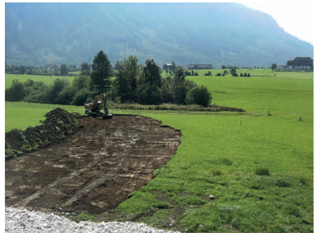
Schüttung Zufahrtsstraße Bild: PORR
