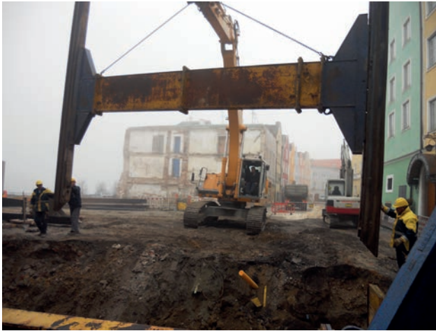
Setzen des SBH-Verbaus beim Pumpwerk Wieningerstraße Bild: PORR
