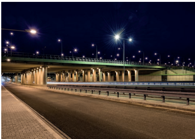
S2 – Dichtwanne des Knotens Lotnisko bei Nacht Bild: PORR
