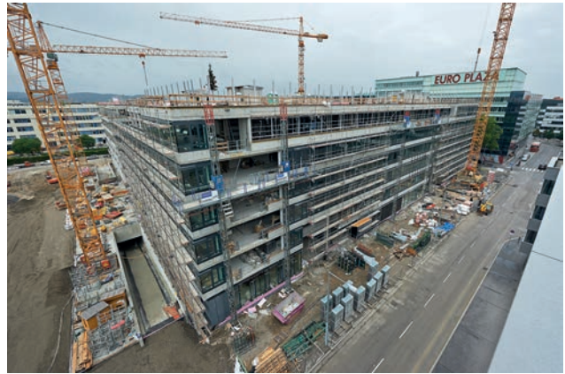
Fassadenmontage und Einbringöffnungen durch Klettermastbühnen Bild: Toni Rappersberger
