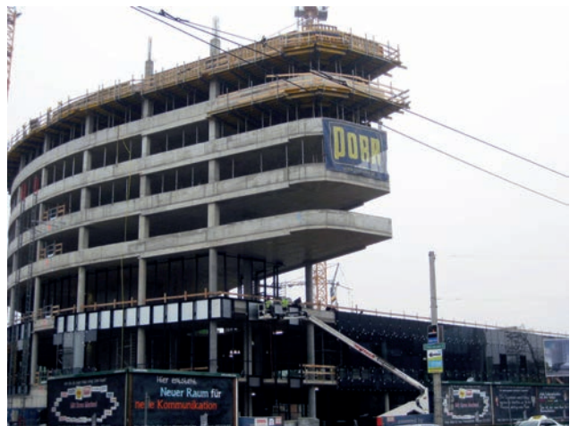
Auskragung im Bereich Conrad-von-Hötzendorfstraße Bild: PORR
