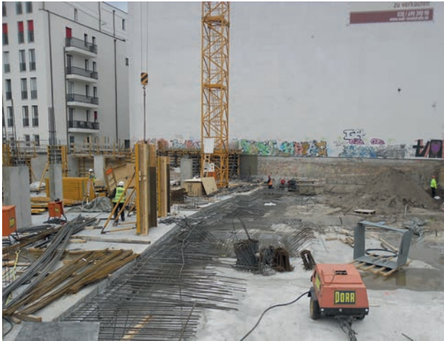
Bodenplatte Haus 9 Bild: PORR
