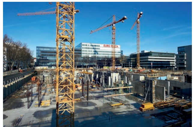
Beton- und Stahlbetonarbeiten im 1. Untergeschoss Bild: Toni Rappersberger
