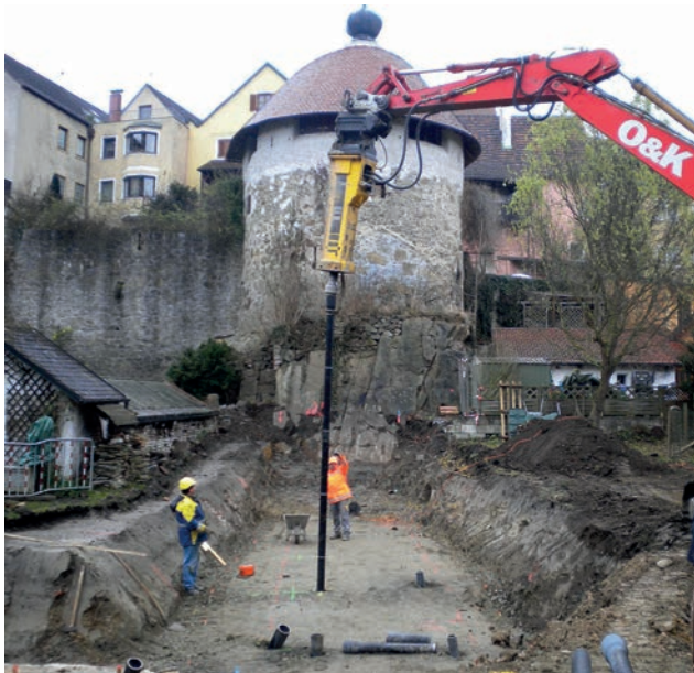
Duktile Gusspfähle als Gründung für Hochwasserschutzmauer Bild: PORR
