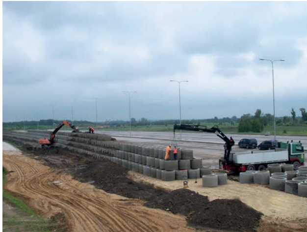
Herstellung der begrünten Lärmschutzwände aus Betonfertigteilen Bild: PORR
