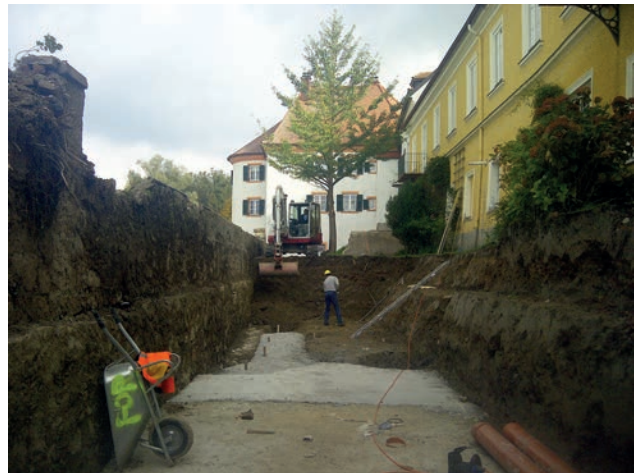
Aushubarbeiten für Hochwasserschutzmauer hinter der Stadtmauer Bild: PORR
