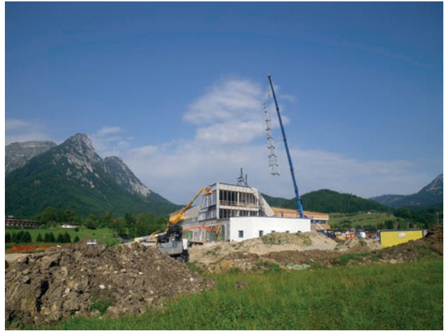
Montage Turm Bild: PORR
