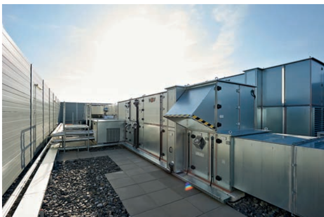
Lüftungsanlagen hinter Schallschutzwänden am Dach BT J Bild: Toni Rappersberger
