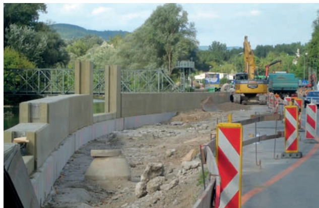
Fertiggestellte Hochwasserschutzwand Bild: PORR
