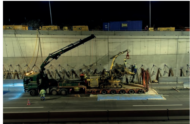
Abb. 4: Bohrgeräteeinheit Klemm KR806/3 auf LKW-Zug Bild: PORR
