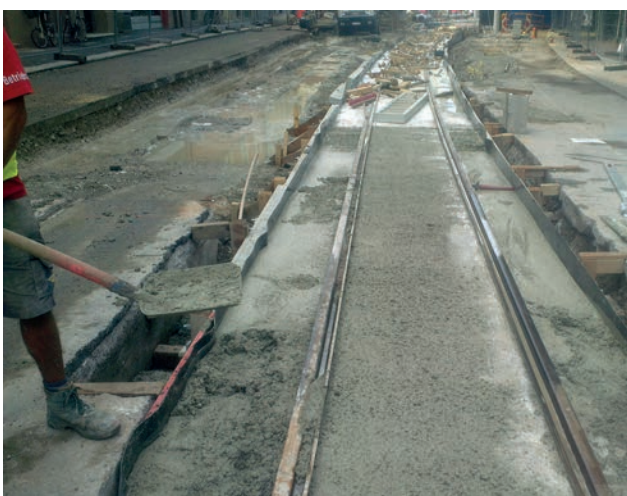
Betonieren der Gleistragplatte Bild: PORR
