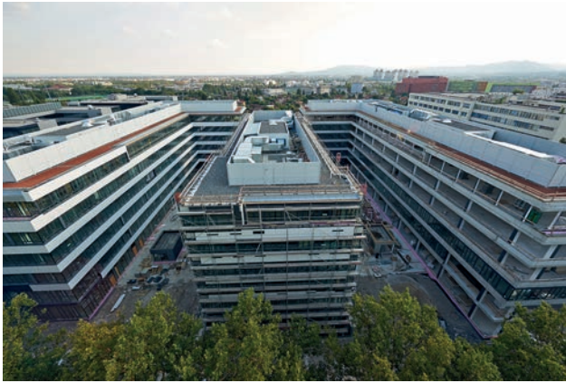
Begrünung der Dächer sowie Komplettierungsarbeiten Bild: Toni Rappersberger
