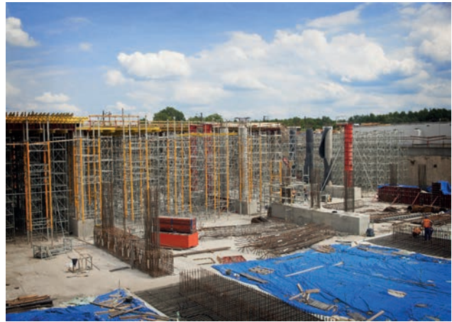
Bewehrung der Objekte WD-19A und WD-19B Bild: PORR
