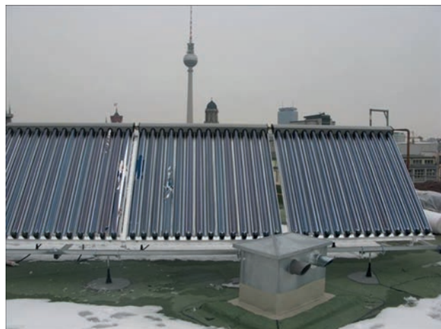
Solarthermieanlage Bild: PORR
