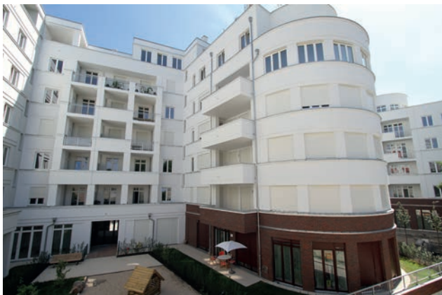
Hofansicht – nach der Gestaltung Bild: PORR
