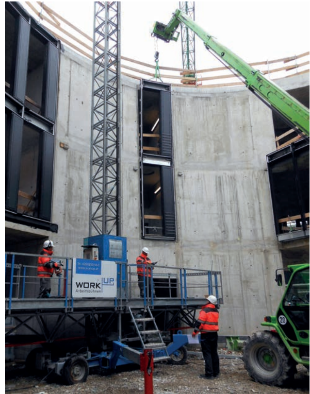
Versetzen eines P/R-Elements mittels Teleskopstapler (18.12.2012) Bild: ALU-SOMMER
