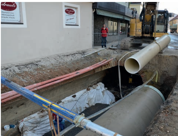
Abbruch des alten Weierbaches und Herstellung der neuen Verrohrung Bild: PORR
