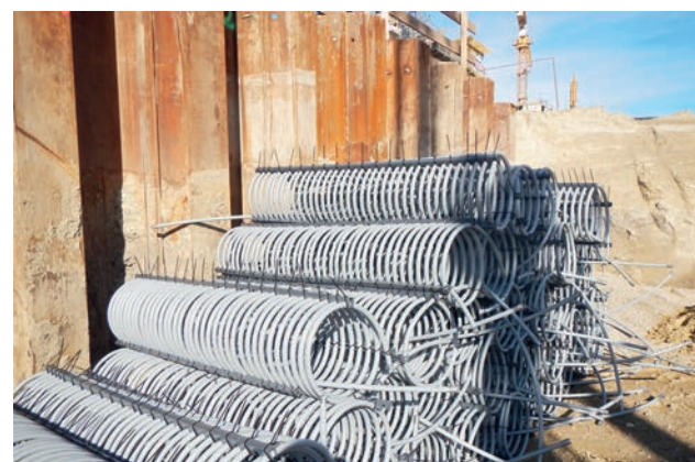
Erdwärmesonden Bild: PORR AG
