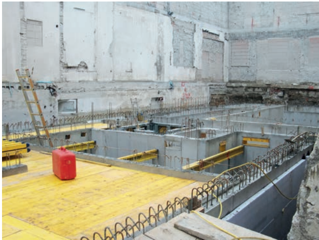
Neu errichteter Keller im Bestandsgebäude Bild: PORR AG
