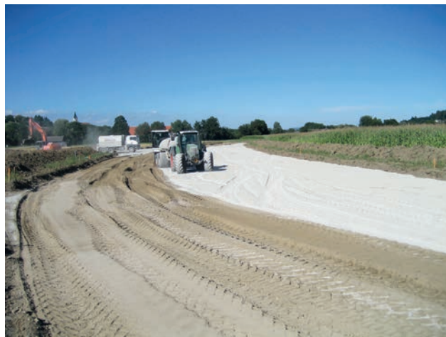
Untergrundstabilisierung im Bereich Dammaufstandsfläche Bild: PORR AG
