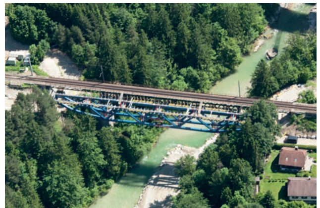
Stahltragwerk in Seitenlage Bild: LBS Redl
