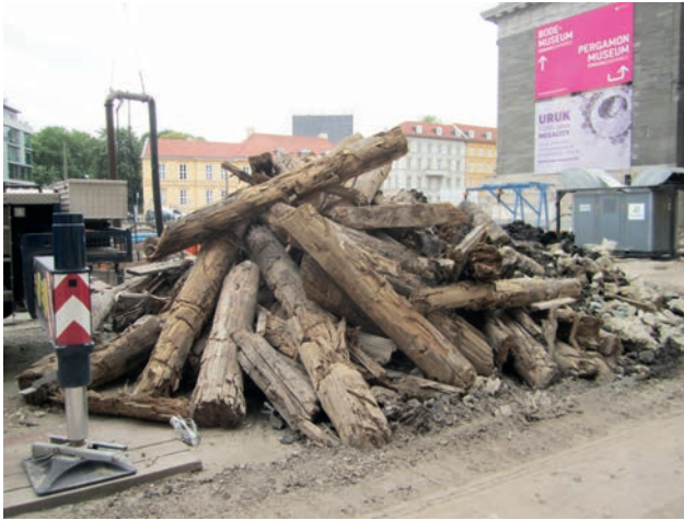
Geborgene Holzpfähle der ehemaligen Gründung im Baufeld Bild: PORR AG
