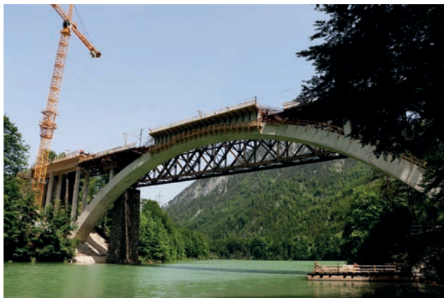
Bogentragwerk Steyrtalbrücke Bild: Günther Gröger
