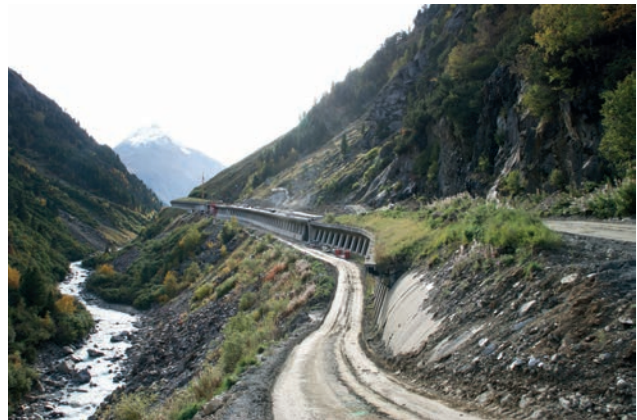
Baustraße zur Zwischendeponie Bild: PORR AG
