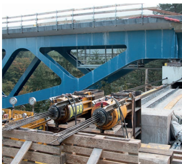
Querverschub der neuen Teichlbrücke Bild: Günther Gröger
