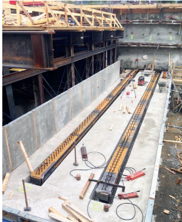
Einbau Verschiebungsschienen im Verschiebungsfundament Bild: PORR AG
