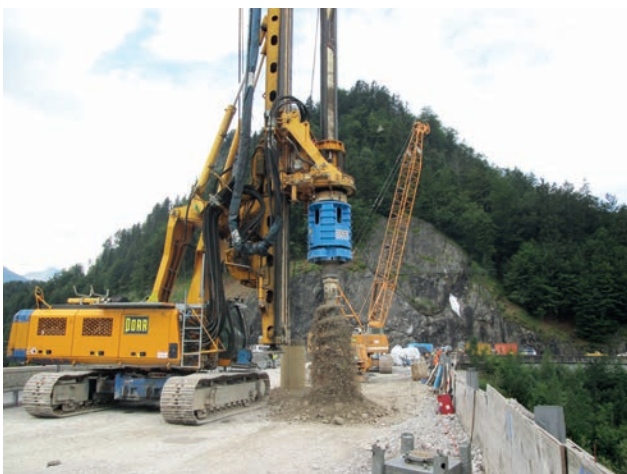
Drehbohranlage BG 36 mit Automatikdrehteller und Bohrschnecke beim Bohren im Dammkörper Bild: PORR AG
