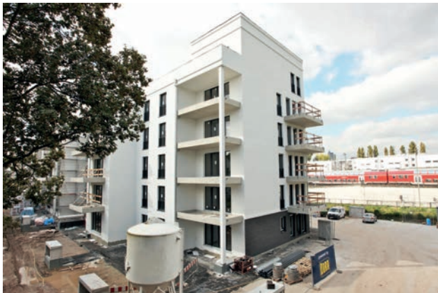
Stand September 2014 Bild: PORR AG
