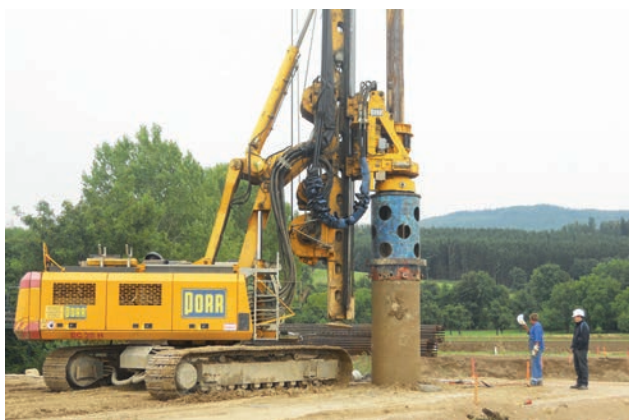
Brücke über die Kleine Erlauf, Herstellung der Tiefgründung mittels Bohrpfählen Bild: PORR AG
