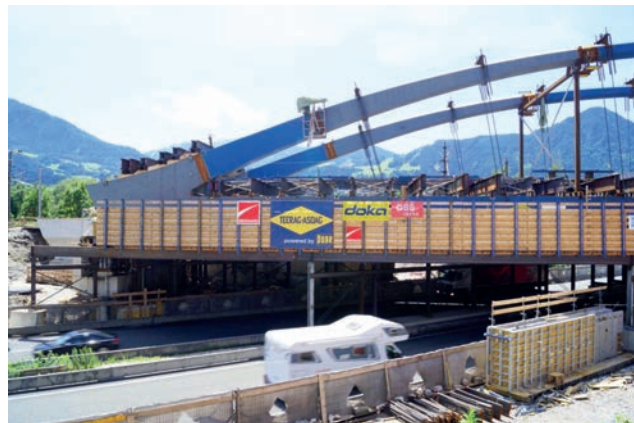
Lehrgerüst für die Tragwerksschalung Bild: PORR AG
