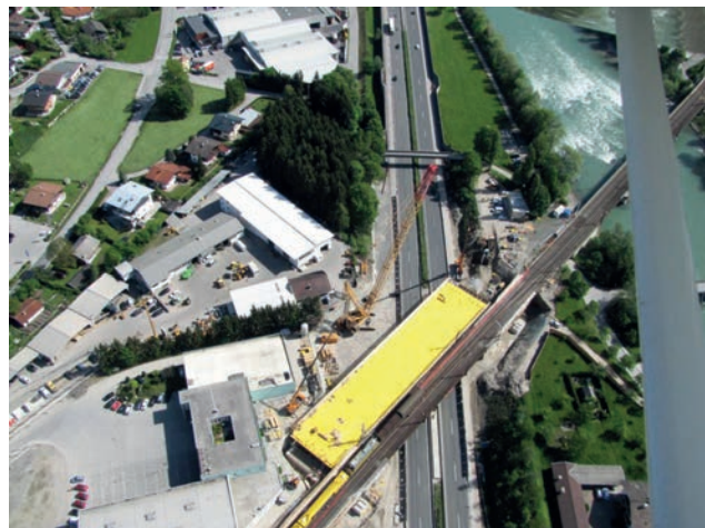
Schutzgerüst über der Autobahn A12 Bild: PORR AG
