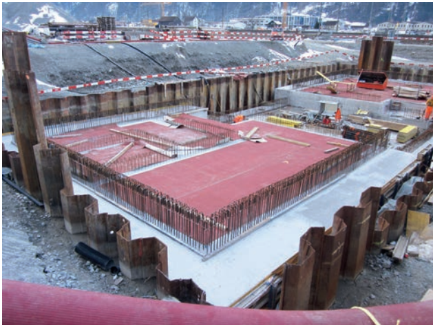
Baugrube und Bodenplatte des Rohrkellers Süd Bild: PORR AG
