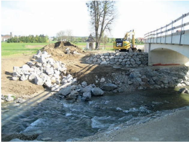
Brücke über die Kleine Erlauf, Steinschichtungen an der Uferböschung Bild: PORR AG
