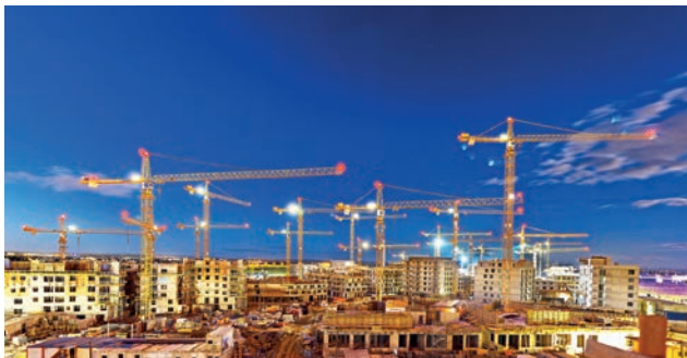
Seestadt Aspern Bild: Liebherr-Werk Bischofshofen GmbH
