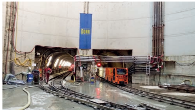
Startschacht 033 Vortriebsbeginn Bild: PORR AG
