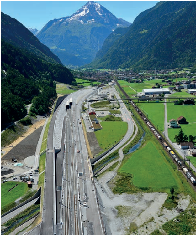
Trasse Richtung Süden – im Hintergrund die Gemeinde Erstfeld; Die Bahngleise zu den beiden Tunnelleingängen sind verlegt. Die Ausrüstung der Tunnel mit Gleisen und Bahntechnik läuft auf Hochtouren; Renaturierungsarbeiten seitlich der Trasse sind bereits in Ausführung. Bild: A. Wildbolz, Abschnittsleiter Alptransit Nord, Juli 2014
