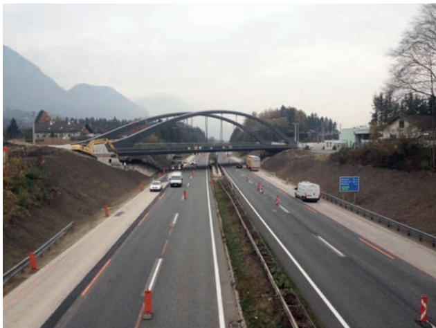
Bogenbrücke ÖBB-Brücke Kramsach Bild: PORR AG
