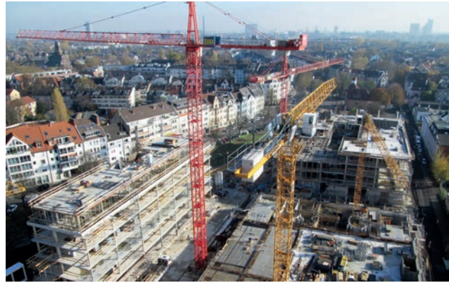
Tiefgaragenbereich fünf Monate später Bild: PORR AG
