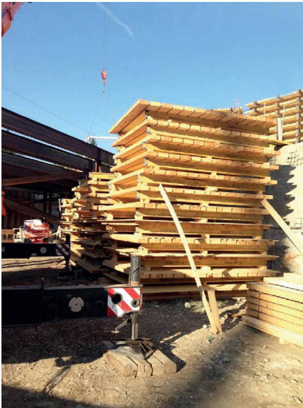
Lagerung der vor Ort hergestellten Montageböden für das Schutzgerüst Bild: PORR AG
