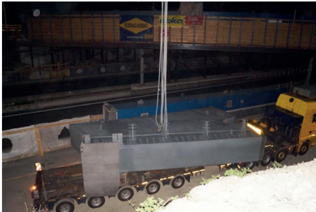
Versetzen des 80 t schweren Bogenfußes Bild: PORR AG
