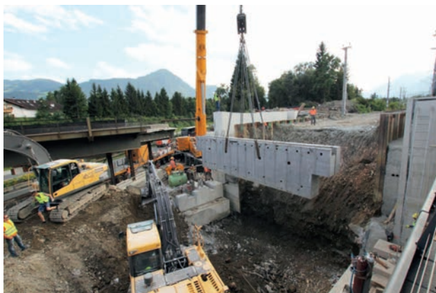
Versetzen der FT-Träger für den anschließenden Verschub Bild: PORR AG
