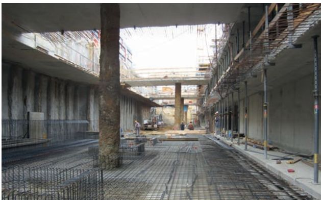
Deckelbauweise Bild: PORR AG
