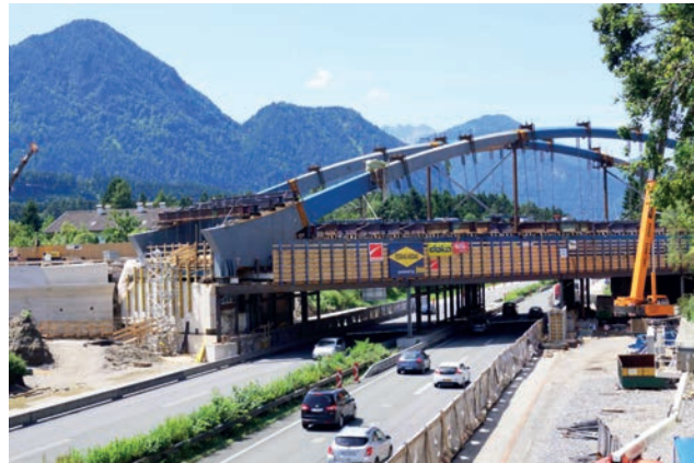
Lehrgerüst für die Tragwerksschalung Bild: PORR AG
