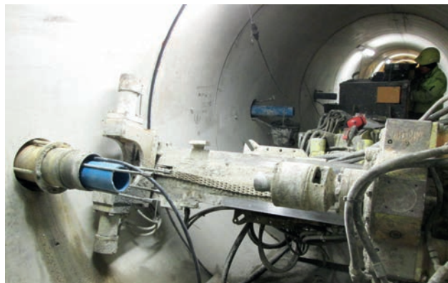
Herstellung der horizontalen Bohrung mit Keller-Bohrgerät im Stollen mit d=2,40 m; Einbau der Abflussleitung innerhalb der temporären Verrohrung d=178 mm Bild: PORR AG
