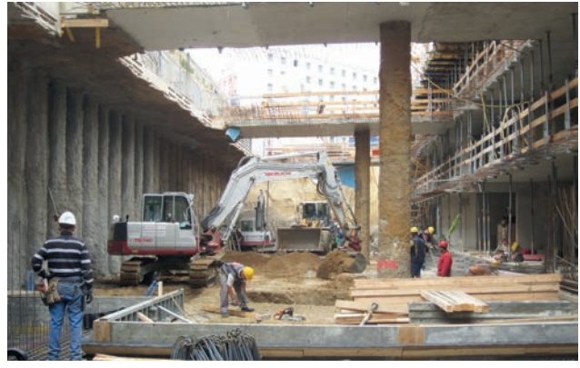
Deckelbauweise Bild: PORR AG
