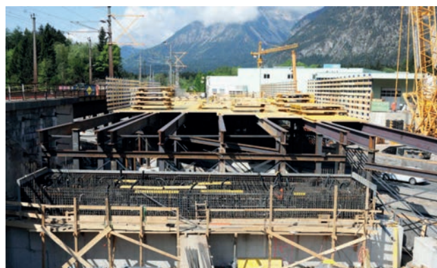
Bewehrte und geschaltete Lagerbank mit Betonier- und Lüftungsöffnungen Bild: PORR AG
