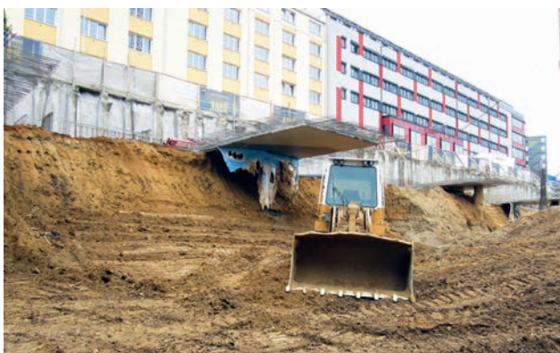
Baugrubenabsteifung mittels Betonrost und auskragenden „Zungen“ Bild: PORR AG
