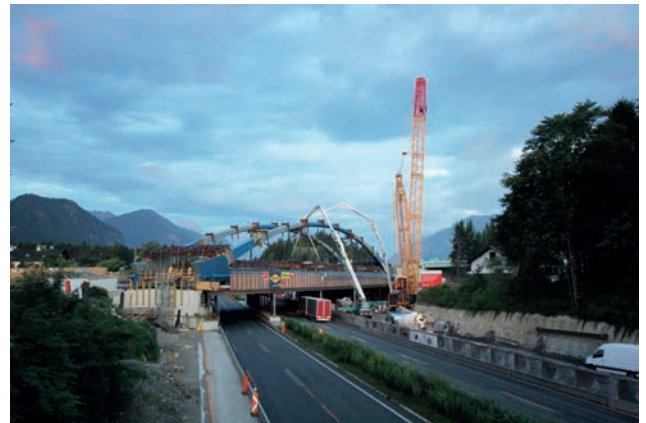
Betonage der 1.100 m 3 großen Fahrbahnplatte Bild: PORR AG
