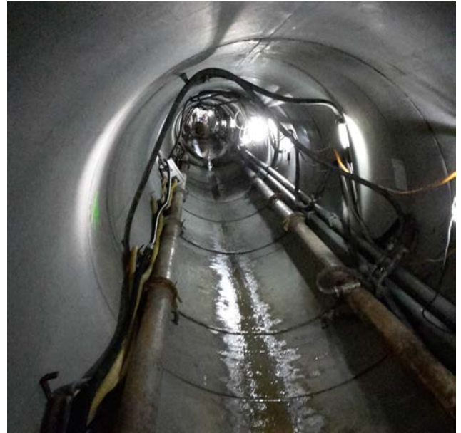
Blick in den Tunnel Bild: PORR AG
