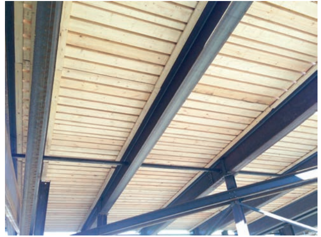
Untersicht versetzter Montageböden für das Schutzgerüst Bild: PORR AG
