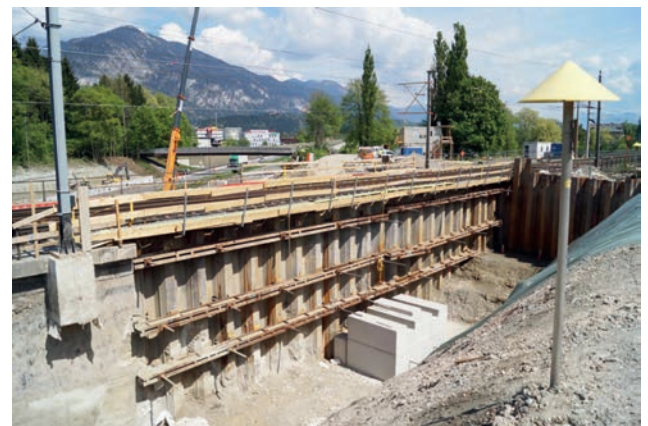
WL Wörgl – Fangedammkonstruktion inkl. Bedienweg Bild: PORR AG
