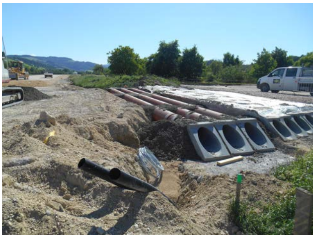
Herstellung der Rohrdurchlässe für den Hochwasserabfluss Bild: PORR AG
