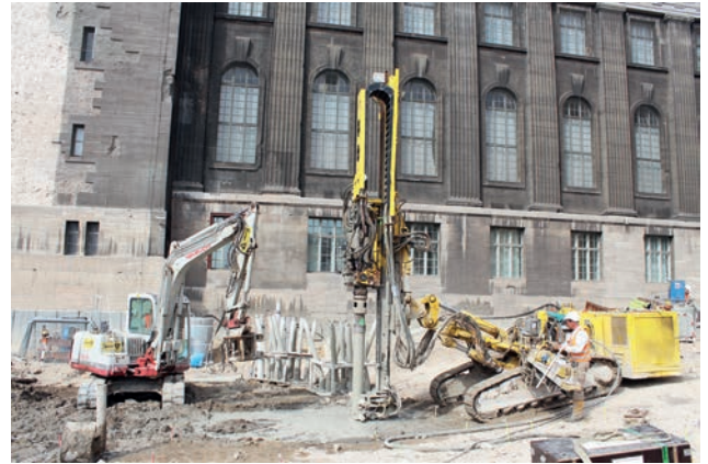
Bohren und Einbau der Mikropfahlgründung Bild: PORR AG
