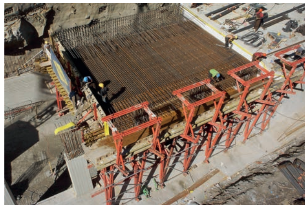
Bewehrungsverlegung Rahmentragwerk Bild: PORR AG
