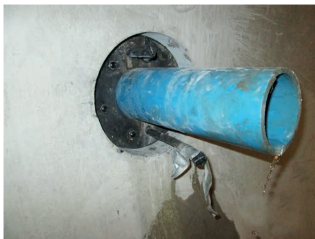
Fertiggestellte Abflussleitung mit Abdichtung über Packersystem mit Nachverpressung zur Fassung des Sickerwassers aus den Drainagebrunnen Bild: PORR AG
