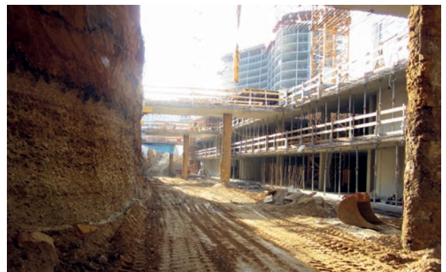
Erdarbeiten unter dem Aussteifungshorizont Bild: PORR AG
