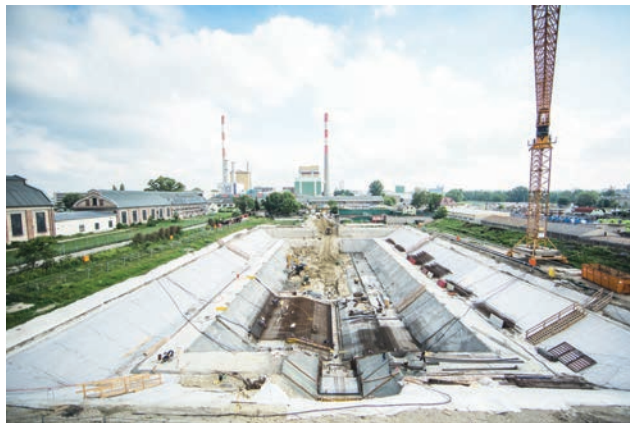
Fertige Baugrube inkl. Sauberkeitsschicht Bild: APA/Wien Kanal
