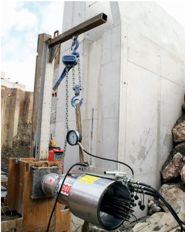
5 MN Spannresse für den Querverschub Bild: PORR AG
