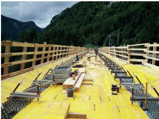
Herstellung Fahrbahnverbundplatte Bild: PORR AG
