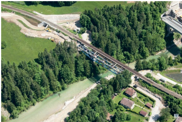
Flugaufnahme Güterwegunterführung und Teichlbrücke Bild: LBS Redl
