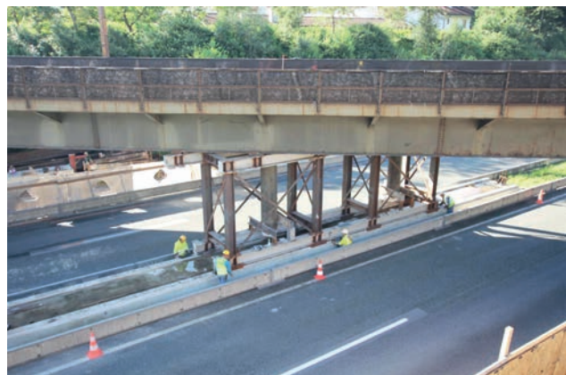
Durchführung des Querverschubs des Bestandstragwerks Bild: PORR AG
