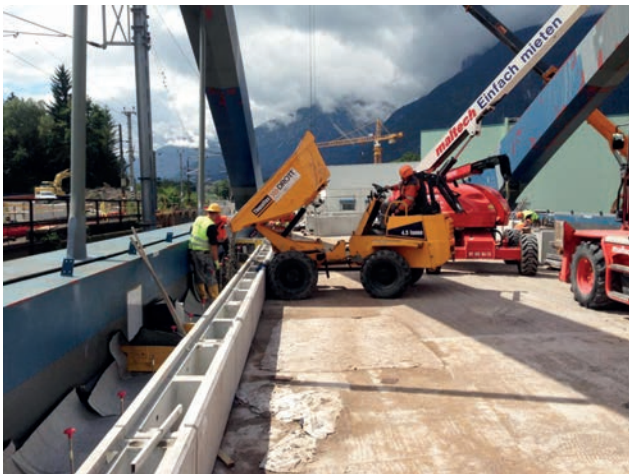
Einbau des Einkornbetons unterhalb der Kabeltrogfertigteile Bild: PORR AG
