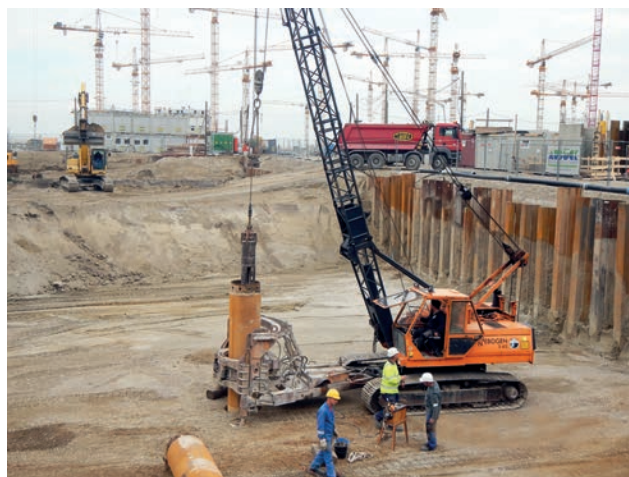
Brunnenherstellung für Grundwasserabsenkung Bild: PORR AG
