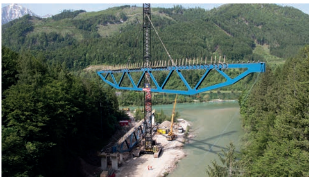
Verfahren des Stahlfachträgers und Vormontageplatz Bild: Günther Gröger
