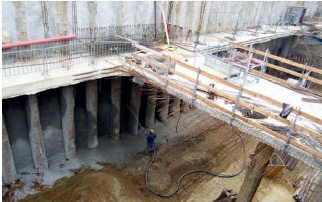
Deckelbauweise Bild: PORR AG
