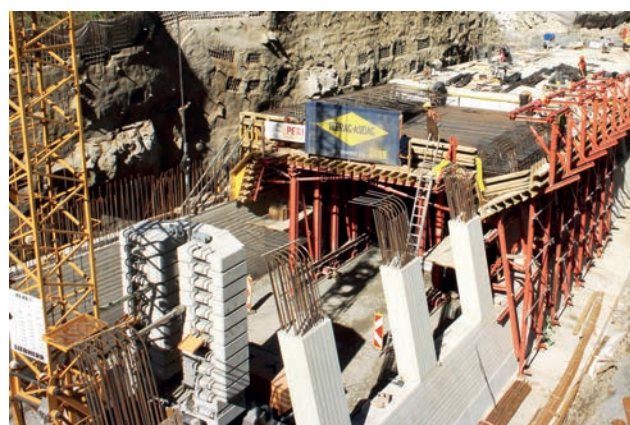
Bewehrungsverlegung Rahmentragwerk Bild: PORR AG
