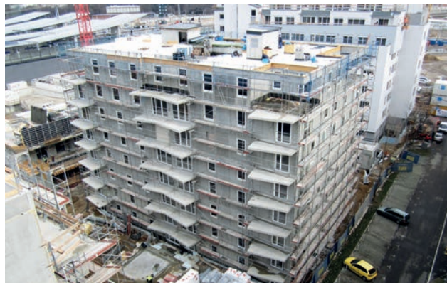
Rohbau Bild: PORR AG
