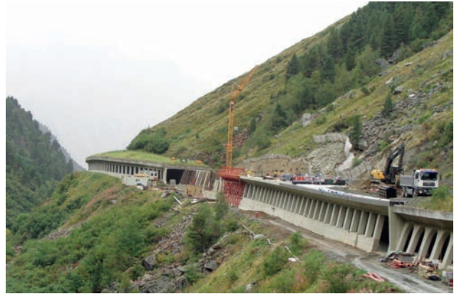
Bauzustand September 2013 Bild: PORR AG
