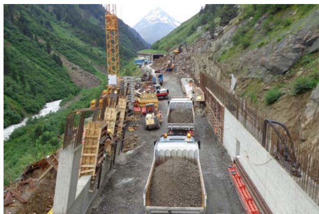
Talseitige Wandsäulen Bild: PORR AG
