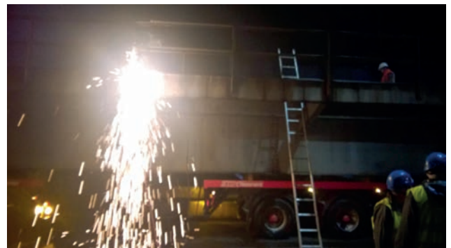
Trennen des auf zwei Tiefbettsattel gelagerten Bestandstragwerks Bild: PORR AG
