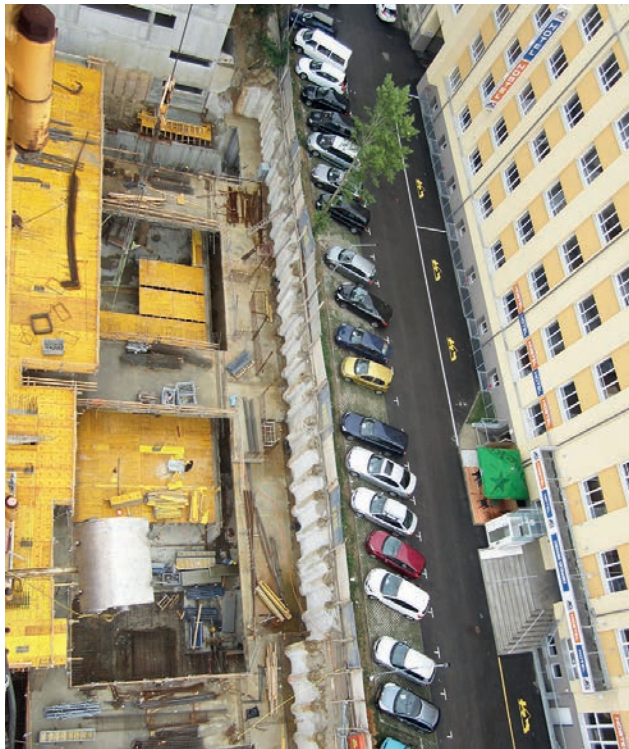
Deckelbauweise Bild: PORR AG
