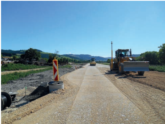
Einbau der ungebundenen Tragschichten mit theodolitgesteuertem Grader Bild: PORR AG
