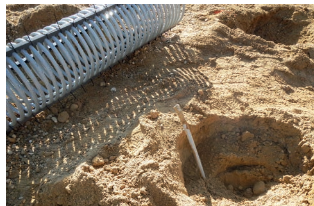
Erdwärmesonden Bild: PORR AG
