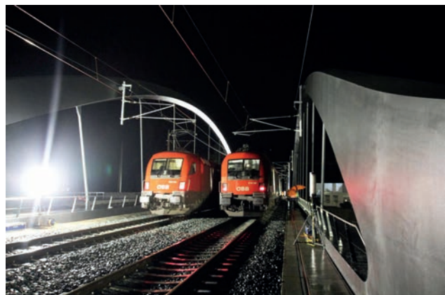
Belastungstest mit sechs Taurus-Lokomotiven à 86 t Bild: PORR AG
