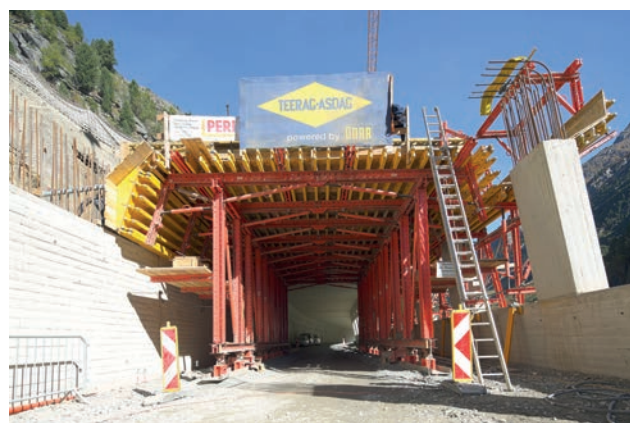
Galerie-Schalwagen Bild: PORR AG
