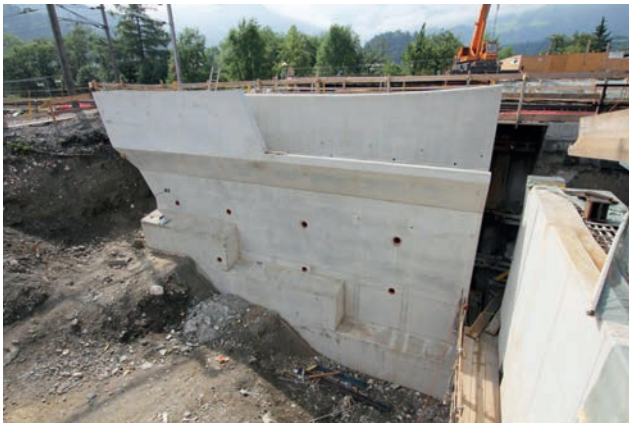
WL Kufstein – fertiggestellte Flügelmauer Bild: PORR AG
