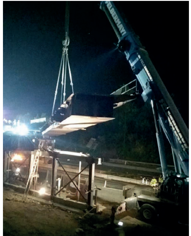
Aushub des Bestandstragwerks mit einem 500 t-Mobilkran Bild: PORR AG
