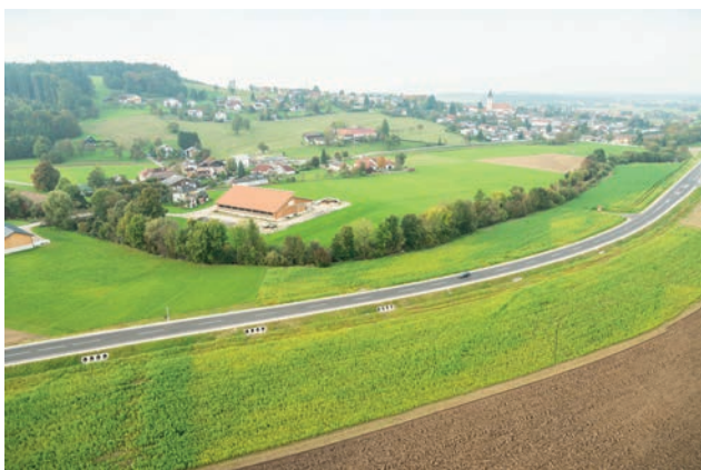
Rohrdurchlässe durch die Umfahrungsstraße für den Hochwasserabfluss Bild: Markus Hahslinger
