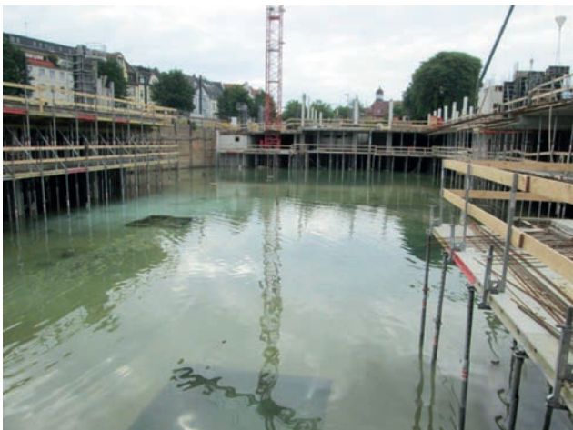
Tiefgaragenbereich im Juni Bild: PORR AG
