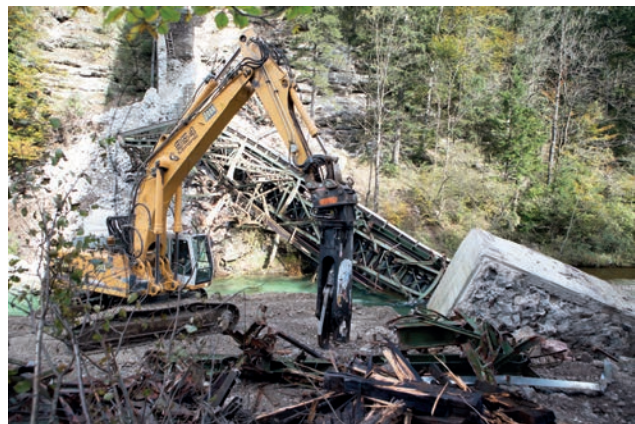
Zerkleinern der gesprengten Teichlbrücke Bild: Günther Gröger
