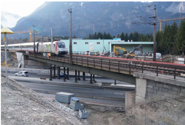
Alte ÖBB-Brücke Kramsach Bild: PORR AG
