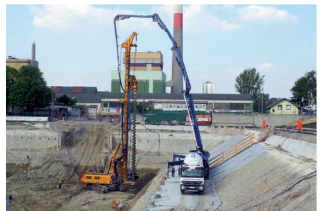
Herstellung der SOB-Pfähle Bild: PORR AG
