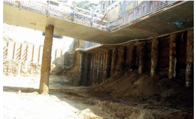
Erdarbeiten unter dem Aussteifungshorizont Bild: PORR AG
