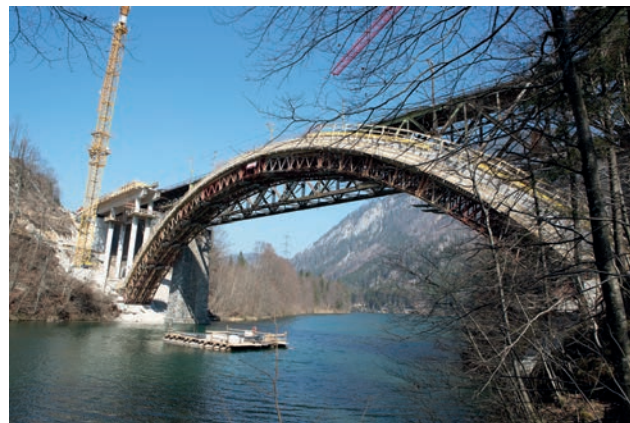
Lehrgerüst Bogentragwerk Bild: PORR AG
