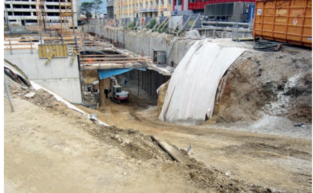
Deckelbauweise Bild: PORR AG
