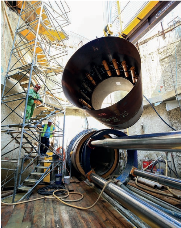
Einbau der Dehnerstation Bild: APA/Wien Kanal
