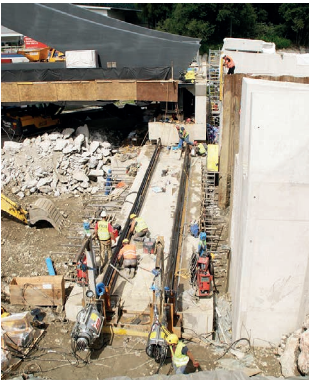
Vorbereitungsarbeiten für den Querverschub Bild: PORR AG
