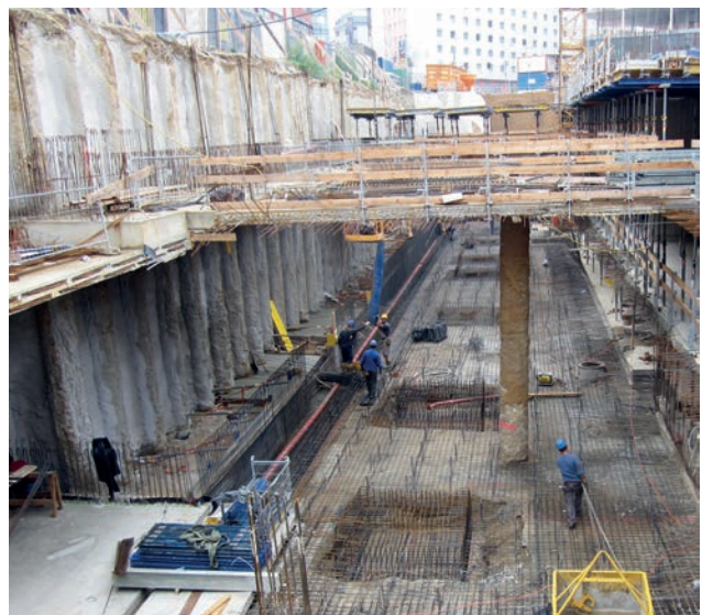
Deckelbauweise Bild: PORR AG
