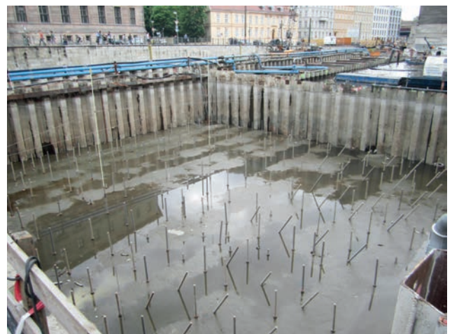
Blick in einen gelenzten Baugrubentrog mit Unterwasserbetonsohle und Mikropfahlrückverankerung Bild: PORR AG
