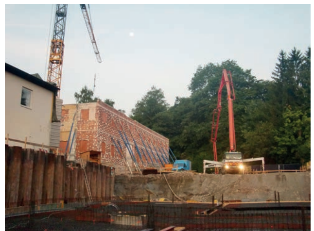
Abgestützte Bestandswände
