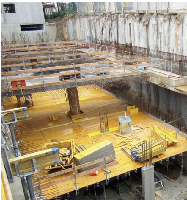
Deckelbauweise Bild: PORR AG
