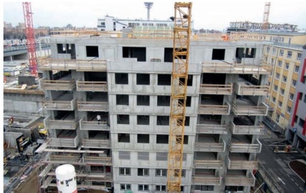
Rohbau Bild: PORR AG
