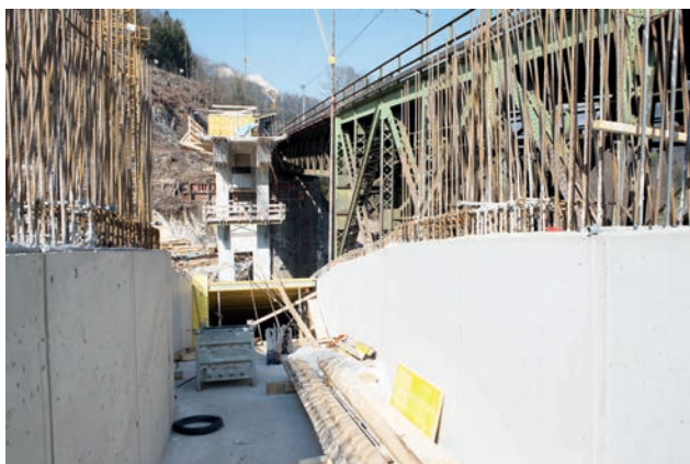
Herstellung Bogenhohlkasten Bild: Günther Gröger
