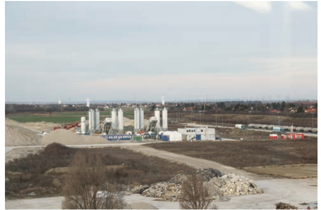
Betonmischanlage mit Baulogistikcenter Bild: PORR AG
