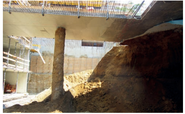
Erdarbeiten unter dem Aussteifungshorizont Bild: PORR AG
