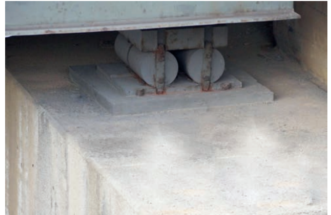
Bestehende ÖBB-Brücke Kramsach – verdrehbares Punktlager Bild: PORR AG
