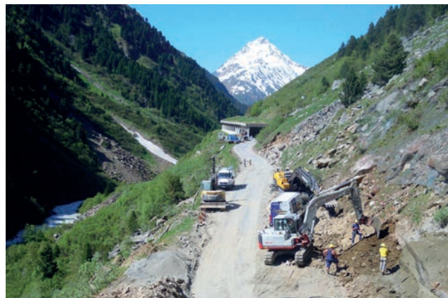
Felssicherungs- und Aushubarbeiten Bild: PORR AG
