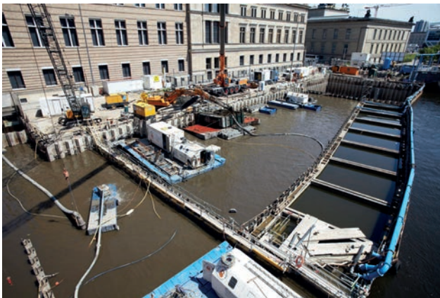
Blick in die hergestellten und zum Teil gelenzten Trograugruben Bild: PORR AG
