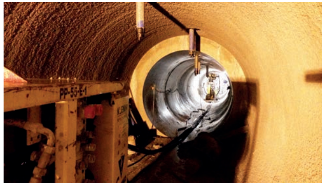
Sickerwasserstollen mit Drainagebrunnen im Bereich Tunnelfirste bei der Ausführung der horizontalen Bohrungen zwischen Stollen und Brunnen Bild: PORR AG
