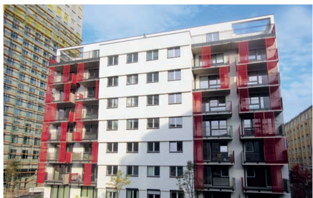
Bauteil G4 Bild: PORR AG
