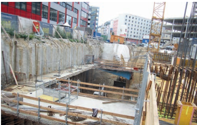
Deckelbauweise Bild: PORR AG
