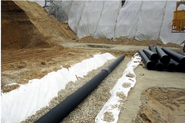
Versickerung unter der Bodenplatte Bild: PORR AG
