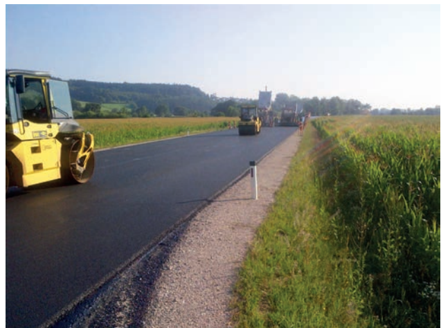
Herstellung der Asphaltdeckschichte mit zwei Kettenfertigern Bild: PORR AG
