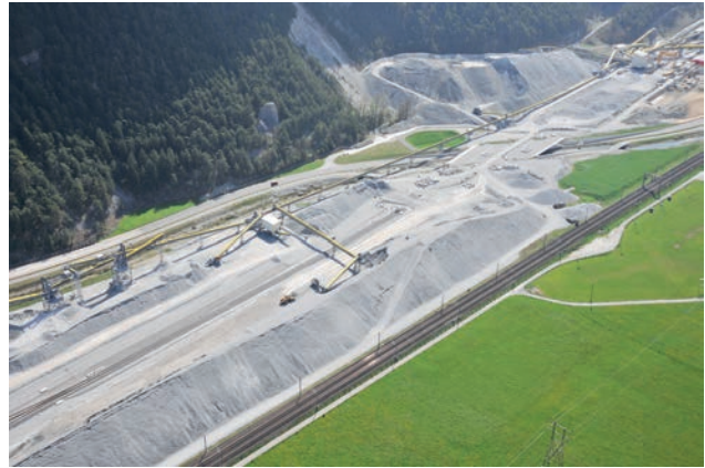
Förderanlagen und Zwischenlager des Ausbruchmaterials für die Schüttungen
