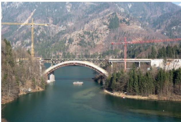
Ansicht Bauzustand Bogen Bild: Günther Gröger
