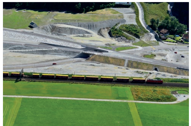
Bereich Unterführung Erstfeld (Los 028)
