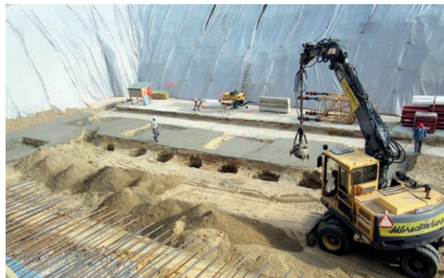
Versickerung unter der Bodenplatte Bild: PORR AG
