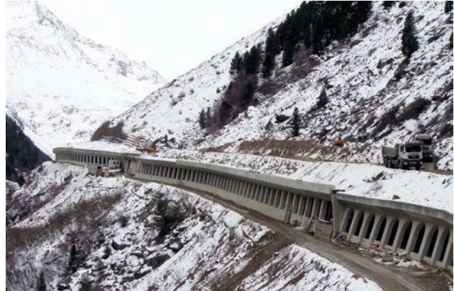
Bauzustand November 2013 Bild: PORR AG
