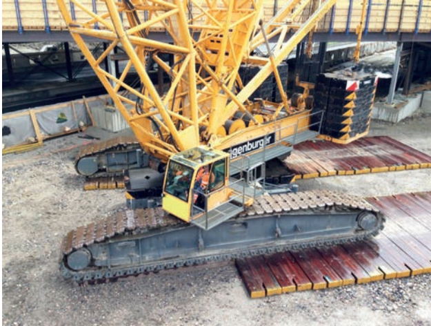
Aufbau Terex 750 t-Raupenkran Bild: PORR AG
