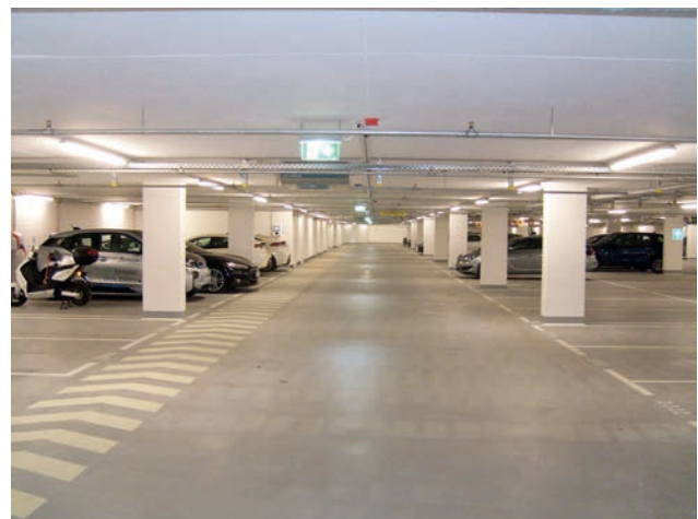
Fertiggestellte Tiefgarage Bild: PORR AG
