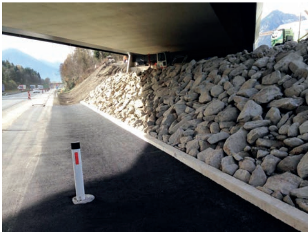
Herstellung des Steinwurfes unterhalb der neuen Brücke Bild: PORR AG
