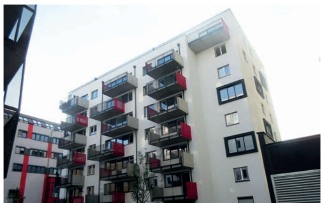
Bauteil G4 Bild: PORR AG
