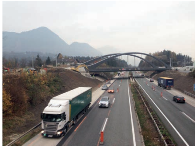
Bogenbrücke ÖBB-Brücke Kramsach kurz vor der Fertigstellung Bild: PORR AG
