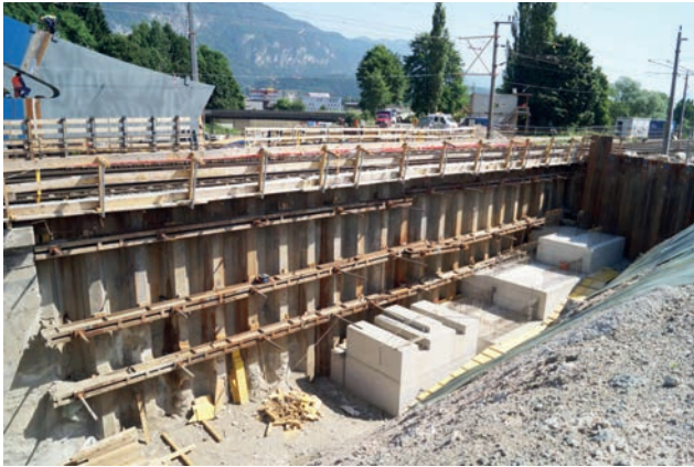
WL Kufstein – Pfahlrost und Fundierung für die Flügelmauer Bild: PORR AG
