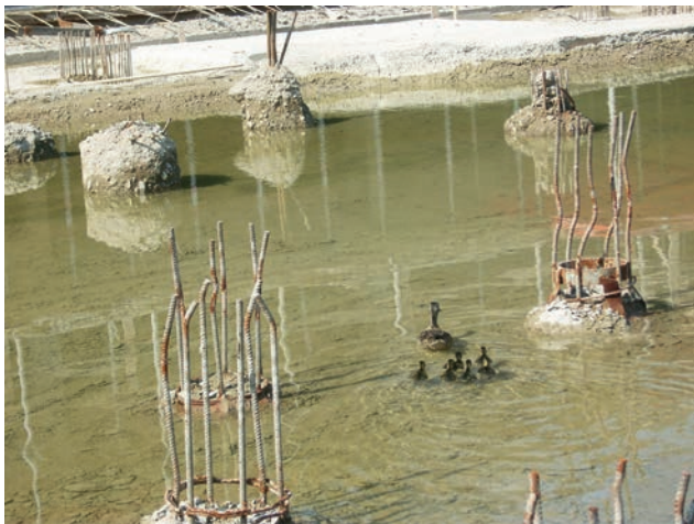
Pfahlköpfe in der TG-Baugrube während des Hochwassers Bild: PORR AG
