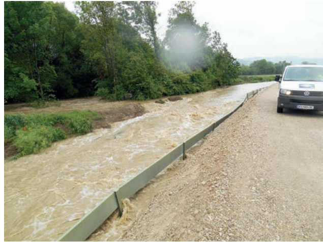
Hochwasser auf den Wirtschaftswegen, Unterspülung Amphibienschutz Bild: PORR AG
