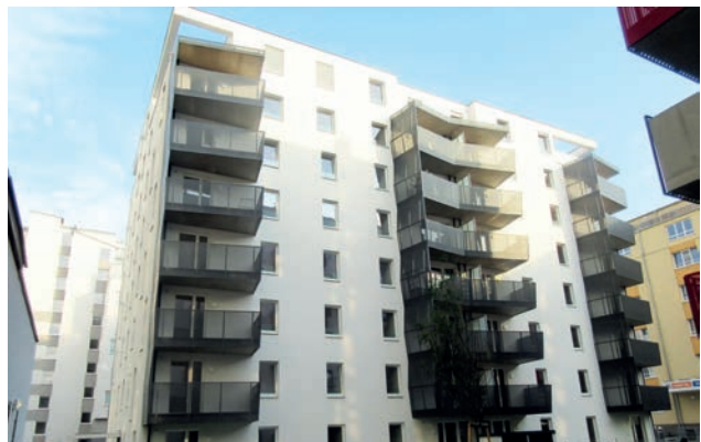
Bauteil G3 Bild: PORR AG
