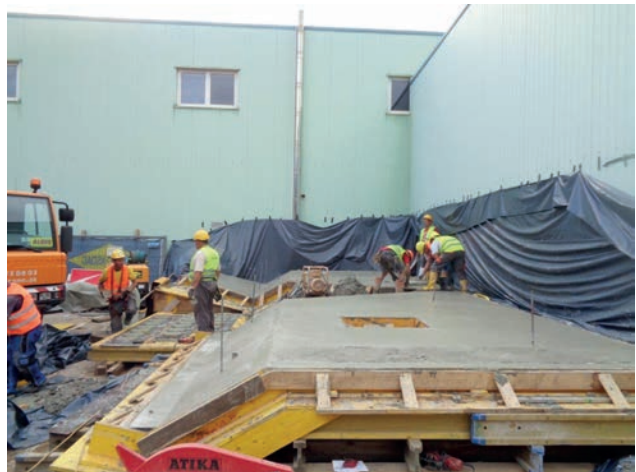
Betonage der Kammerwandfertigteile Bild: PORR AG
