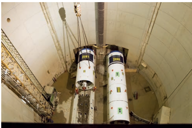
Einhub TVM mit 800 t-Kran Bild: PORR AG
