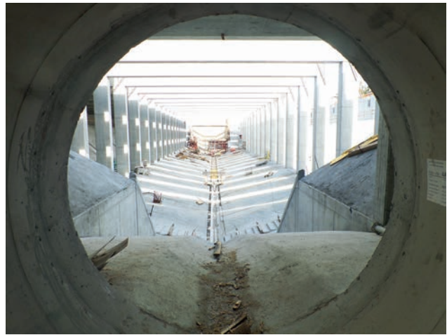
Blick vom Einlaufbauwerk ins Becken Bild: PORR AG
