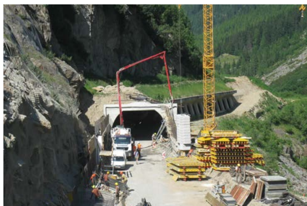
Bergseitige Streifenfundamente Bild: PORR AG
