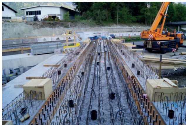
Verlegte Koterschalung (Filigranplatten) für die Herstellung der Lagerbank Bild: PORR AG
