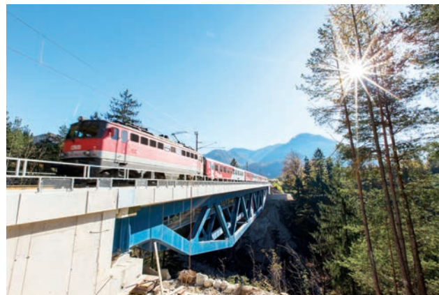
Fertiggestellte Teichlbrücke Bild: Günther Gröger
