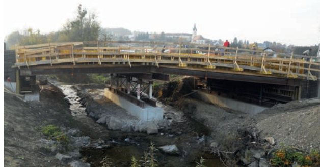
Brücke über die Kleine Erlauf, Fertigstellung der Schalungsarbeiten Bild: PORR AG
