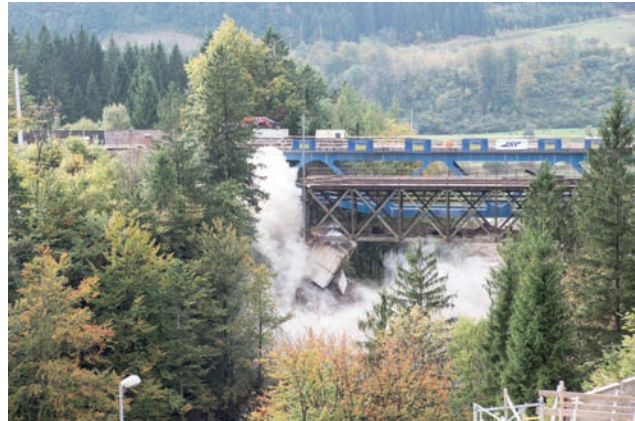
Sprengung Teichlbrücke Bild: Günther Gröger
