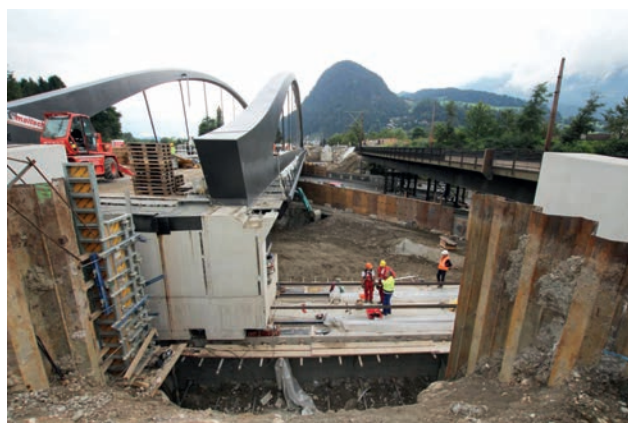
Durchführung des Querverschubs Bild: PORR AG
