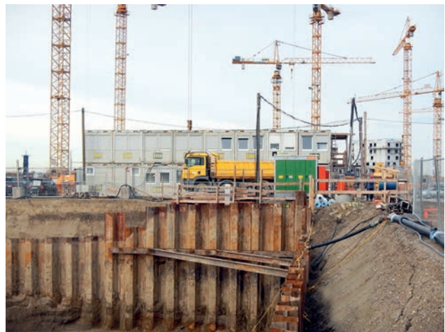
Baugrubensicherung mittels Spundwänden Bild: PORR AG
