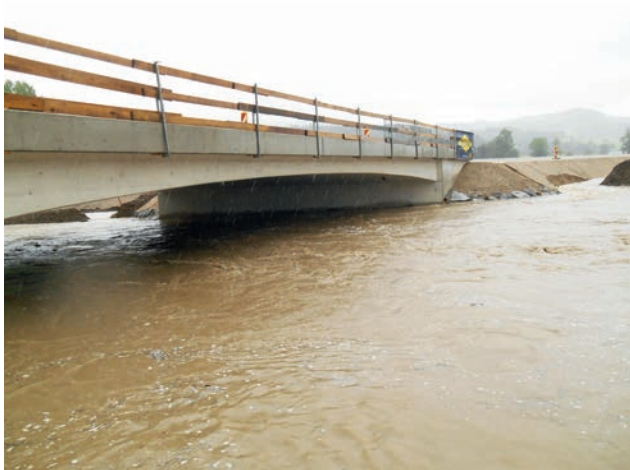
Hochwasser im Bereich der Brücke über die Kleine Erlauf Bild: PORR AG
