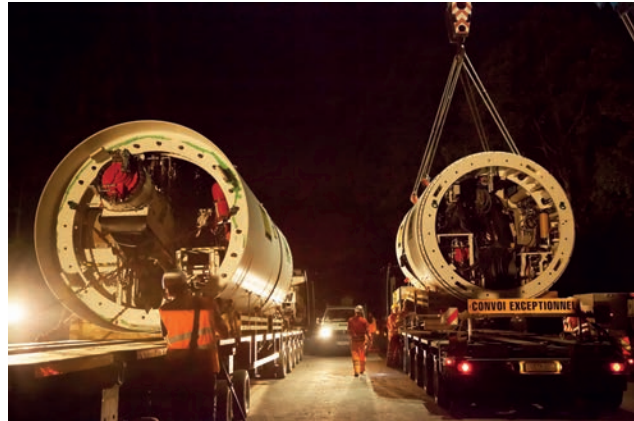
Einhub TVM / Schwertransport Bild: PORR AG
