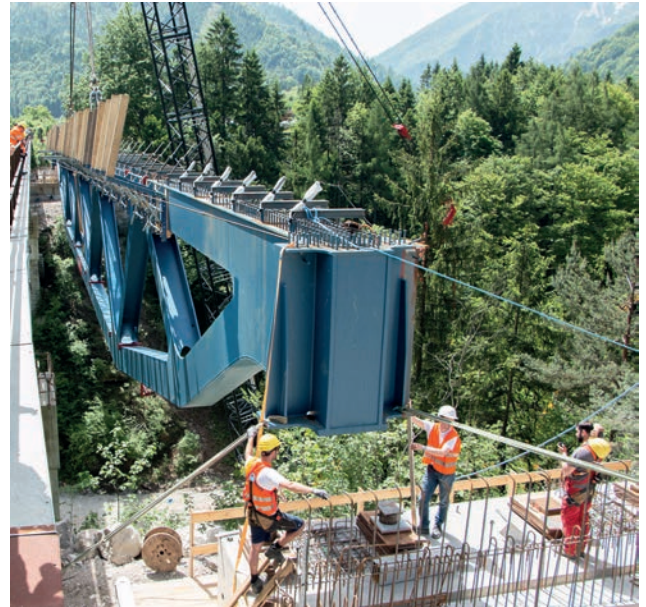
Einheben des Stahlfachträgers Bild: Günther Gröger
