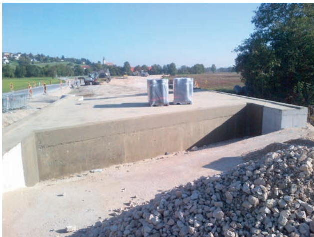
Mühlbachbrücke – Abdichtungsarbeiten Bild: PORR AG
