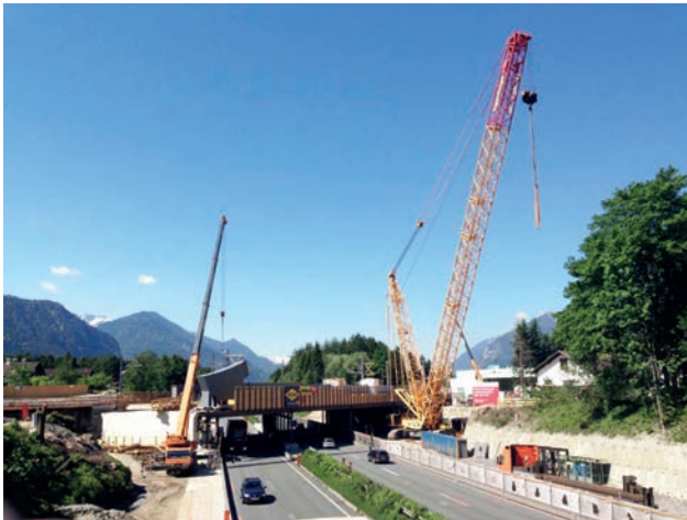
Zusammenbau des Stahltragwerks Bild: PORR AG
