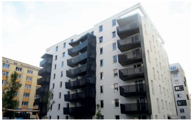
Bauteil G3 Bild: PORR AG
