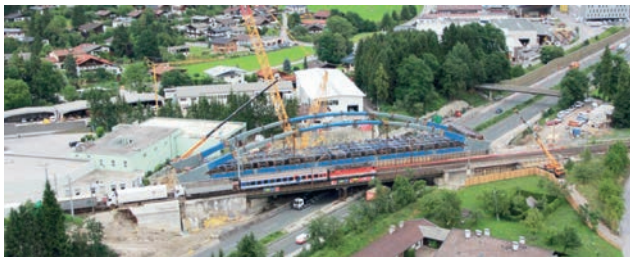
Fertiggestelltes Bogentragwerk und Lehrgerüst für die TW-Schalung Bild: PORR AG
