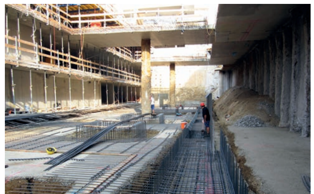
Deckelbauweise Bild: PORR AG
