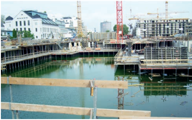
Tiefgarage im Juni-Hochwasser Bild: PORR AG
