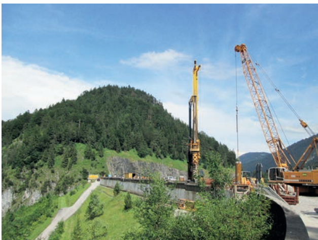
Baufeld mit Drehbohrgerät BG 36 für die Bohrungen und Seilbagger LH 853 zum Ausbau der Brunnen und Rückbau der Verrohrung d=880mm Bild: PORR AG
