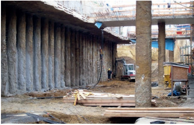
Deckelbauweise Bild: PORR AG
