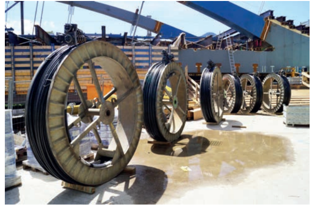
Auf Trommeln gelagerte Spannglieder Bild: PORR AG
