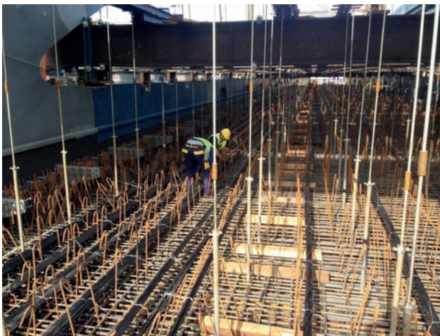
Einziehen und Fixieren der Spannglieder Bild: PORR AG
