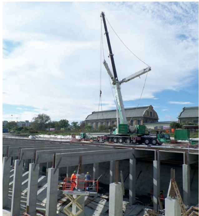
Versetzen der FT-Träger von der Decke aus mittels eines 400 t-Krans Bild: PORR AG
