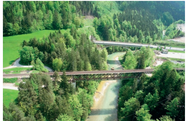
Bestand Teichlbrücke Bild: ÖBB
