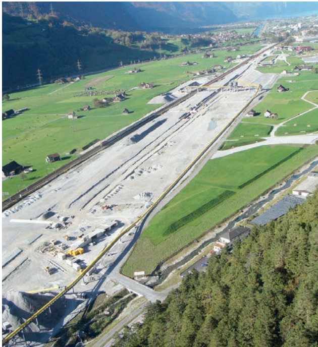
Trasse Richtung Norden – Bauzustand des nördlichen Teils nach einem Jahr Bauzeit; links zu sehen die Stammlinie der Gotthardbahn, rechts: die gelben Bänder der Förderanlagen Bild: PORR AG, Sept. 2008
