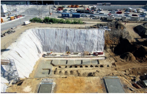
Versickerung unter der Bodenplatte Bild: PORR AG
