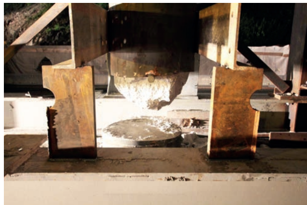
Abgetrennte Pendelstütze nach 20 cm Querverschub Bild: PORR AG
