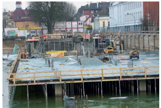
Tiefgaragenbereich im Februar-Hochwasser Bild: PORR AG
