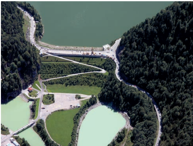
Luftbildaufnahme Richtung Sylvensteicher. Im Vordergrund die Auslässe zur Regulierung des Wasserstaus Bild: PORR AG
