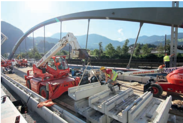
Versetzen der Fertigteilkabeltröge am Tragwerk Bild: PORR AG
