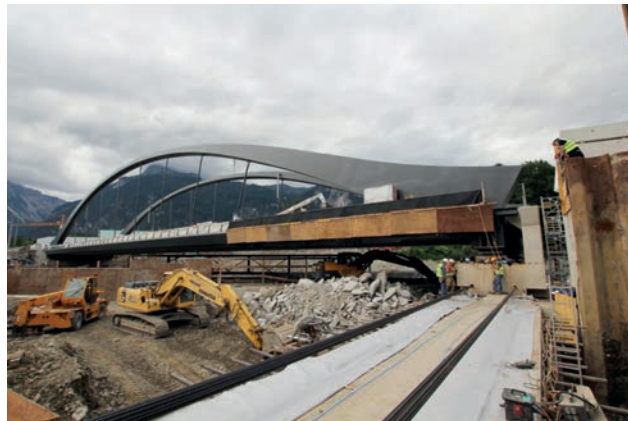
Durchführung des Querverschubs Bild: PORR AG
