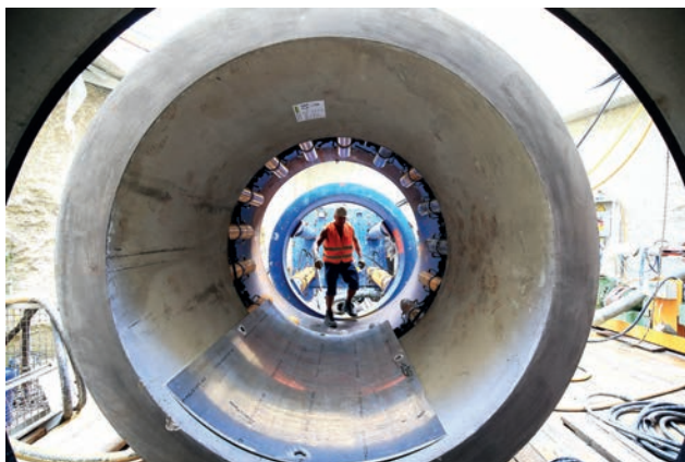
Presspipe DA 2500 Image: APA/Wien Kanal
