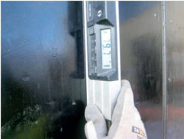
Ausrichtung und Kontrolle der geneigten Schalung Bild: PORR AG
