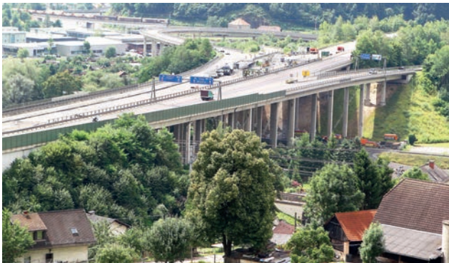
Tunnelkette Bruck Bild: PORR AG
