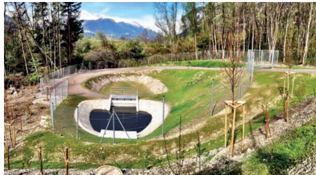
Gewässerschutzanlage – Filterbecken Nord Bild: PORR AG
