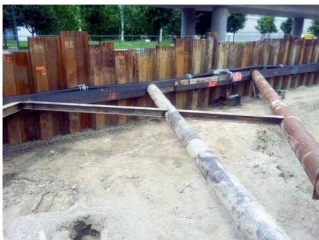
Baugrubenaussteifung und Grundwasserregulierung Bild: PORR AG
