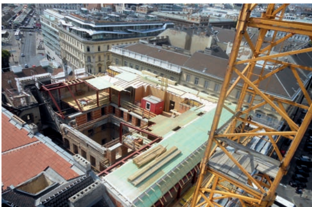
Die neuen Dachgeschosse des ehemaligen Wehli-Palais Bild: Porr AG
