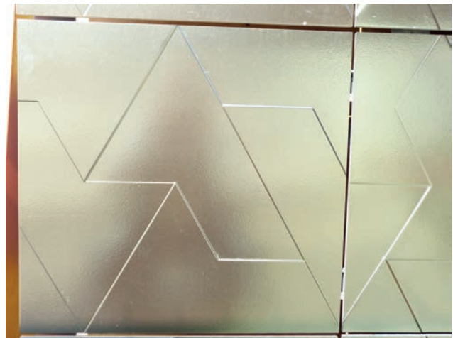
Fassadendetail Bild: PORR AG
