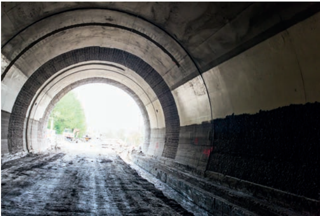
Abtrag Tunnel Bild: PORR AG
