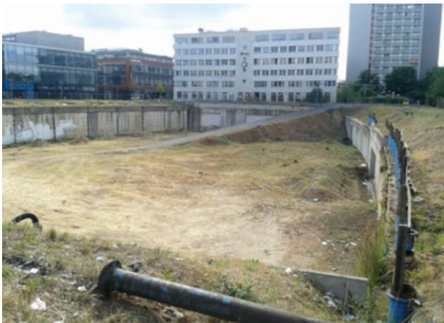
Baugrube Bild: PORR AG
