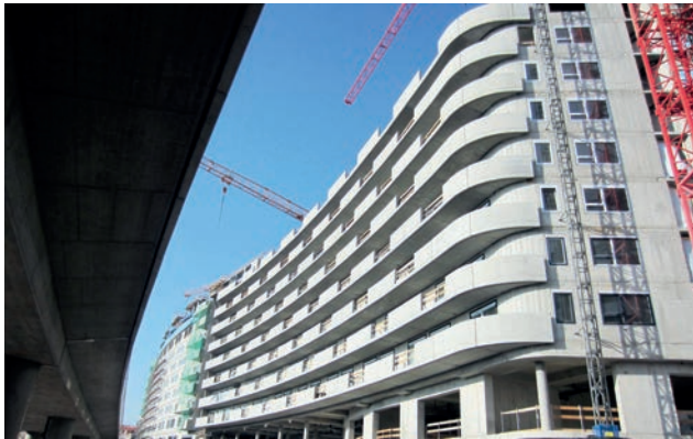
Südansicht – U-Bahnseite Bild: PORR AG
