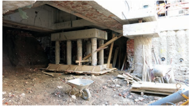
Abfangung des Gebäudes auf Pfahlgruppen DN 300 mm Bild: Stump
