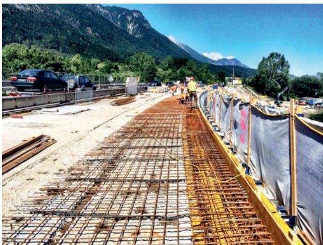
Kreuzungsbauwerk B5 – Bewehrungsarbeiten; Tragwerksverbreiterung Süd Bild: PORR AG
