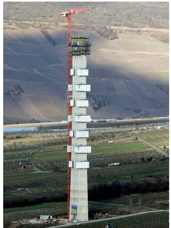
Blick auf die Selbstkletterschalung (SCF) Bild: PORR AG
