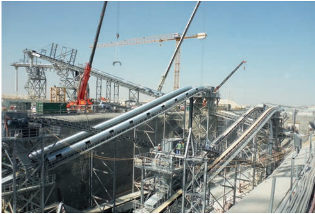
Station Al Messila – Förderbandanlage Bild: PORR AG
