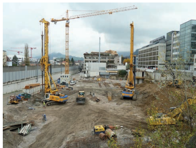
Gründung mit Großbohrpfählen Bild: PORR AG
