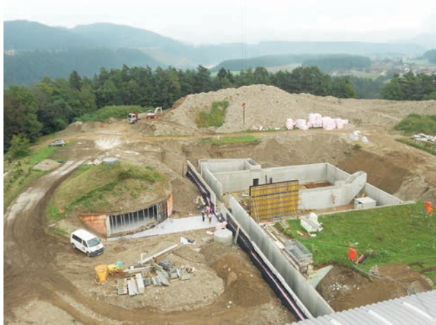
Bild 7: Glas- und Silbersammlung mit Verbindungsgang zu den Bestandsbauten Bild: PORR AG
