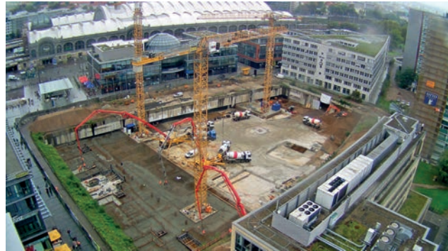
Bodenplatte Bild: PORR AG
