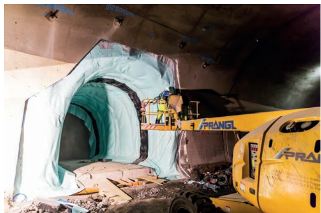
Querschlag 2 Bild: PORR AG
