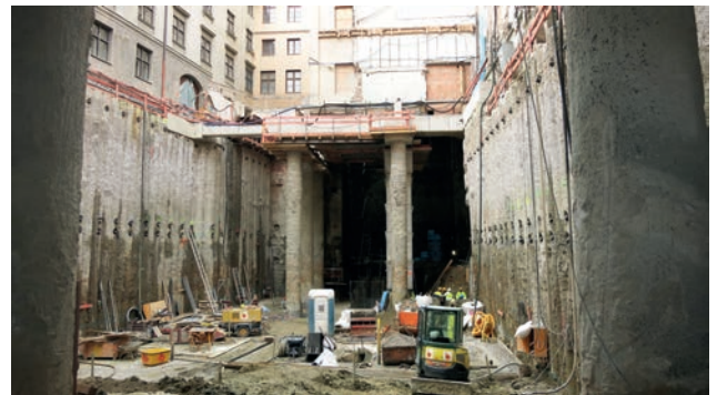
Einbau Sauberkeitsschicht auf Kote – 15 m Bild: PORR AG
