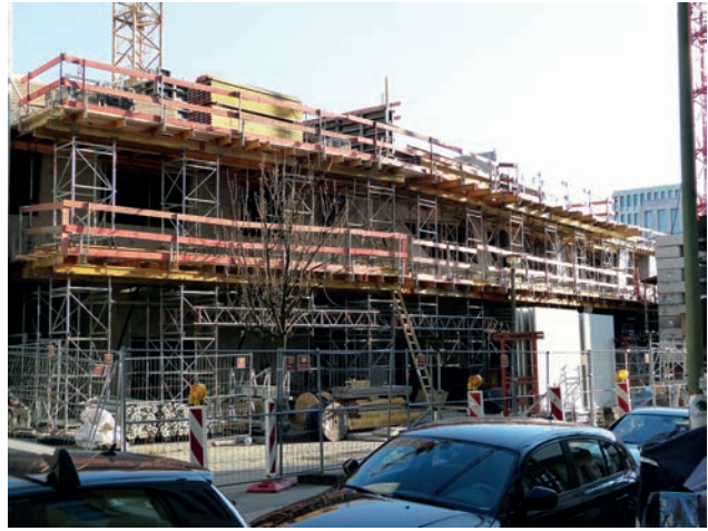
Fassadengerüst aus Schwerlasttürmen Bild: PORR AG
