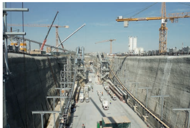
Station AI Messila – Förderbandanlage (im Aufbau) Bild: PORR AG
