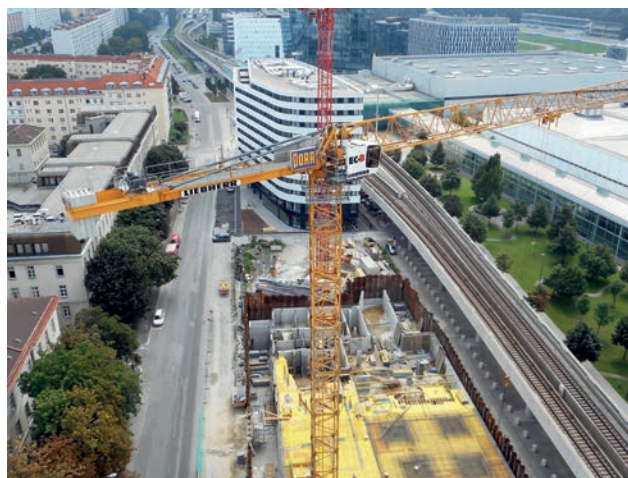
Beton- und Stahlbetonarbeiten Bild: PORR AG
