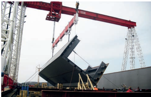
Kippen und Montage zu Überbauabschnitten Bild: PORR AG
