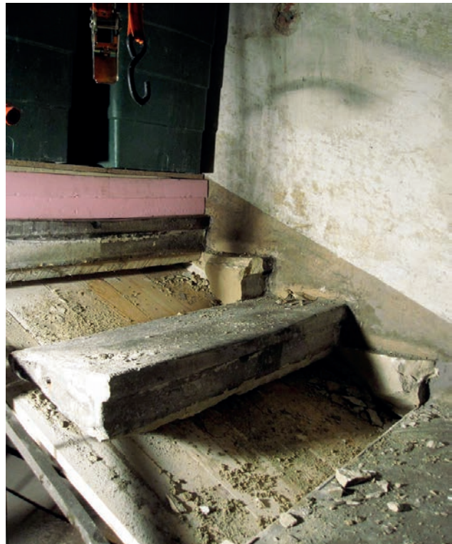
Zum Abbruch freigegebene Natursteinstiege wird bis zum Bruch belastet Bild: PORR AG
