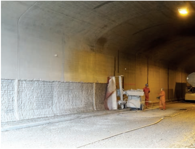
Betonabtrag durch HDW-Abtragsroboter – Mittelwand Bild: PORR AG
