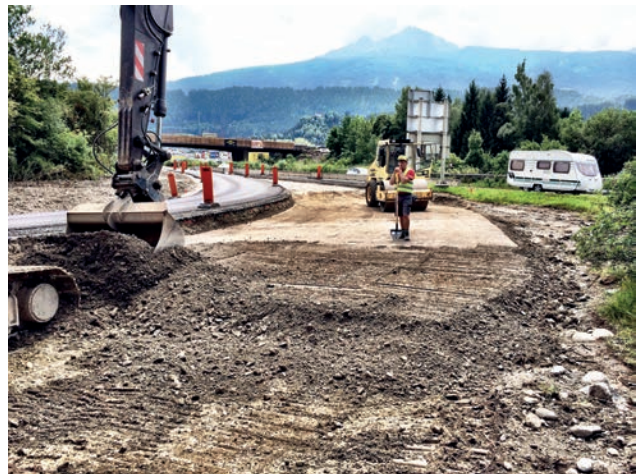
Straßenbauarbeiten im Bereich Rampe 100 Bild: PORR AG
