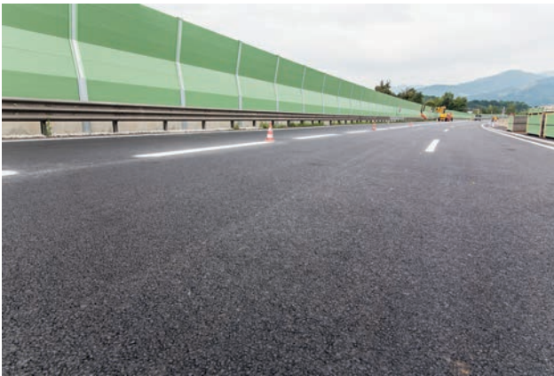
Fertige Fahrbahn Bild: PORR AG
