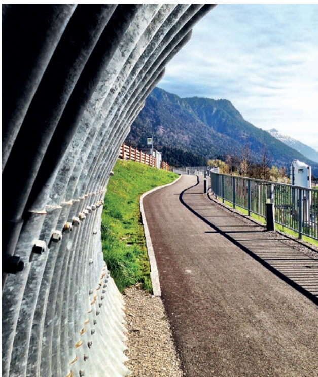
Stahl-Wellblechdurchlass – Radweg Bild: PORR
