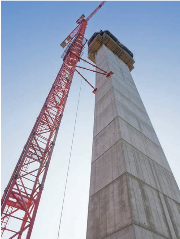
Detail Pfeileransicht mit Kranabspannung Bild: PORR AG
