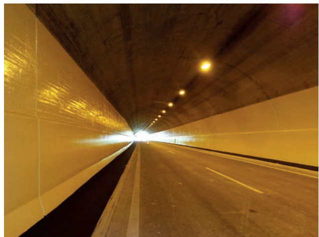
Fertigstellung der Instandsetzungs- und Beschichtungsarbeiten (Tunnelbereich) Bild: PORR AG
