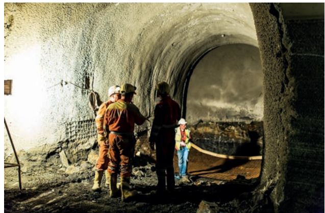
Querschlag 1 Bild: PORR AG
