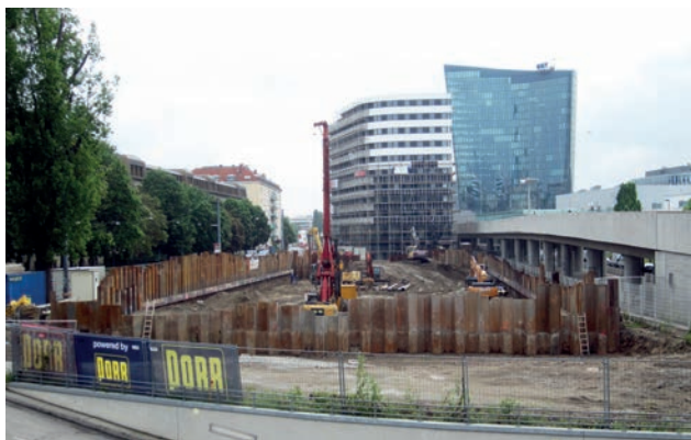
Baugrubensicherung Bild: PORR AG
