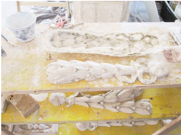
Restaurierungsarbeiten im Foyer des ehemaligen Wehli-Palais Bild: PORR AG
