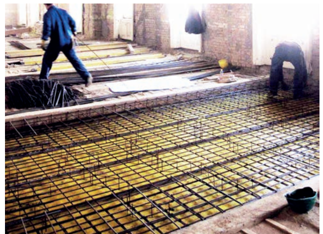
Schalungen der Deckenauswechslungen in der historischen Tramdecke Bild: PORR AG
