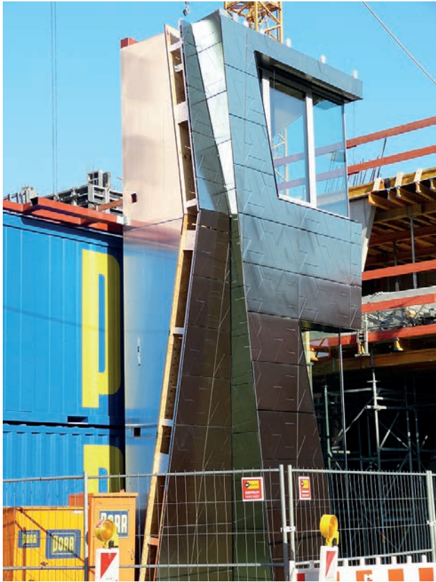
Musterfassade Bild: PORR AG
