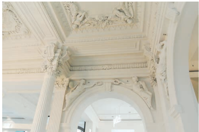
Restaurierungsarbeiten im Foyer des ehemaligen Wehli-Palais Bild: PORR AG
