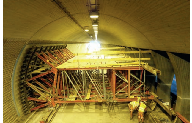
Schalwagen zur Herstellung der bergseitigen Vorsatzschale in der Simmeringgalerie Bild: PORR AG
