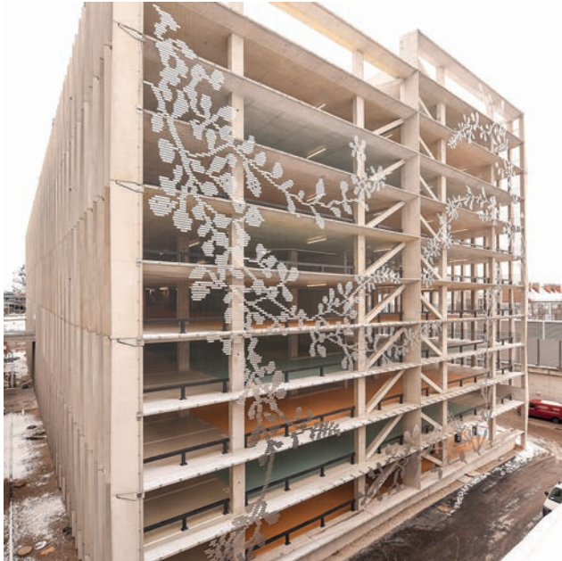
Netzfassade aus Edelstahl an der Stirnseite Bild: PORR AG
