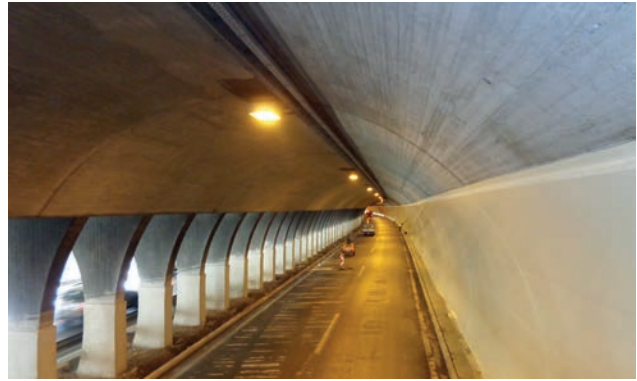
Beschichtungsarbeiten in der Simmeringgalerie (Nordröhre) Bild: PORR AG
