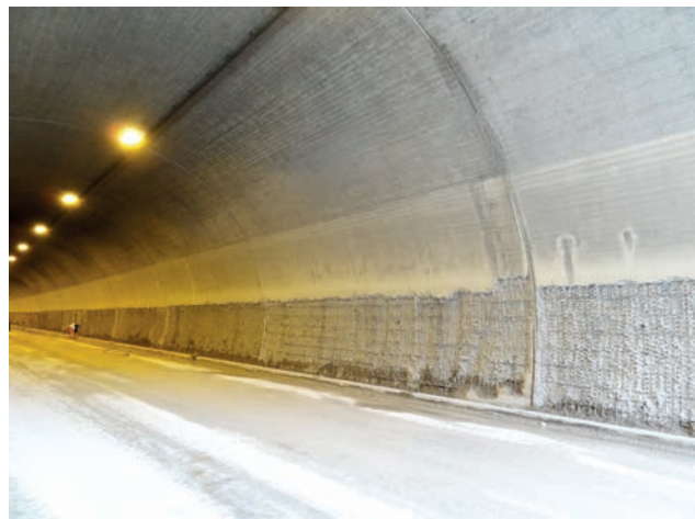
Betonabtrag durch HDW – talseitige Ulmenfläche Bild: PORR AG
