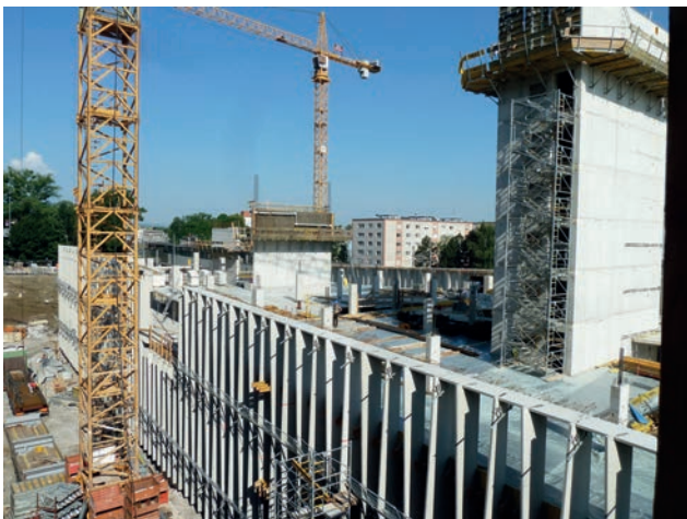
Bauablauf – Deckenherstellung Bild: PORR
