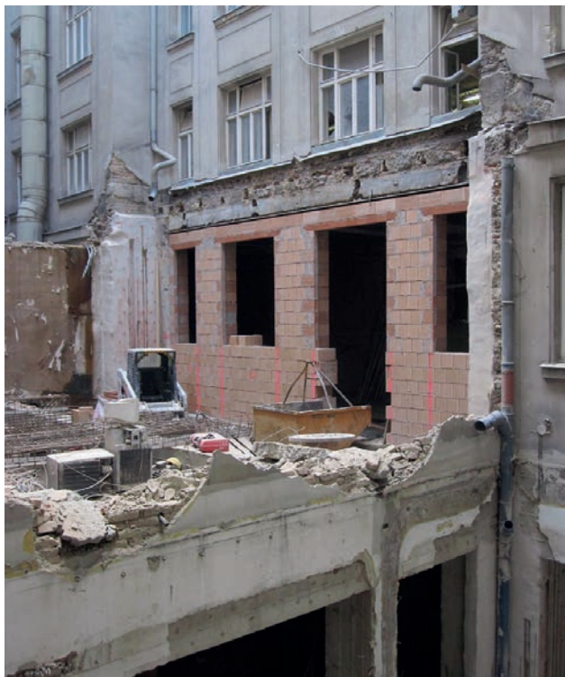
Abbruch der STB-Träger des ehemaligen Kinobodens und Herstellen einer durchgehenden Hoffassade Bild: PORR AG
