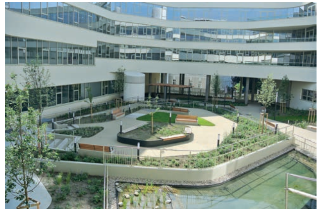
Hof Wachau (mit abgegrenztem Therapiebereich) Bild: PORR AG
