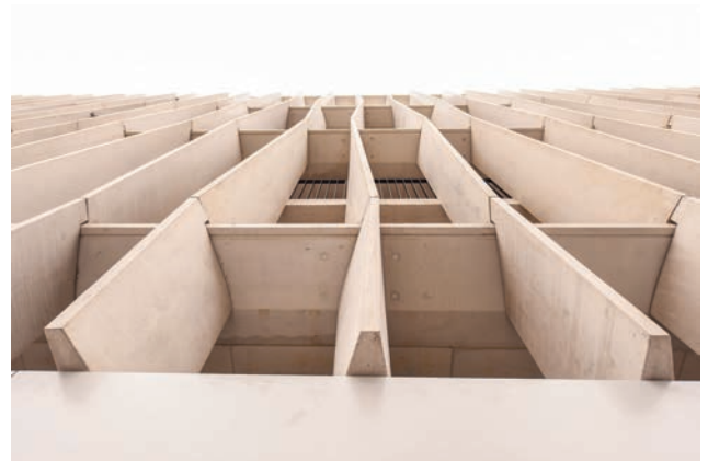
Lamellenfassade, Stützendetail Bild: PORR AG
