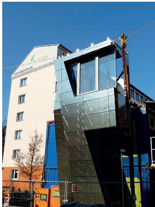
Musterfassade Bild: PORR AG
