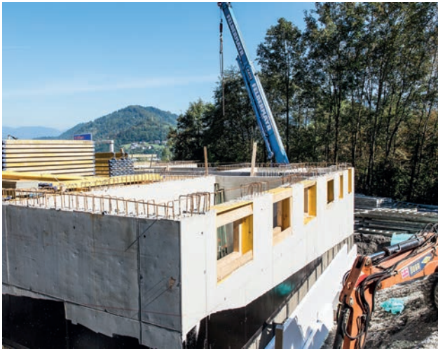
Betriebsgebäude Mitte Bild: PORR AG
