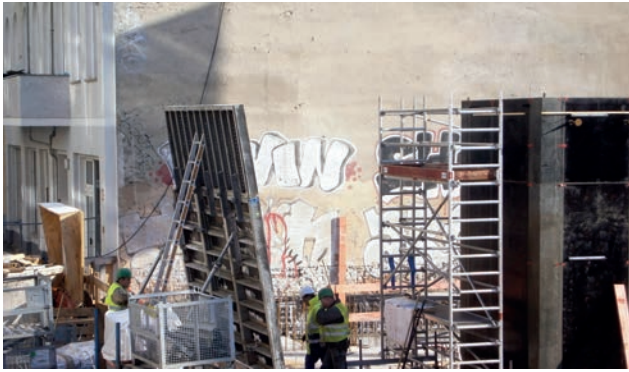
Lastabtragung der Schalung auf das Gerüst Bild: PORR AG
