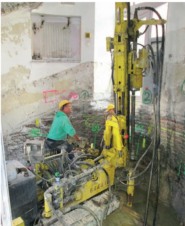
DSV-Herstellung in den Innenräumen Bild: PORR AG
