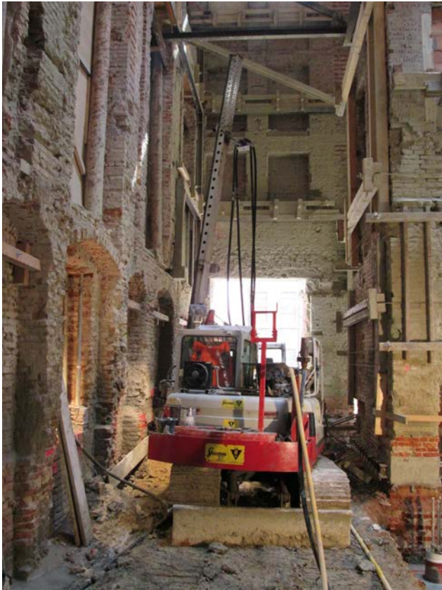
DSV-Herstellung in den Innenräumen Bild: PORR AG
