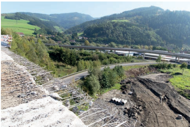
Gewässerschutzanlage Bild: PORR AG
