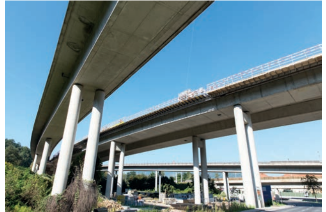
Brückensanierung „Talübergang“ Bild: PORR AG
