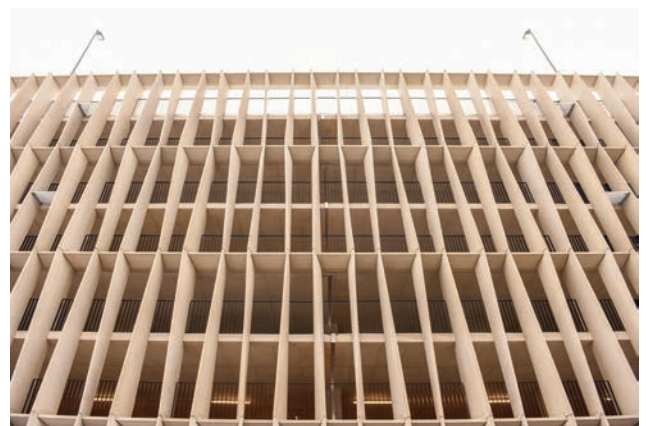
Lamellenfassade, Gesamtansicht Bild: PORR AG
