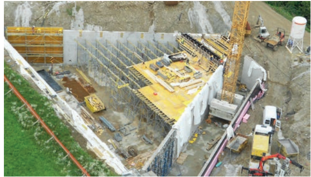
Bild 4: Trägerdecke Bild: PORR AG
