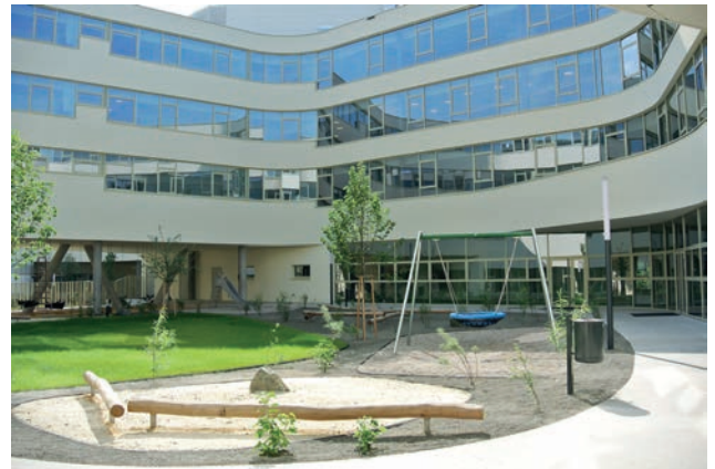
Innenhof Prater (dem Kindergarten gewidmet) Bild: PORR AG
