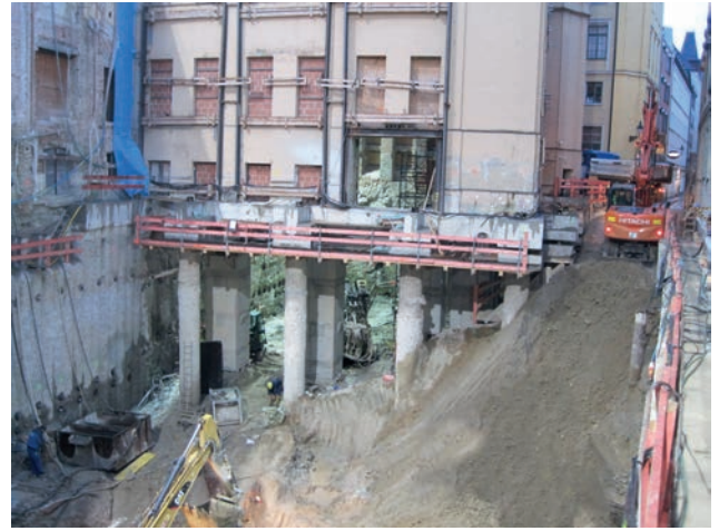
Logistik der Gesamtbaugrube über eine kleine Seitenstraße Bild: PORR AG
