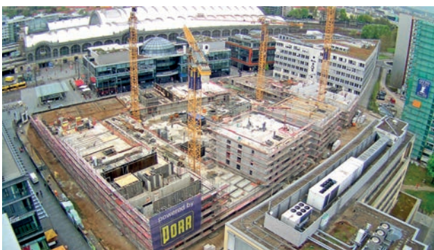
Rohbau Bild: PORR AG
