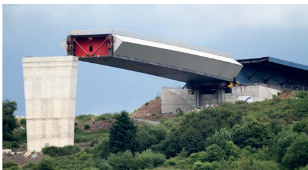
Verschub des Überbaus vor Pfeiler 10 Bild: LBM
