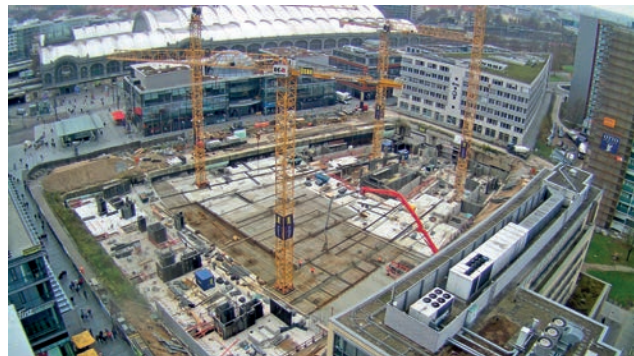
Decke 2. Untergeschoss Bild: PORR AG
