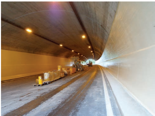
Maschinelle Beschichtungsarbeiten im Tunnel "Kirchenriese" (MÖ10) Bild: PORR AG
