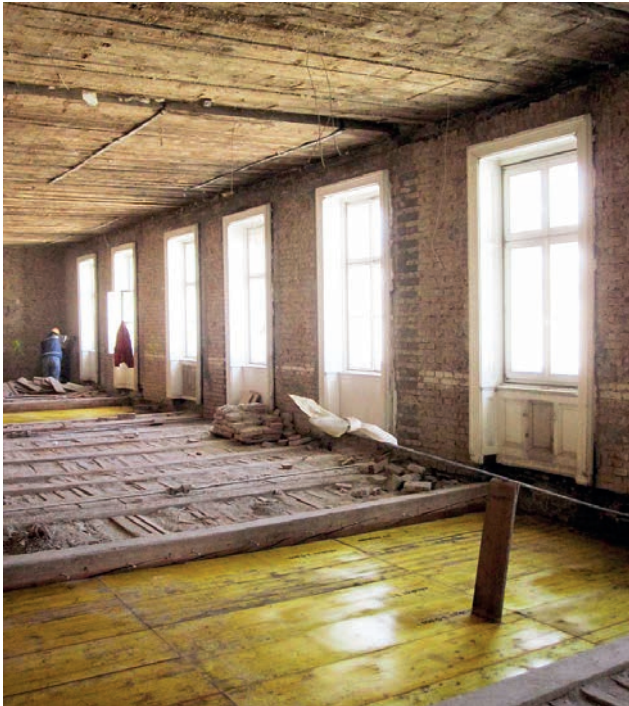
Schalungen der Deckenauswechslungen in der historischen Tramdecke Bild: PORR AG
