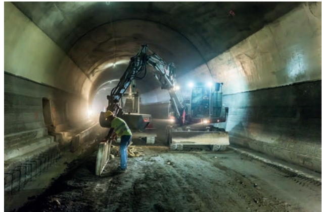
Auflagerverbreiterung Bild: PORR AG
