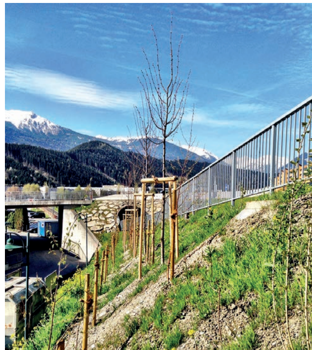
Landschaftsbau – bepflanzte Böschungsflächen Bild: PORR AG
