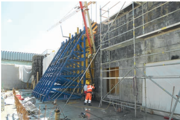
Bild 3: Einseitige Wandschalung der Wechselausstellung Bild: PORR AG
