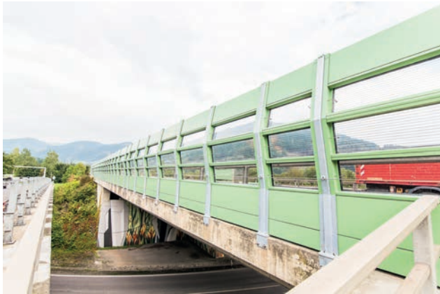
Lärmschutzwand Brücke Bild: PORR AG
