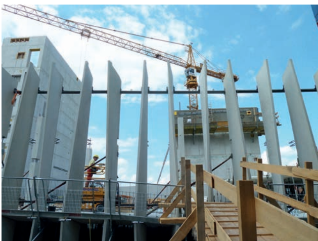
Bauablauf – Lamellenfassade Bild: PORR
