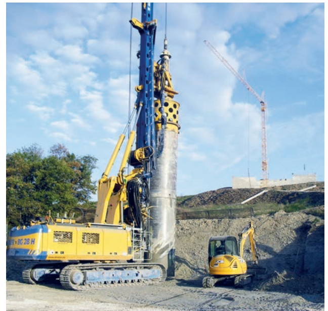
Herstellung der Bohrpfehlgründungen Bild: Brückner
