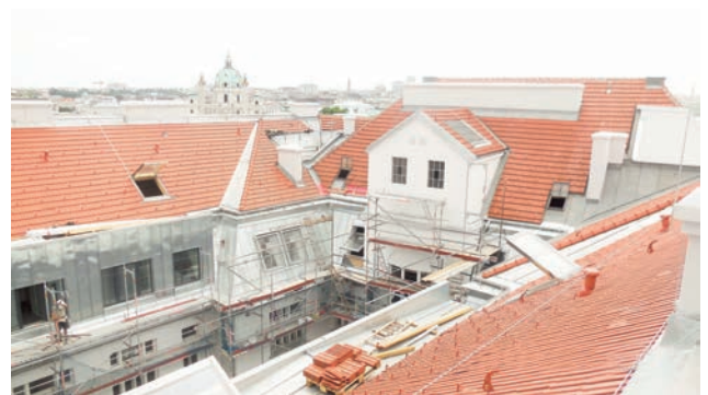
Neuerrichtung der Dachkonstruktion an den Hoftrakten Bild: PORR AG
