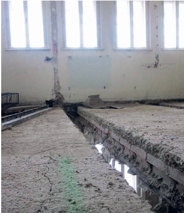
STB-Auswechslungen in der historischen Seideldecke Bild: PORR AG
