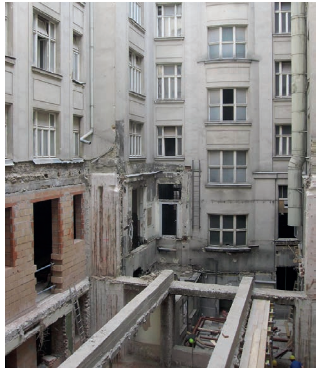
Abbruch der STB-Träger des ehemaligen Kinobodens und Herstellen einer durchgehenden Hoffassade Bild: PORR AG
