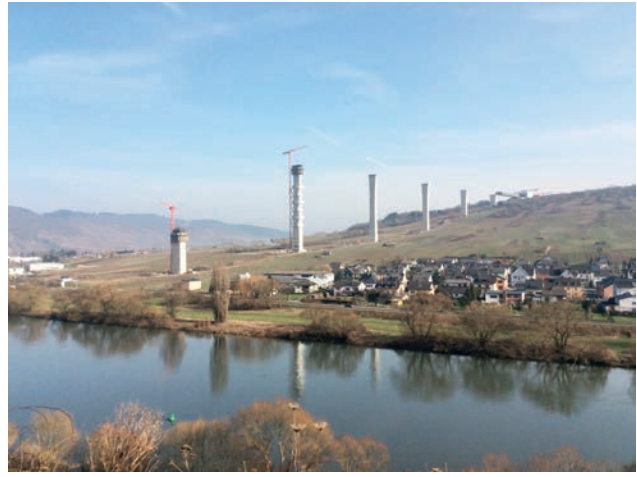
Ansicht auf die Pfeiler 5–10 Bild: Brückner
