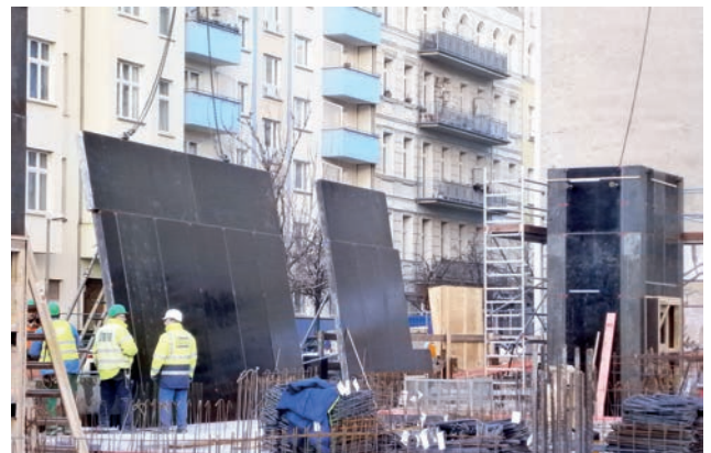
Stellen der Schalung für die geneigten Außenwände Bild: PORR AG
