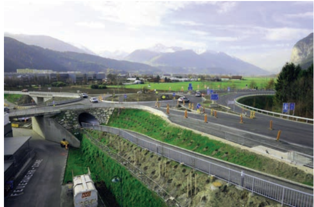
Kreisverkehr Süd – vor Endfertigstellung, Blickrichtung Süden Bild: PORR AG
