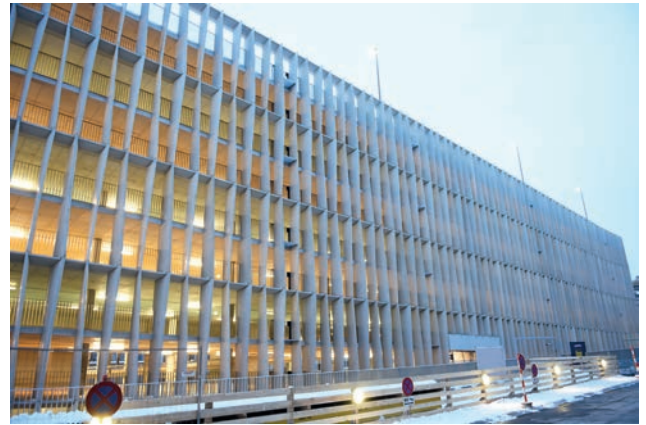
Lamellenfassade an der Längsseite Bild: PORR AG
