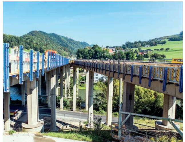
Brückensanierung Murbrücke Bild: PORR AG
