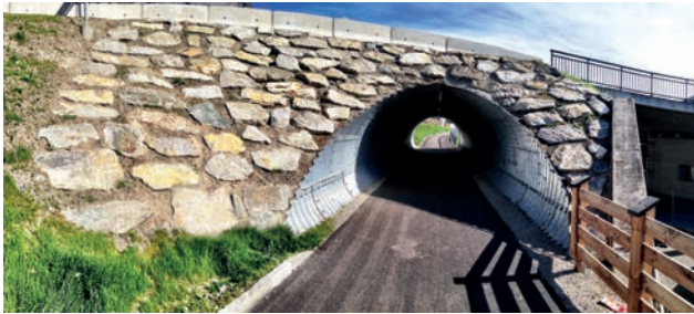
Stahl-Wellblechdurchlass – Radweg Bild: PORR
