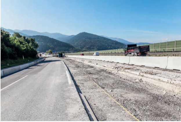
Fahrbahnabtrag Bild: PORR AG
