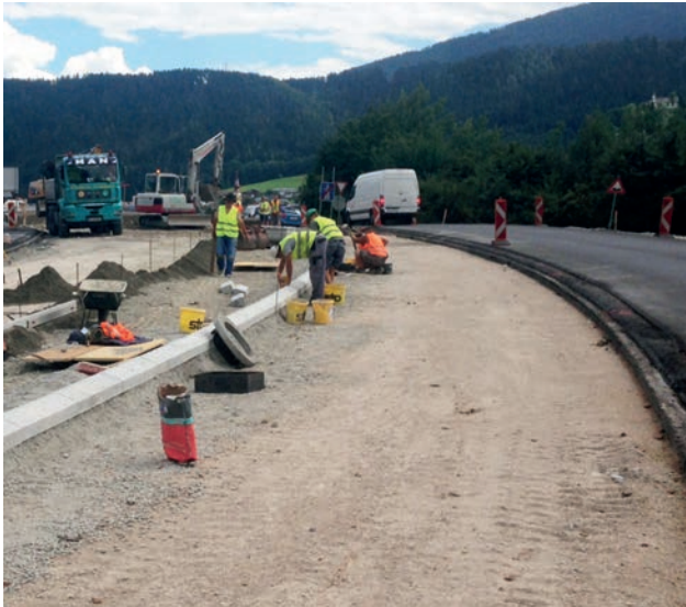
Randsteinverlegearbeiten im Bereich Rampe 300 / 200 Bild: PORR AG
