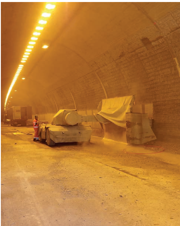
Betonabtrag durch HDW-Abtragsroboter – Mittelwand Ulmenfläche bis +5,0 m (Simmeringgalerie) Bild: PORR AG
