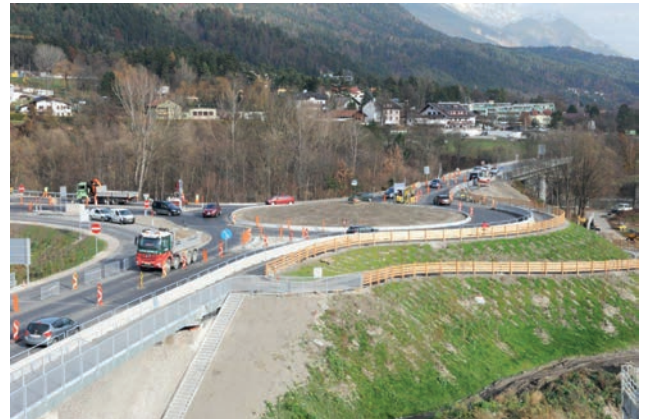
Kreisverkehr Nord – vor Fertigstellung Bild: PORR AG
