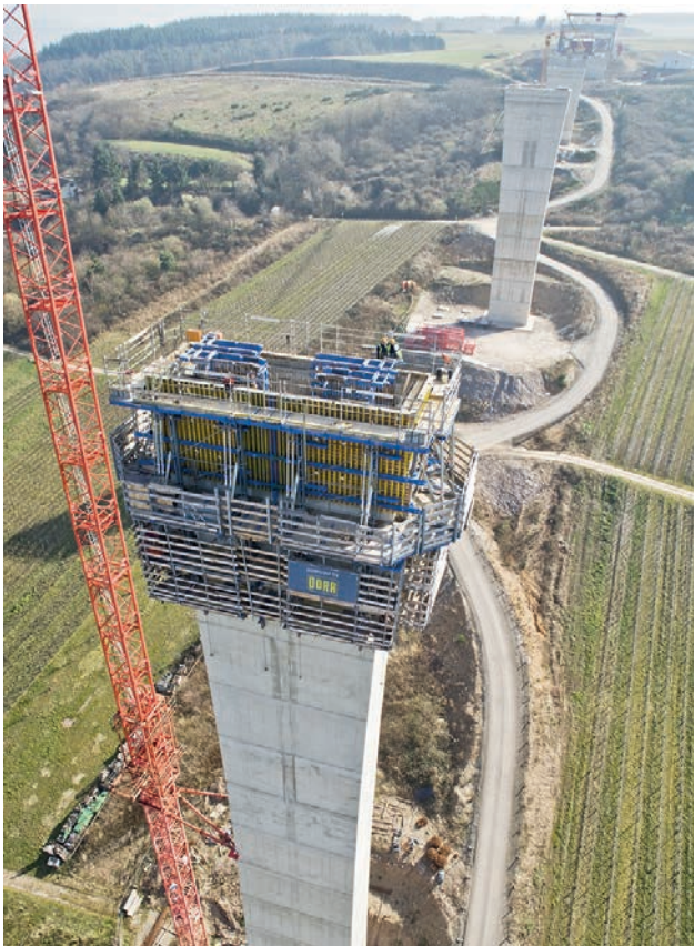
Blick auf die Selbstkletterschalung (SCF) Bild: Brückner
