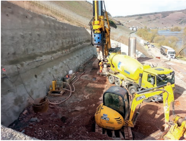
Hang- und Baugrubensicherung Bild: PORR AG
