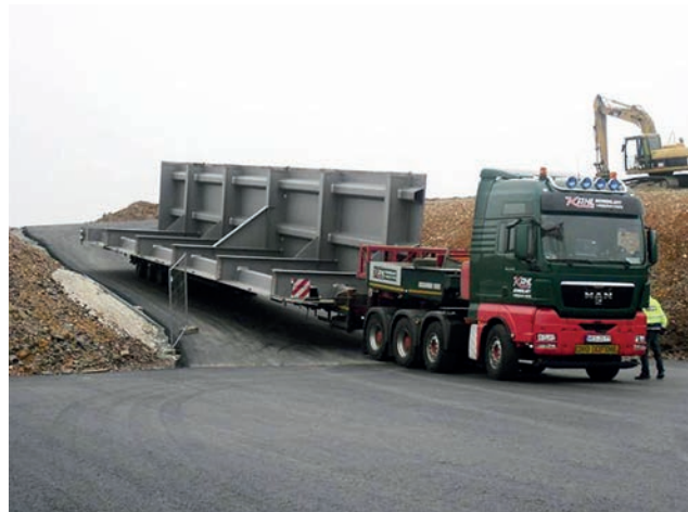
Anlieferung werksseitig gefertigter Bauteile Bild: PORR AG
