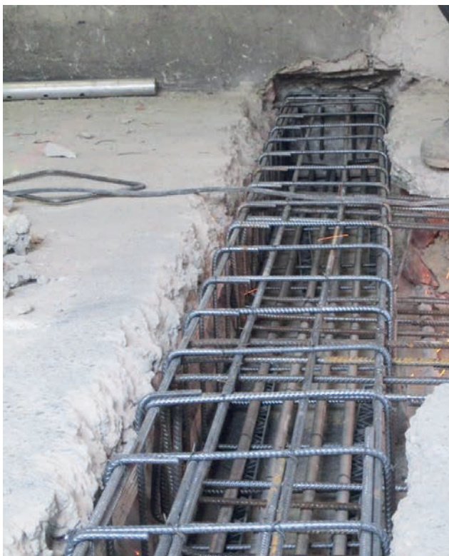
STB-Auswechslungen in der historischen Seideldecke Bild: PORR AG
