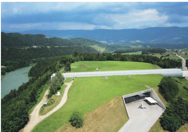
Bild 1: Bestandsbau 1. Bauphase – Hauptausstellungstrakt Bild: Museum Liaunig
