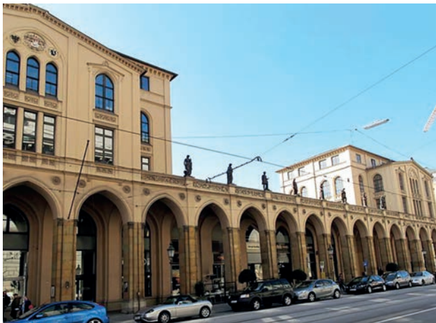
Bestandsgebäude entlang der Maximilianstraße Bild: PORR AG
