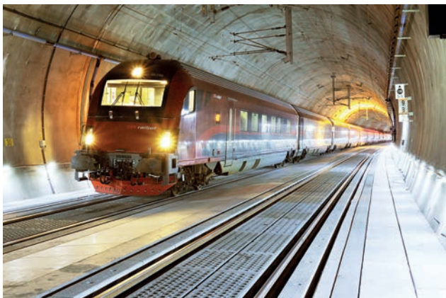
System ÖBB-PORR im Wienerwaldtunnel, gebaut in 2010/2011. Dieser Teil der Westbahnstrecke wird mit 250 km/h befahren. Bild: PORR AG
