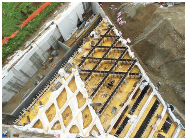
Bild 5: Herstellung Träger – Betonierabschnitt 3 Bild: PORR AG
