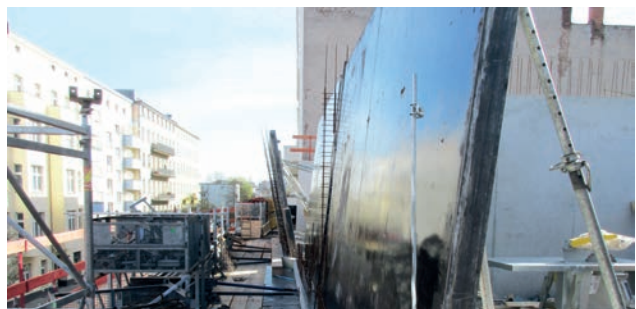
Arbeitsebene des Schalungsgestells Bild: PORR AG
