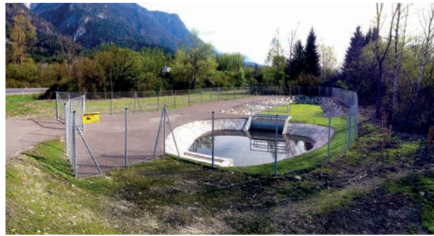
Gewässerschutzanlage – Filterbecken Süd Bild: PORR AG
