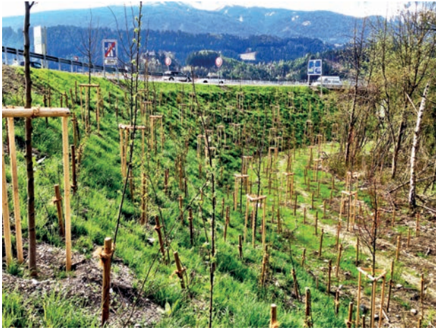
Landschaftsbau – beplanzte Böschungsflächen Bild: PORR AG
