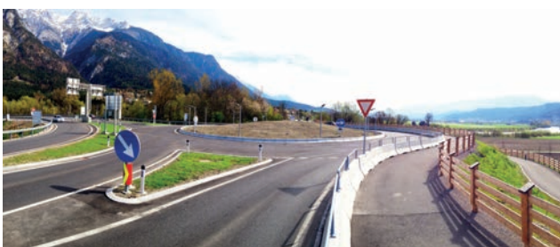
Kreisverkehr Nord – Endfertigstellung Bild: PORR AG
