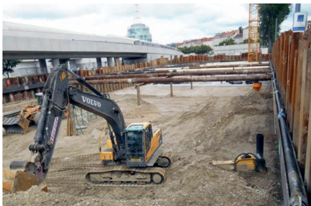
Baugrubensicherung Bild: PORR AG
