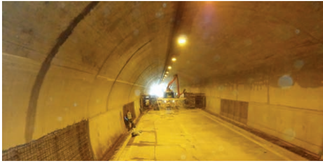
Schalwagen zur Herstellung der Vorsatzschale beidseitig (Tunnelbereiche) Bild: PORR AG
