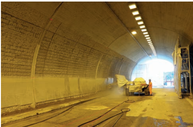
Betonabtrag durch HDW-Abtragsroboter – bergseitige Ulmenfläche bis +5,0 m (Simmeringgalerie) Bild: PORR AG
