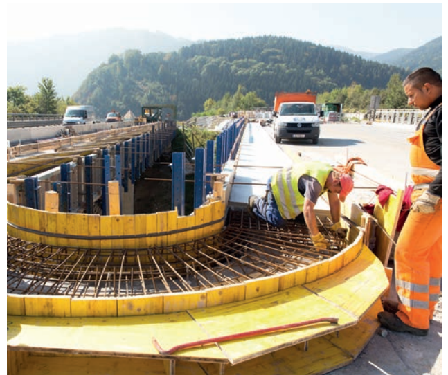
Randbalken Murbrücke Bild: PORR AG
