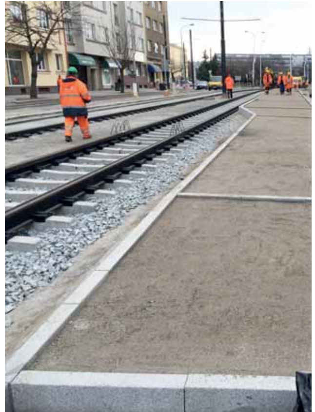
Haltestelle Kubánské náměstí (Richtung stadtauswärts). Fertigstellung der Unterbauschicht aus Beton C 20/25. Vorbereitung für die Montage der Geländer und des Vordachs vor dem Einbau der Gussasphalt-, Trenn- und Deckschichten (MA8). Bild: PORR AG
