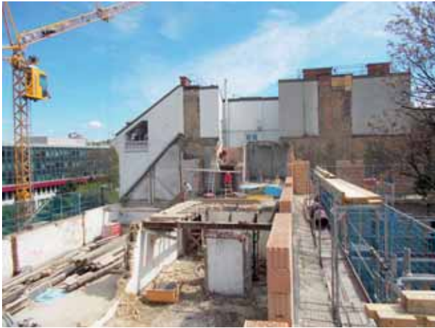
Abbruch des alten Dachstuhls und der Decken Bild: PORR AG
