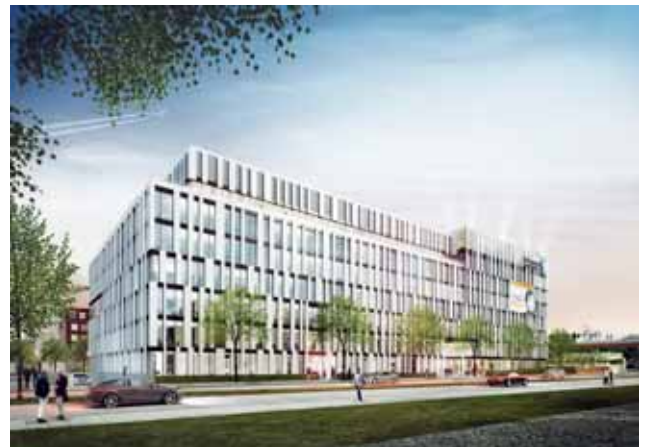
Das „La Tête“ liegt im Stadtviertel Quartier Central auf dem Gelände des ehemaligen Derendorfer Güterbahnhofes. Bild: Aurelis
