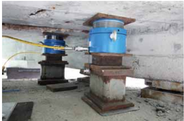
Pressen zum Anheben der alten Brücke Bild: PORR AG
