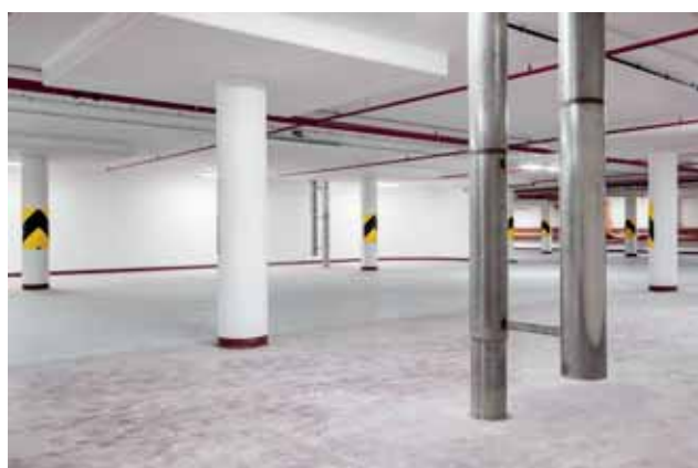
Abschlusselement des Überlaufes der Überflutungsrohrleitung im 2. Untergeschoss
