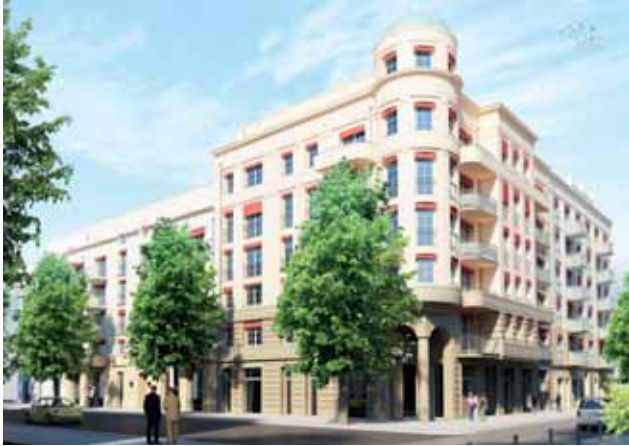
Die PORR Deutschland GmbH, ZNL Berlin Hochbau, setzt das Wohn- und Gewerbeprojekt am Maybachufer 36-38 in schlüsselfertiger Ausführung um. Bild: PSS Generalplanung GmbH & Patzschke Schwebel Architekten
