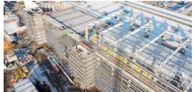
Der Rohbau Bild: Infineon
