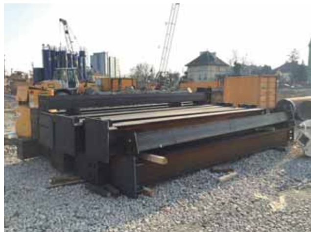
Einbau einer Hilfsstütze Bild: PORR AG
