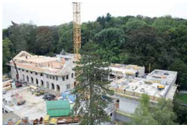
Luftbild des Bauvorhabens Bild: PORR AG
