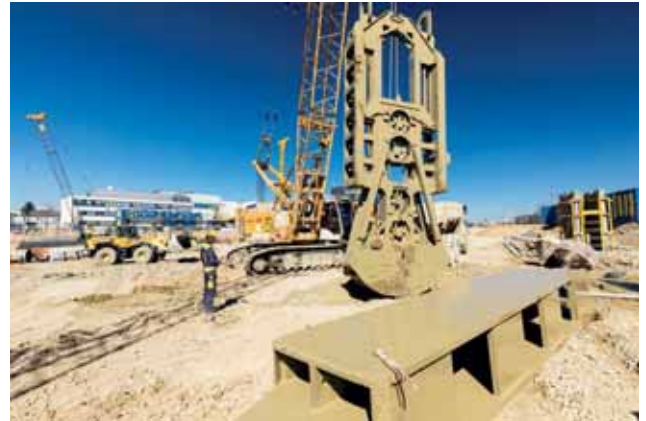
Spezialtiefbau-Maschine zur Schlitzwandherstellung Bild: PORR AG/Harry Schiffer
