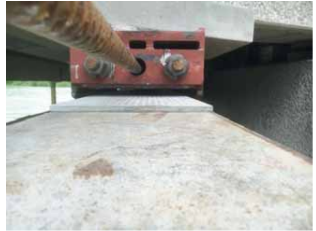
Verschiebkonstruktion inklusive Verschiebschlitten, bestehend aus einer Lage Niroblech gelagert auf Teflonplatten Bild: PORR AG
