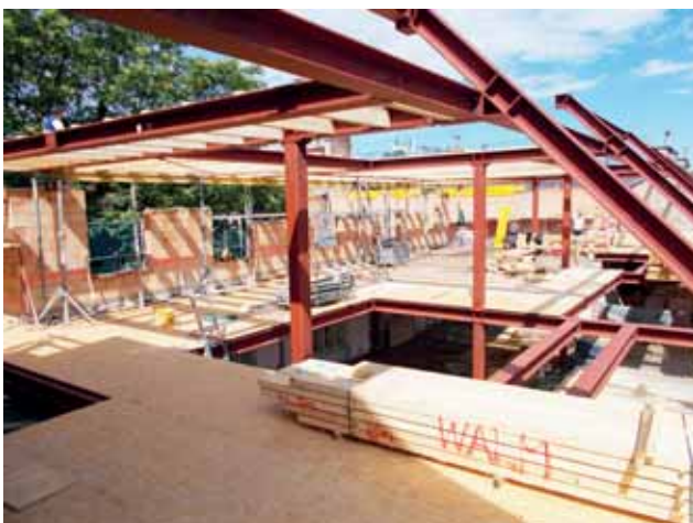
Zimmermannsmäßige Ausfachung der Stahlkonstruktion, Herstellung der neuen Deckenebene im Dachgeschoß Bild: PORR AG
