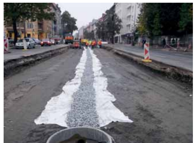
Sanierungsabschnitt des Bodenplanums im Bereich der künftigen Straßenbahnhaltestelle Bohemians (Richtung Stadtmitte). Inmitten der Konstruktion der Gleiskörper befindet sich die, im Sandbett verlegte, Drainageleitung DN 150, mit der Abtrennungstextilie und Schotteraufschüttung, Korngröße 16/32.
