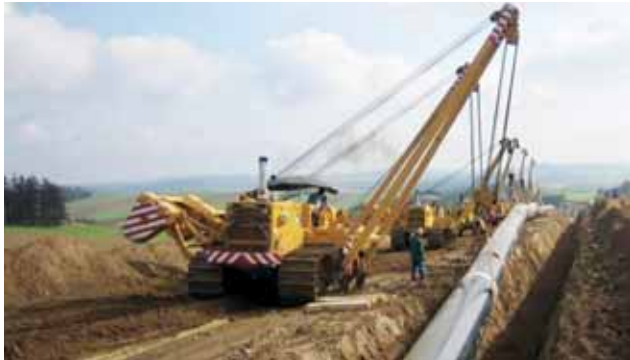
Das Absenken der Rohrstange Bild: bayernets
