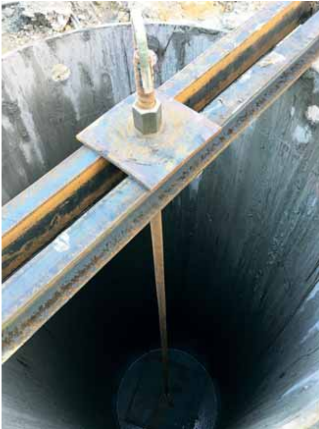
Einbau einer Hilfsstütze Bild: PORR AG
