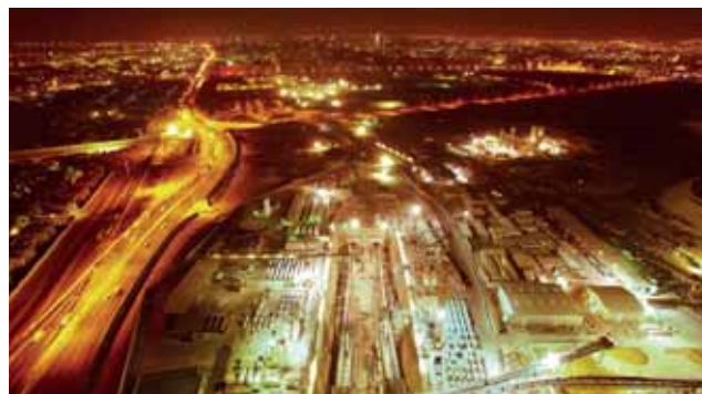
Startschacht Al Messila Bild: PORR AG
