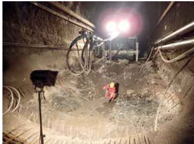
Sohlabschnitt vor SpC Bild: PORR AG
