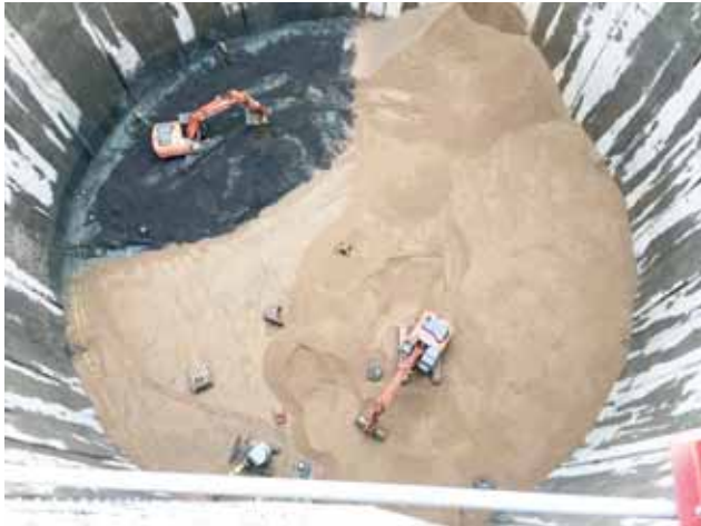
Bestehende Baugrube für das Pumpwerk Oberhausen Bild: PORR AG
