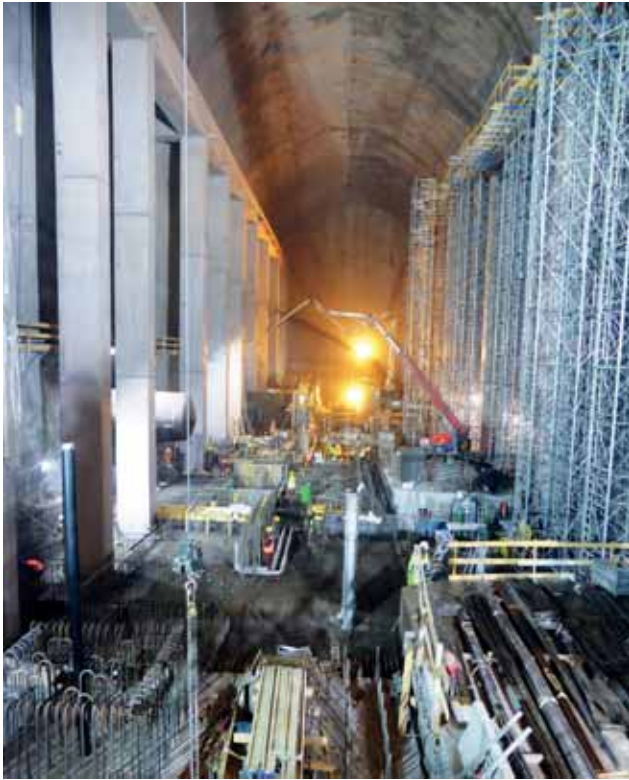
Maschinenkaverne, Innenausbau, Höhe Kranbahnpfiler bis zu 21,5 m Bild: ARGE Bau OVWII
