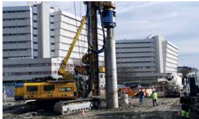
Bohrpfahlarbeiten U1/13 zwischen Favoritenstraße und Per-Albin-Hansson-Siedlung Bild: PORR AG
