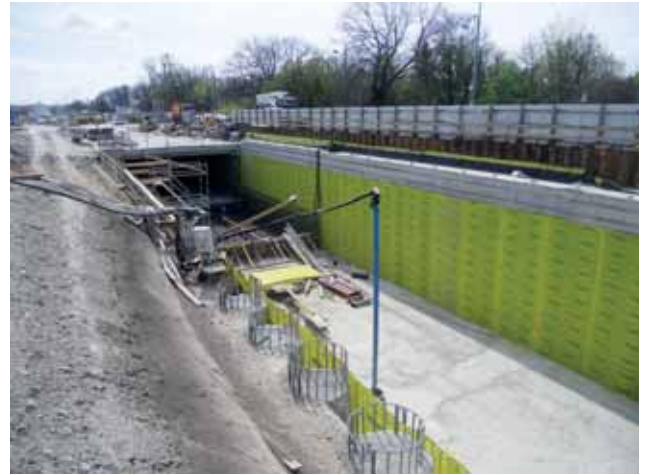
Offene Bauweise mit verllorener Schalung für Zwickelbeton zwischen Bohrpfehlern Bild: PORR AG
