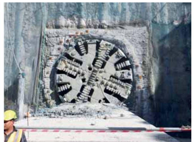
Finaler Durchschlag in Al Qadeem Bild: PORR AG
