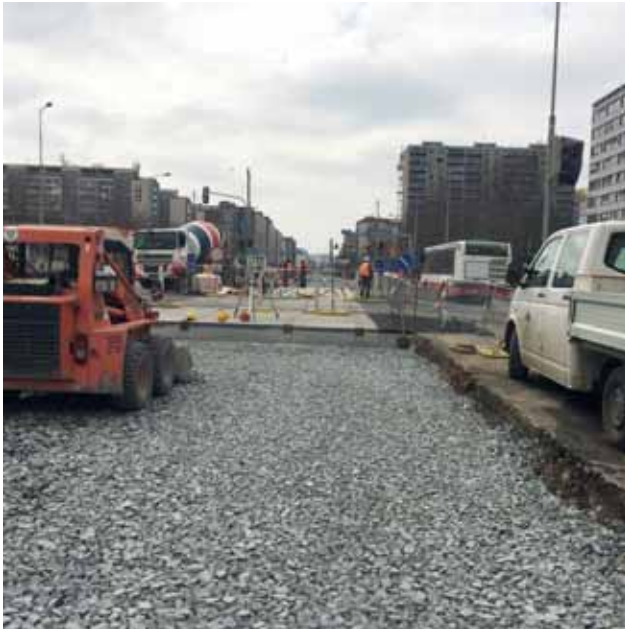
Abschlussarbeiten auf der Querung, bestehend aus Stahlbetonfertigteileplatten auf der Kreuzung der Straßen Vršovická – Bělocerkevská. Fertigstellung der Schotterbett-Unterbauschicht – Korngröße 32/63 – zur Verlegung der Schwellen. Bild: PORR AG
