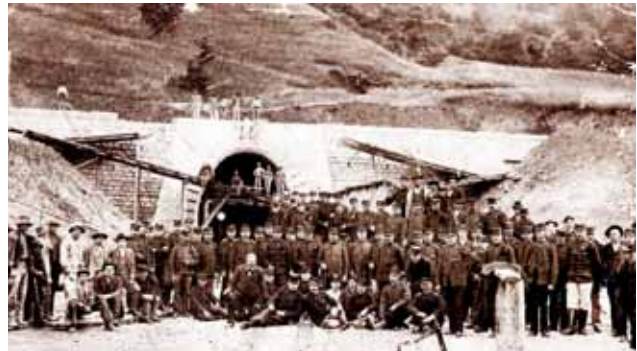
Baumanschaft 1904 Bild: PORR AG
