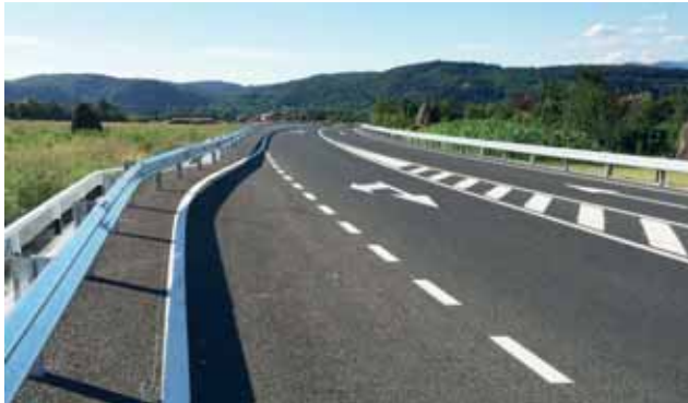
Ein durch die PORR fertiggestellter Abschnitt der Nationalstraße 76. Bild: PORR AG
