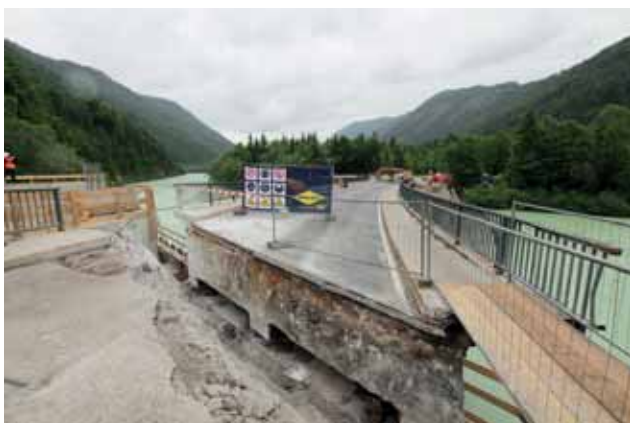
Brücke wurde sieben Tage gesperrt Bild: PORR AG
