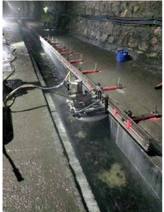
Auflager schneiden Bild: PORR AG
