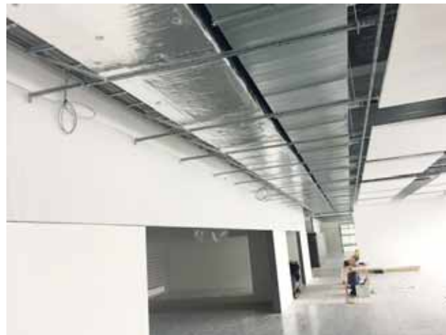
Obergeschoss 2 Nordwest Bild: PORR AG
