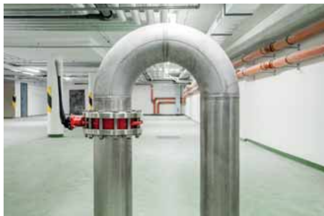
Planmäßige, gesteuerte Überflutung des 2. Untergeschosses durch Überflutungsbrunnen und Leitungen. Absperrarmaturen an den Rohrleitungen verhindern eine Überflutung des 1. Untergeschosses mit den technischen Anlagen
