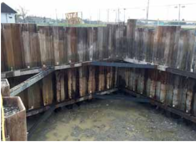
Dichte Baugrube mit Spundwänden und zwei Aussteifungshorizonten Bild: PORR AG
