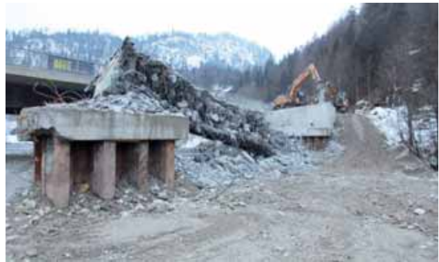
Rückbau der Baubereiche Bild: PORR AG
