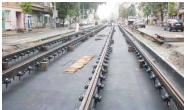
Abschnitt der Straßenbahnstrecke an der künftigen Haltestelle Bohemians (Richtung stadtauswärts), Blick Richtung Kreuzung Minská mit der künftigen, festen Fahrbahnoberfläche mit Zementbetondeckschicht. Verlegung der L-Profile komplett, schwingungsdämpfende Matten und Fixierung der Gleise vor dem Einbau des Betons C30/37 XF4. Bild: PORR AG
