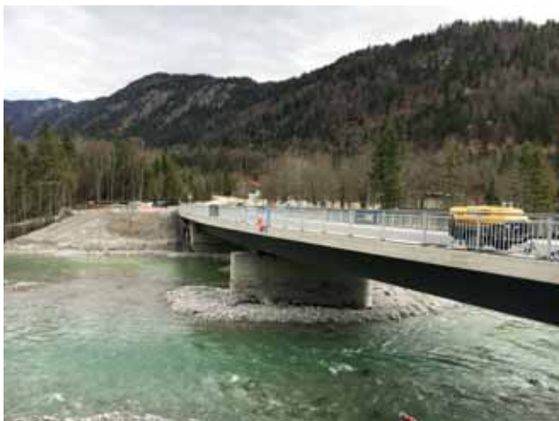
Fertigstellung der Brücke Bild: PORR AG
