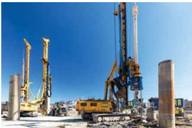
Herstellung einer überschnittenen Bohrpfahlwand im Nahbereich des Tunnels Bild: PORR AG/Harry Schiffer
