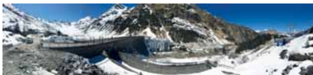
Hauptbaustelleneinrichtung am Fuß der Staumauer Vermunt: Materialaufbereitung, Kieswerk, zwei Betonmischanlagen, Betonlabor, Werkstätten, Lagerflächen Bild: ARGE Bau OVWII
