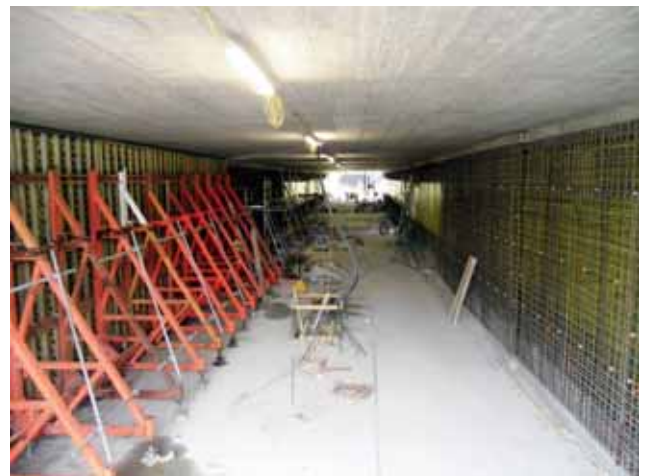
Schalungs- und Bewehrungsarbeiten der Innenschalen unter Deckel Bild: PORR AG
