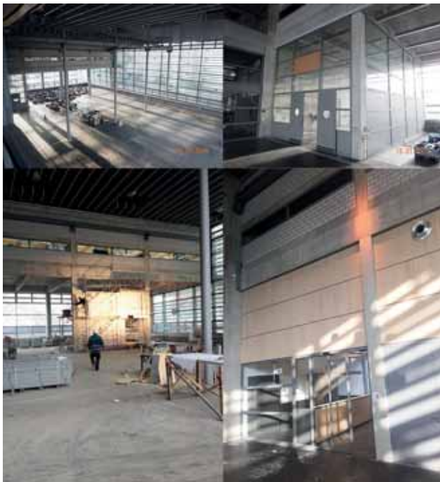
Dom vom Bestand bis fertiger Haupteingang Bild: PORR AG
