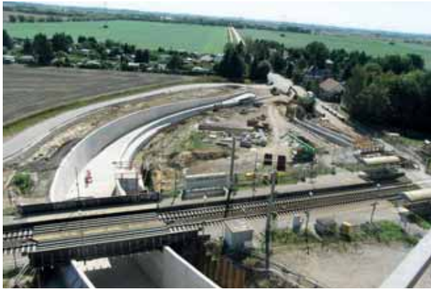
Eisenbahnüberführung Hohenthurm Bild: PORR AG
