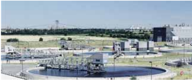
Die Kläranlage Waßmannsdorf Bild: Berliner Wasserbetriebe
