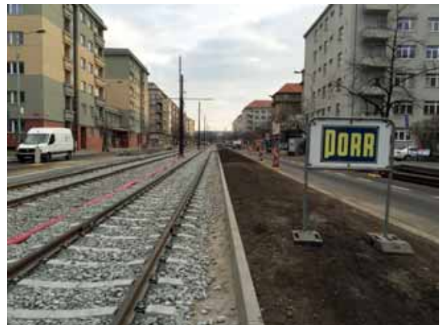
Abschnitt der Straßenbahnstrecke ab der Haltestelle Slavia (Richtung stadtauswärts) – Kubánské náměstí. Gleisstopfen komplettiert, Vorbereitung für Einbringen des Mutterbodens zur Herstellung der künftigen Grasoberfläche der Straßenbahnstrecke. Bild: PORR AG
