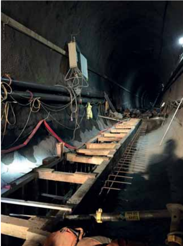
Schalung Mittelkanal Bild: PORR AG
