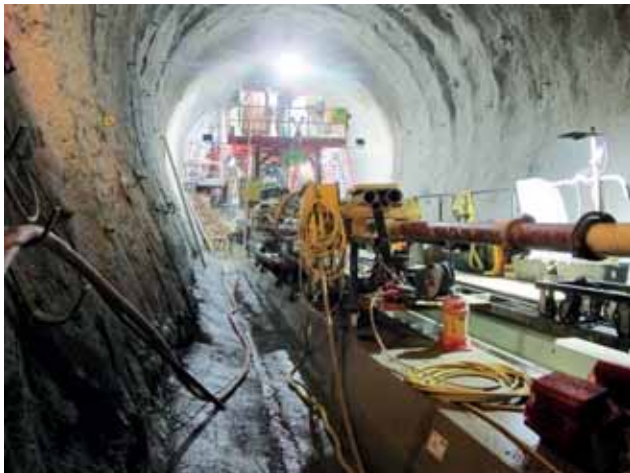
Silvrettastollen, Innenausbau, Sohlübbling vorausseilend, Gewölbeschalwagen nachlaufend Bild: ARGE Bau OVWII
