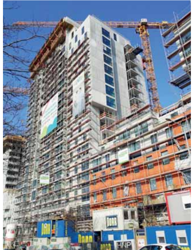
Der Rohbau Bild: STRAUSS & PARTNER
