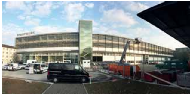
Umbau Projekt Schöntal Bild: PORR AG
