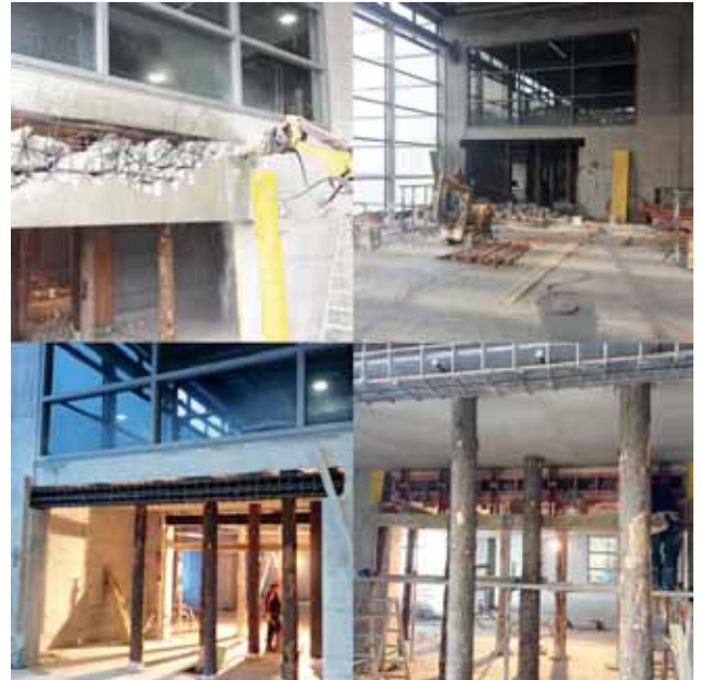
Kürzen des Unterzuges Bild: PORR AG
