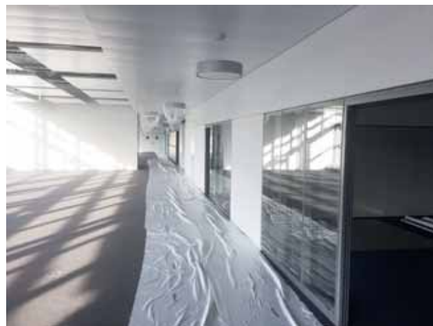
Obergeschoss 2 Nordwest im fertigen Zustand Bild: PORR AG
