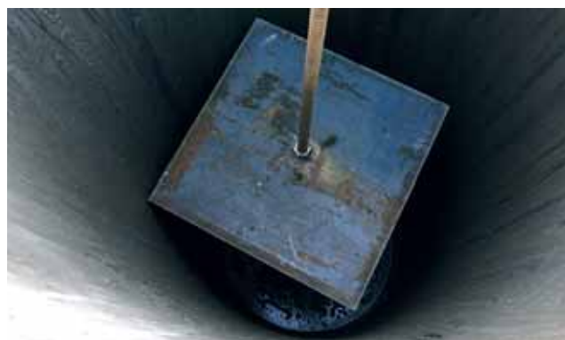
Einbau einer Hilfsstütze Bild: PORR AG
