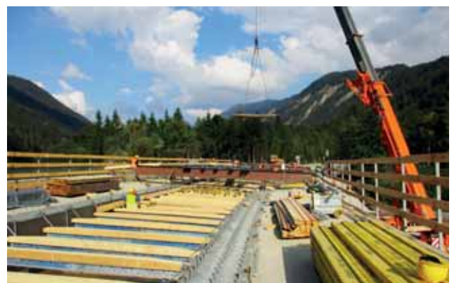
Fertigstellungsarbeiten Bild: PORR AG
