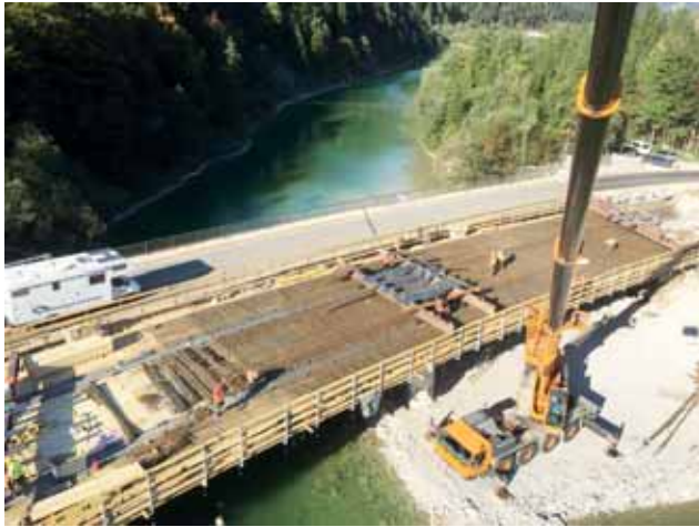
Fertigstellungsarbeiten Bild: PORR AG
