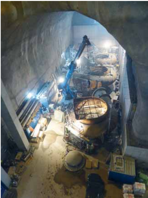
Trafokaverne, Vormontageplatz Pumpen- und Turbinenspiralen Bild: ARGE Bau OVWII
