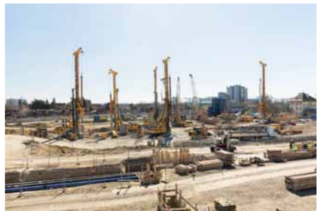
Einzigartige Konzentration an Spezialtiefbau-Großgeräten in Österreich Bild: PORR AG/Harry Schiffer
