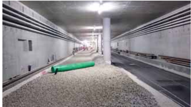
Einbau Schallschutzmatten und Schotteroberbau in Tieflage Bild: PORR AG
