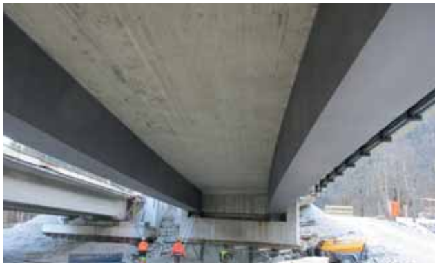
Unterbau der Brücke Bild: PORR AG
