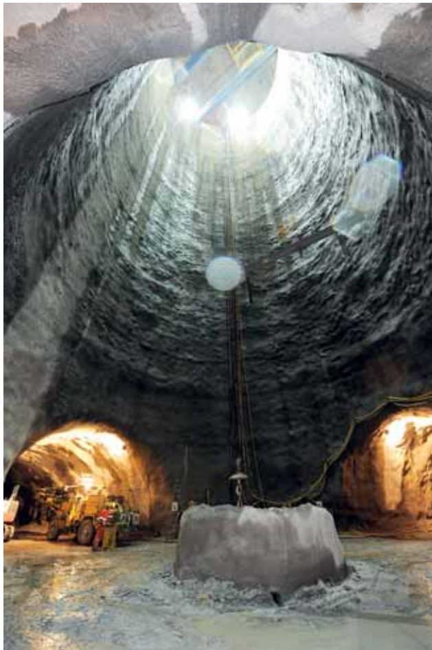
Wasserschloss Krespa, Steigschacht im Ausbruch fertiggestellt, Kalottenvortrieb, untere Kammern in Arbeit Bild: VIW
