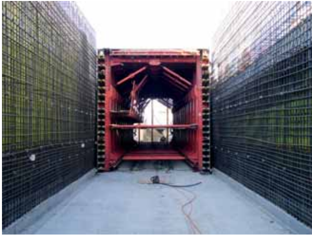
Innenschalenbewehrung im Bereich Tourengleis 2 mit Schalwagen Bild: PORR AG
