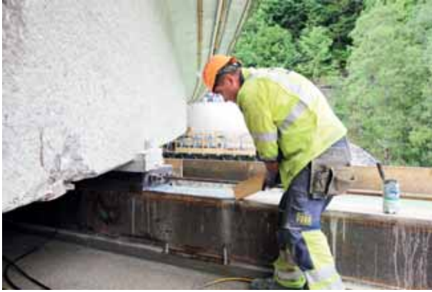
Vorbereitungen für den Querverschub Bild: PORR AG
