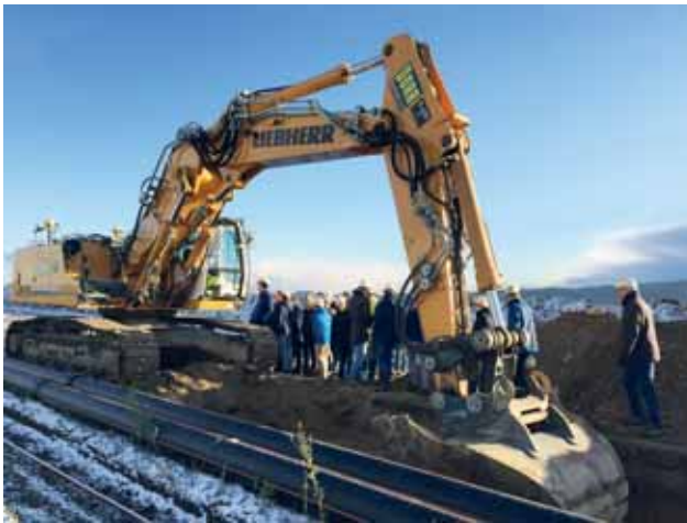
Exkursion der HTL Krems beim Vortriebsbagger mit Trapezlöffel und 3D-Steuerung Bild: PORR AG
