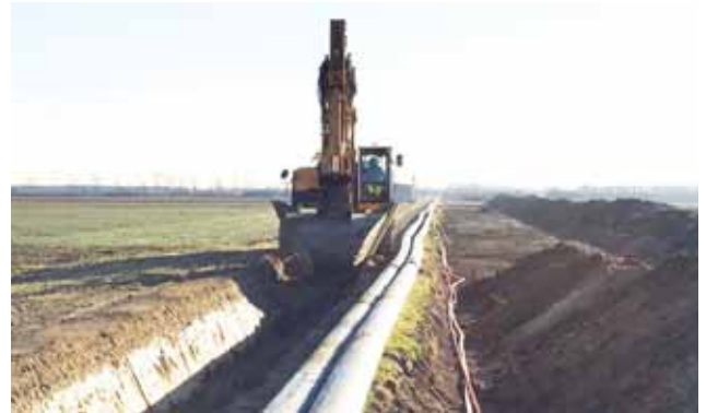
Verlegen der vorgeschweißten PE-HD-Rohre Bild: PORR AG
