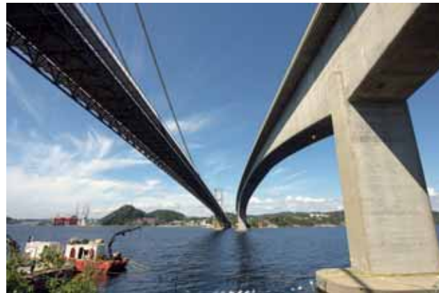
Vorbereitungen für die erste Unterwassersprennung Bild: PORR AG
