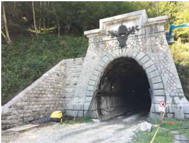
Tunnelportal Nord Sanierung Bild: PORR AG
