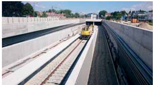
Gleisbauarbeiten im Bereich der offenen Streckenführung Bild: PORR AG
