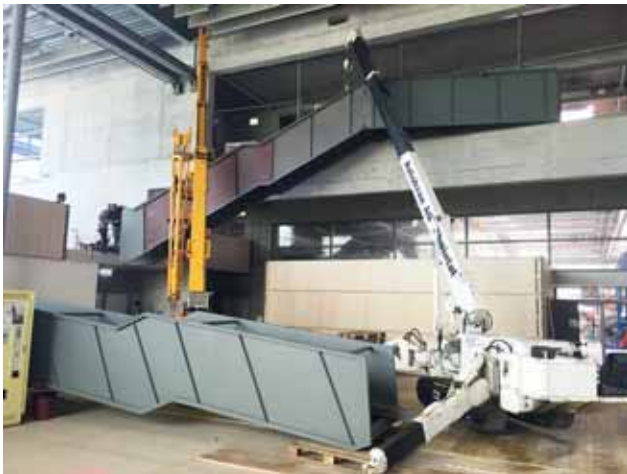
Einbau Stahltreppe Bild: PORR AG
