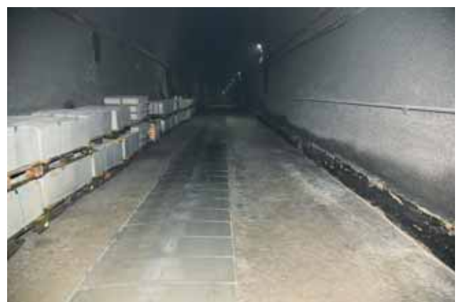
Fertige Tunnelsohle Bild: PORR AG
