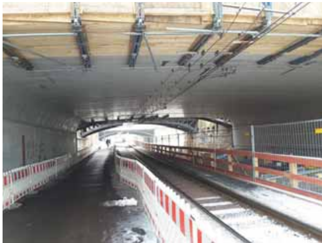
Der Unterführungsbereich für Passanten, Radfahrer und Straßenbahnen Bild: PORR AG
