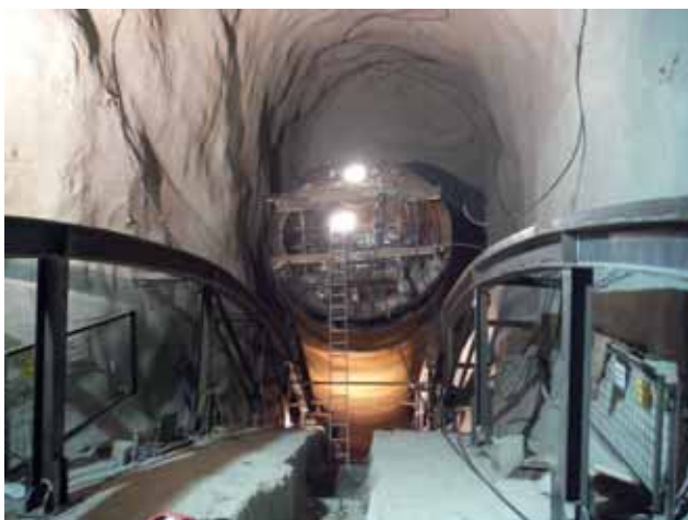
Druckschacht, oberer Vertikalkrümmen, Einbau Stahlpanzerung, Innendurchmesser 4.5 m Bild: ARGE Bau OVWII
