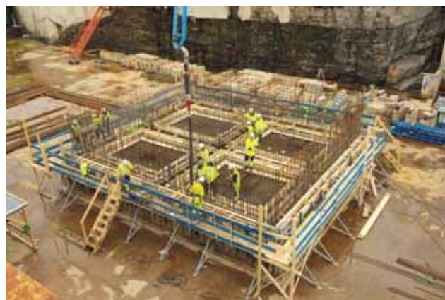
Entstehung eines Brückenfundaments im Trockendock Bild: PORR AG
