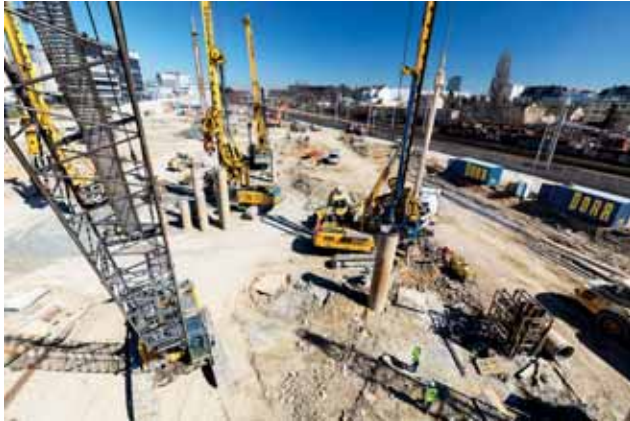
Herstellung der Bohrpfahlwände zur Baugrubenumschließung Bild: PORR AG/Harry Schiffer
