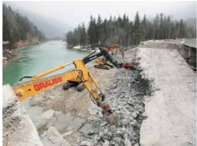
Rückbau der Baubereiche Bild: PORR AG
