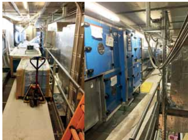
Beengte Verhältnisse in der Technikzentrale Bild: PORR AG
