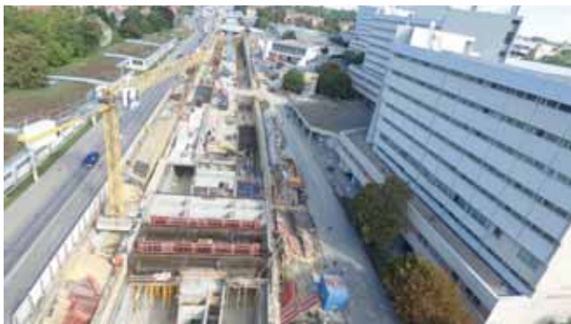
Baustellenübersicht mit Stellwerksgebäude im Vordergrund Bild: PORR AG
