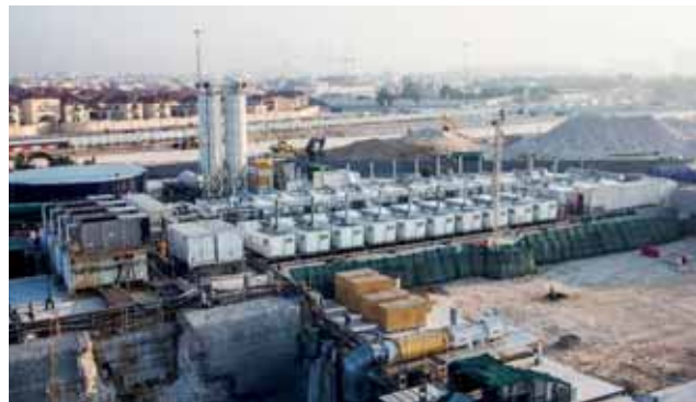
Dieselgeneratoren Startschacht Al Messila Bild: PORR AG
