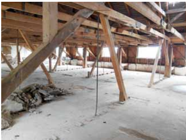
Freigelegter Dachstuhl Bild: PORR AG
