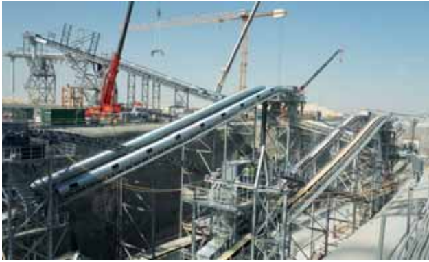
Förderbandanlage Startschacht Al Messila Bild: PORR AG
