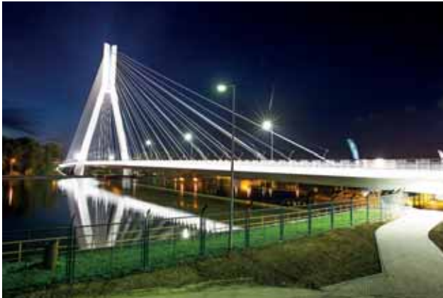
Die Tadeusz-Mazowiecki-Brücke in Rzeszów Bild: PORR AG
