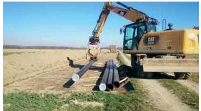
Manipulation der Rohre (Stangenlänge 16 m) mit adaptiertem Sortiergreifer auf Mobilbagger Bild: PORR AG
