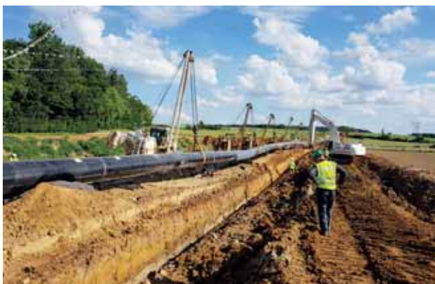
Rohrgrabenaushub Bild: bayernets
