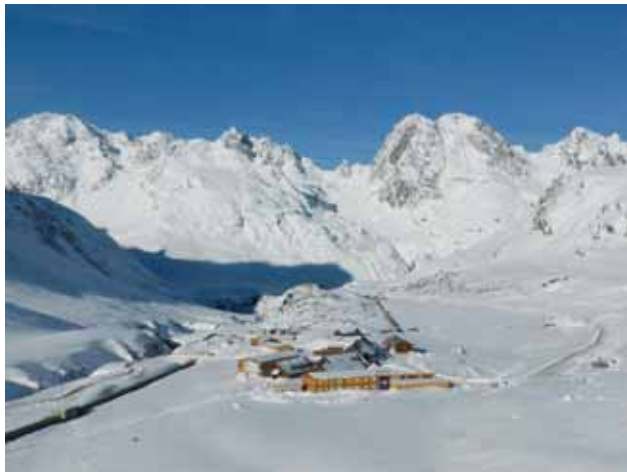
Das „Silvrettadorf“ auf 2.000 m Seehöhe, lawinensichere Quartiere mit Baustellenkantine Bild: ARGE Bau OVWII
