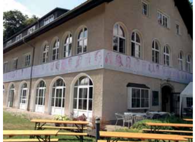
Bestehendes, denkmalgeschütztes Hotelgebäude Bild: PORR AG
