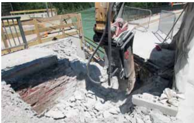
Abtragung der Brücke Bild: PORR AG
