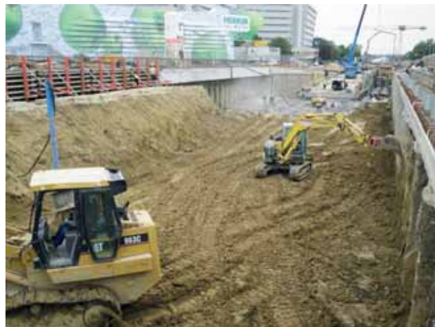
Baugrubenaushub zwischen Bohrpfählen mit nachlaufenden Spritzbeton- und Betonbauarbeiten Bild: PORR AG
