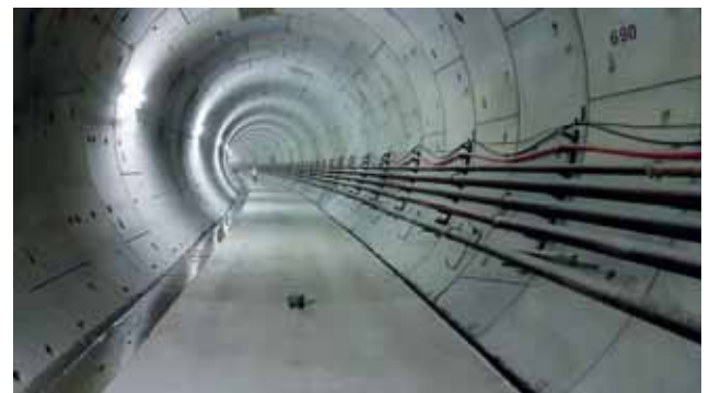
Tunnel mit Aufbeton Bild: PORR AG
