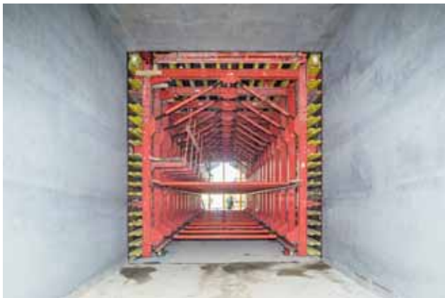
Betonierter Rechteckquerschnitt mit Schalwagen Bild: PERI
