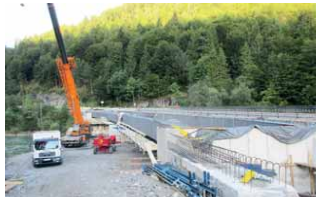
Fertigstellungsarbeiten Bild: PORR AG
