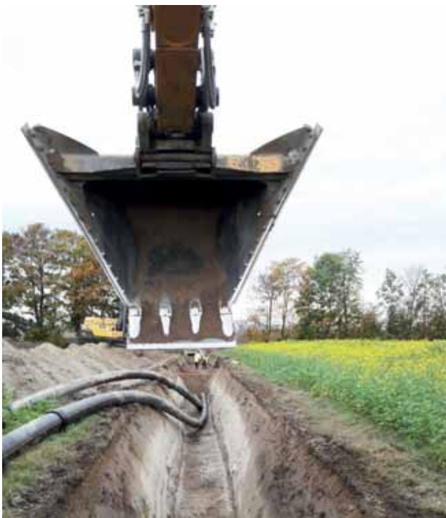
Der Trapezlöffel Bild: PORR AG
