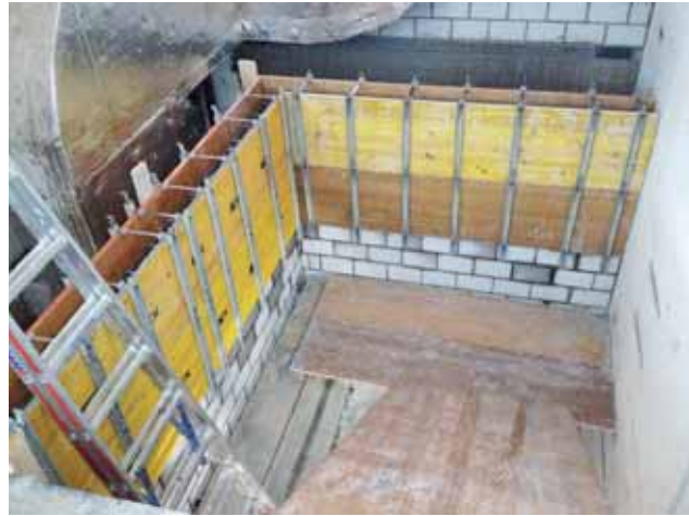
Neuer Liftschacht mit dahinterliegender Steigzone Bild: PORR AG
