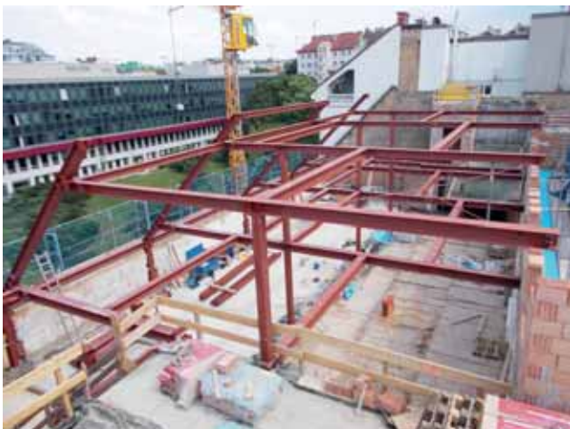
Aufbau der Stahlkonstruktion Bild: PORR AG
