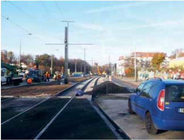
Abschlussarbeiten an der Oberleitung und Verteilung des Mutterbodens für die künftige Grasdecke der Straßenbahnstrecke im Abschnitt zwischen den Haltestellen Nádraží Vršovice (Richtung Stadtmitte) – Otakarova.
