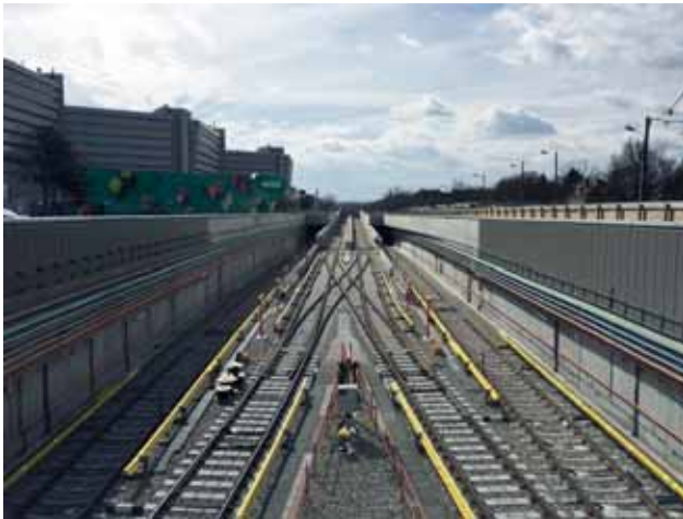
Fertiggestellte Weichenanlage mit Abstellgleisen vor Beginn Probetrieb Bild: PORR AG
