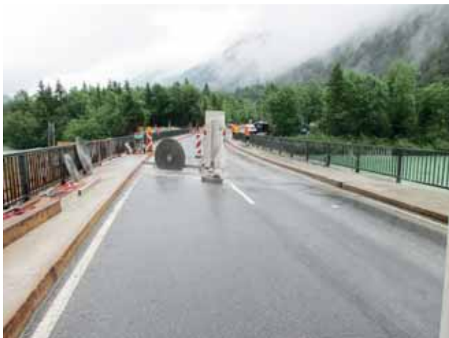
Arbeiten am Brückentragwerk Bild: PORR AG
