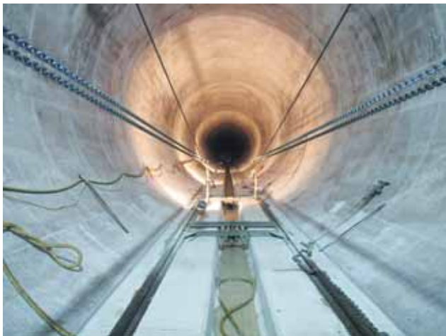
Silvrettastollen, betonierte unbewehrte Innenschale, Durchmesser 6,80 m, Längsneigung 9 %, Rückhängung Gewölbeschalwagen Bild: ARGE Bau OVWII
