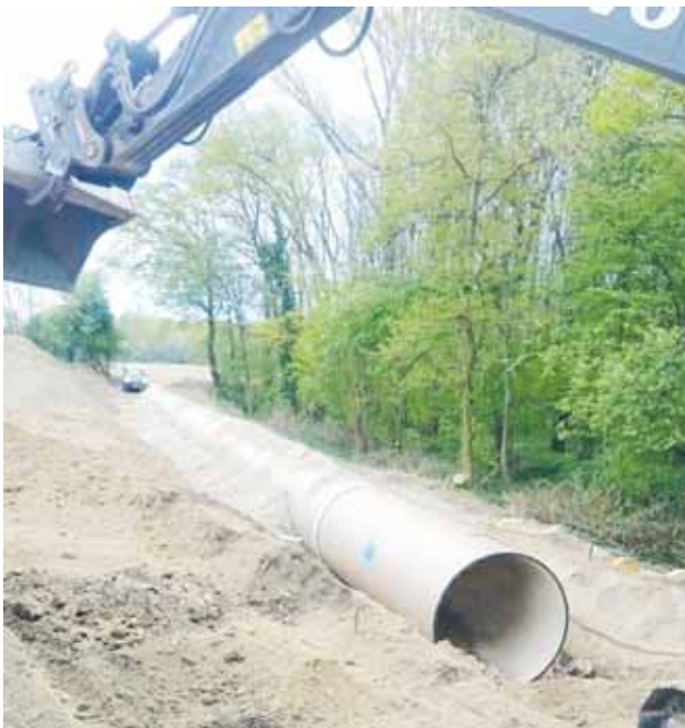
Verlegung des Stauraumkanals im Bereich der Kläranlage Traismauer Bild: PORR AG
