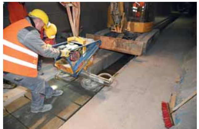
Deckel versetzen Bild: PORR AG
