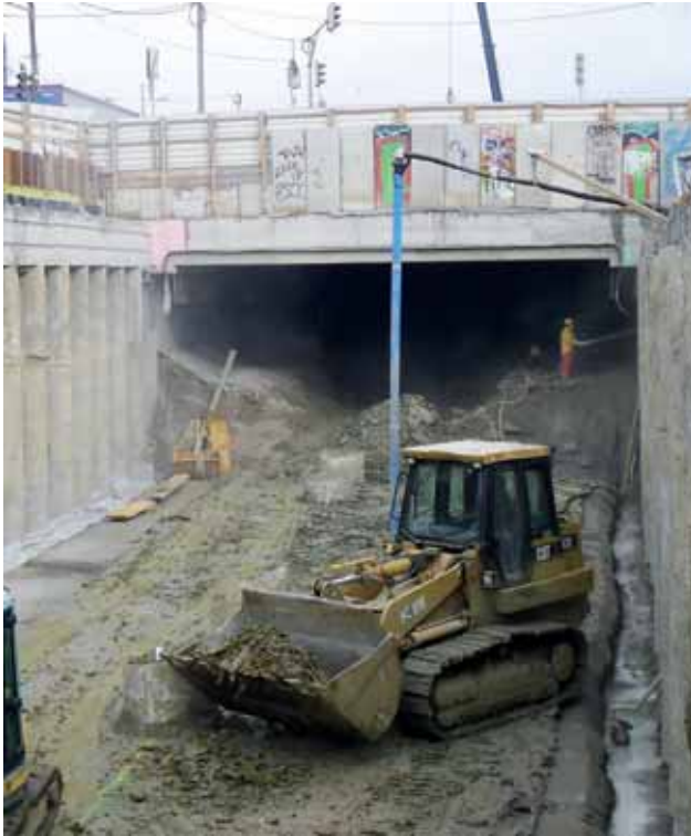
Baugrubenaushub im Übergang offene Bauweise – Deckelbauweise Bild: PORR AG
