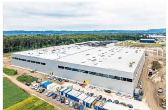
DB Schenker Halle Bild: PORR AG
