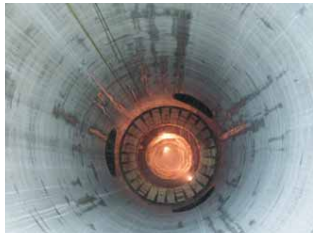
Wasserschloss Krespa, Steigschacht, fertiggestellte Innenschale in Gleitbauweise, Innendurchmesser 17 m, drei abzweigende untere Kammern, eingerüstete Verzugsstrecke Bild: ARGE Bau OVWII
