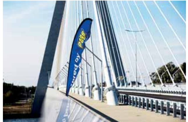
Die Tadeusz-Mazowiecki-Brücke in Rzeszów Bild: PORR AG
