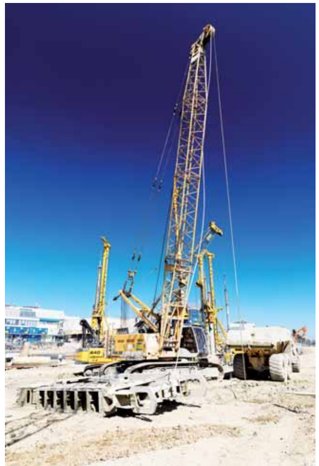
Spezialtiefbau sichert Großinvestition Bild: PORR AG/Harry Schiffer
