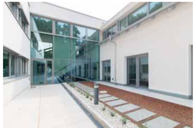
Einer der Innenhöfe Bild: PORR AG
