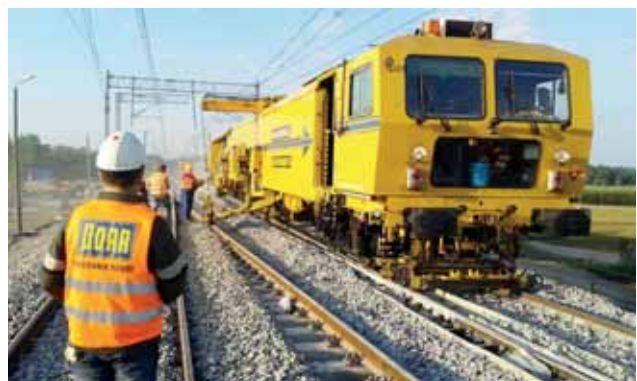
Regulierung und Stopfen der Weichen auf der Eisenbahnhauptmagistrale LK 4 in Biala Rawska Bild: PORR AG
