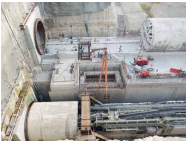
Durchzug in der Switchbox Bild: PORR AG
