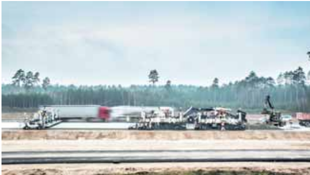
Die PORR verfügt über die notwendige Expertise im Betondeckeneinbau. Bild: PORR AG
