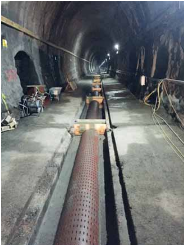
Verrohrung Sohlkanal Bild: PORR AG
