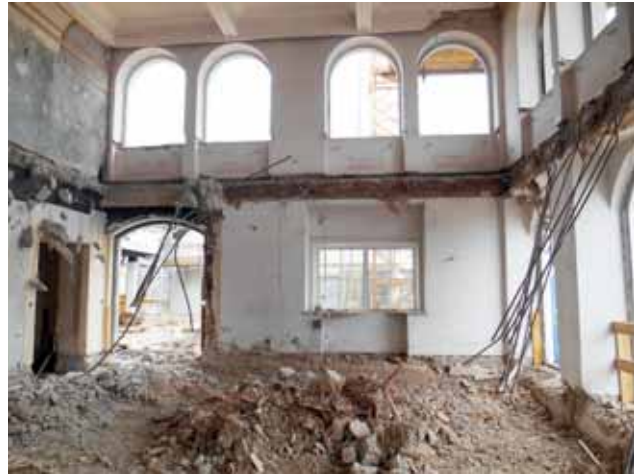
Abbruch der Decken Bild: PORR AG
