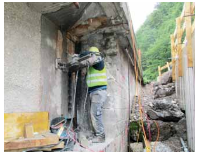
Vorbereitungsarbeiten für Verschieb Bild: PORR AG
