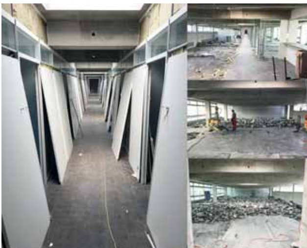
Abbrucharbeiten im OG 3 Bild: PORR AG
