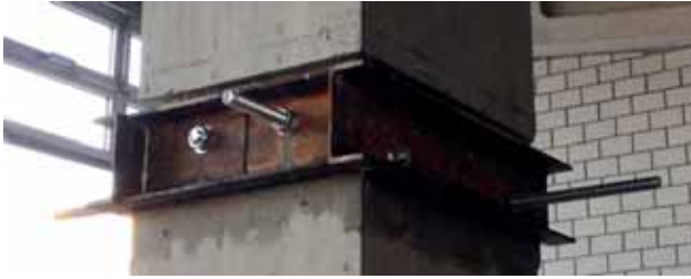
U-Profil mit Gewindestange durch Bestandsstütze Bild: PORR AG
