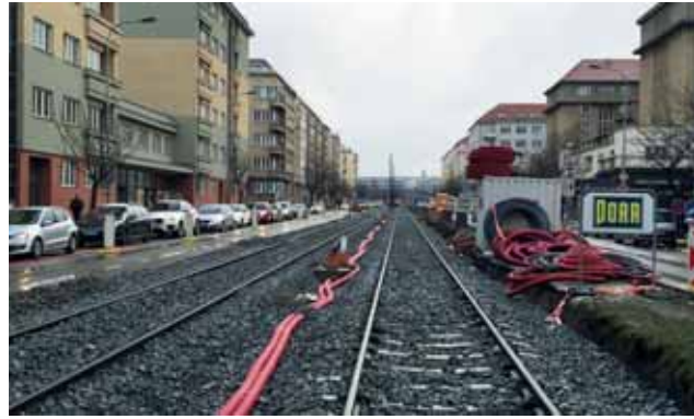
Abschnitt der künftigen Straßenbahnhaltestelle Slavia (Richtung stadtauswärts) – Kubánské náměstí. Fertigstellung der Schienenmontage vor dem Gleisstopfen und Fertigstellung der Verlegung des Schotterbetts, Korngröße. 32/63 zwischen den Schwellen. Bild: PORR AG
