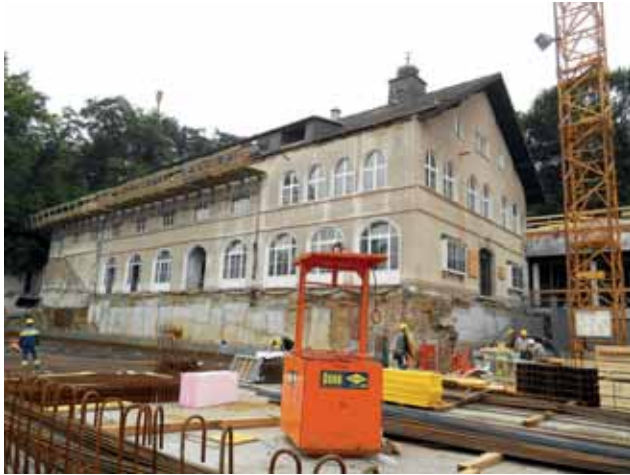
Hotelgebäude nach den Unterfangungsarbeiten und dem Tiefgaragenaushub Bild: PORR AG
