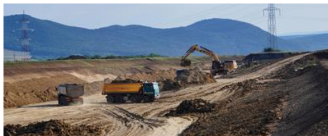
Ein 220 kV Strommast direkt in der Mitte der Autobahn musste umgelegt werden. Bild: PORR AG
