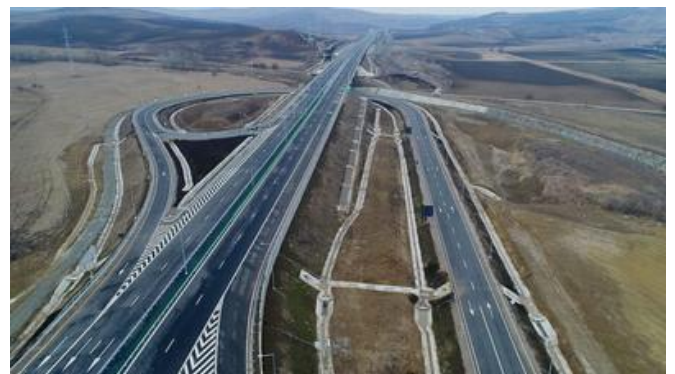
Einblick in die umfangreichen Entwässerungsmaßnahmen auf dem Projekt. Bild: Pro Infrastructura
