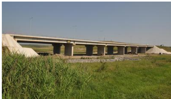
Die 255 m lange Autobahnbrücke im Sektor 5 ist die längste Brücke des Projekts. Bild: PORR AG
