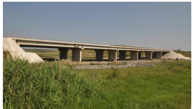
Die 255 m lange Autobahnbrücke im Sektor 5 ist die längste Brücke des Projekts. Bild: PORR AG
