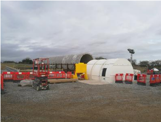
Der Tunnel Mock-up für Trainingszwecke. Bild: PORR AG
