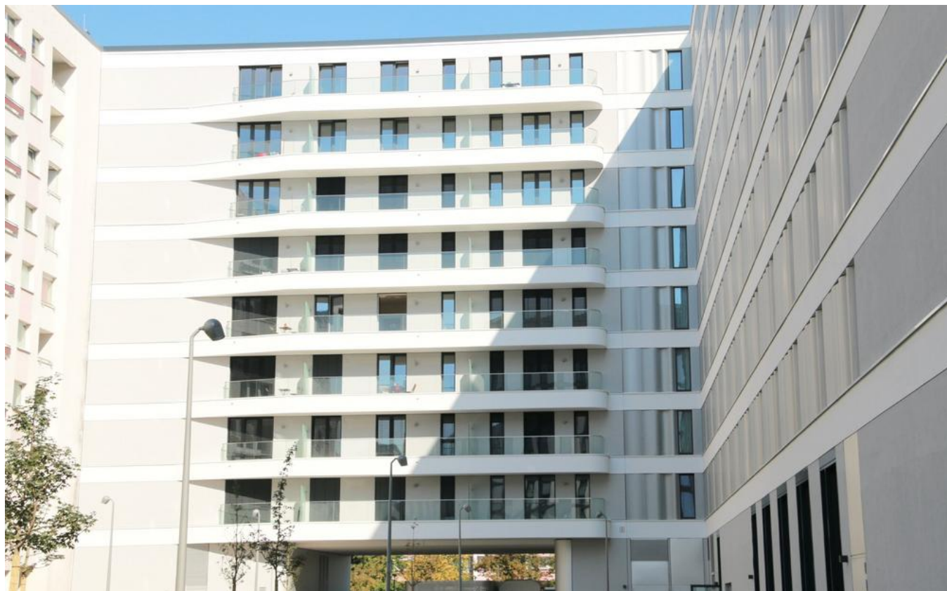
Frontalansicht des Wohngebäudes Bild: PORR AG
