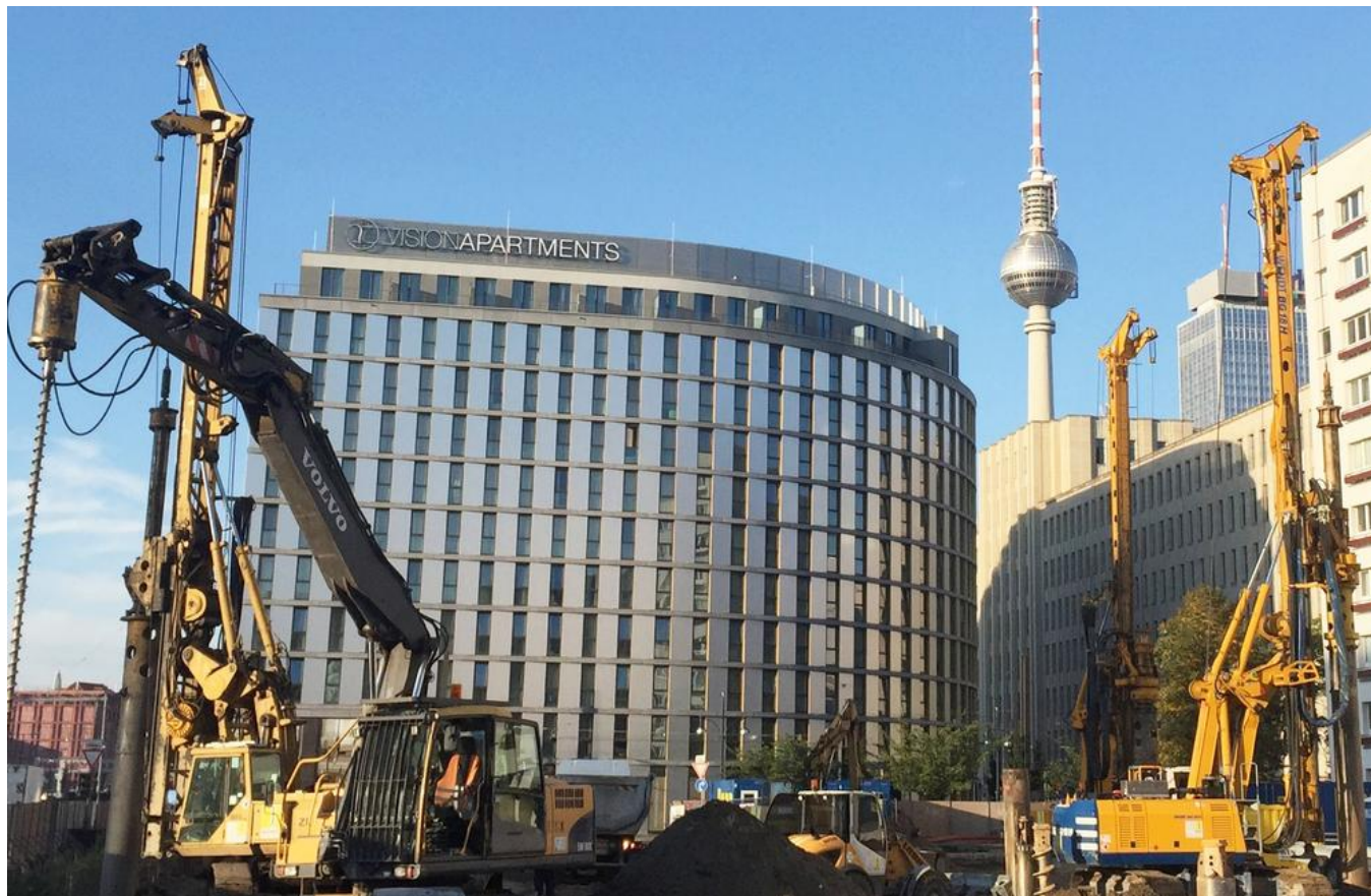
Großbohrgeräte bei der Erstellung von Bohrspfählen. Bild: PORR AG
