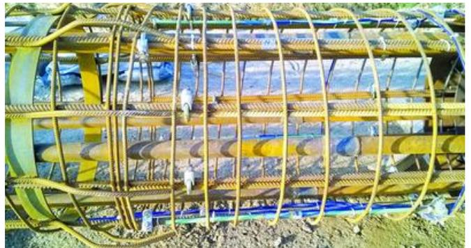
Bewehrungskorb mit montierten Dehnungsmessgebern Bild: isg
