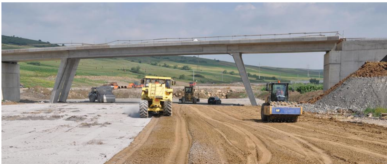
Ein Teil des Schüttmaterials musste zusätzlich mit Zement stabilisiert werden. Bild: PORR AG
