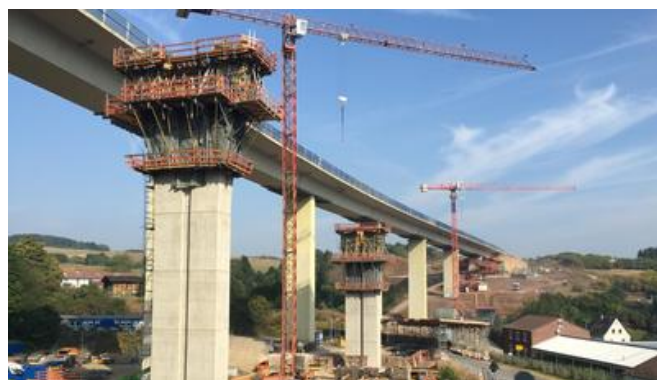
Die neuen Brückenpfeiler, Achse 50 und 60, sind zwischen 15,5 m und 35 m hoch und wurden in Einzelabschnitten von jeweils 5 m betoniert. Bild: PORR AG
