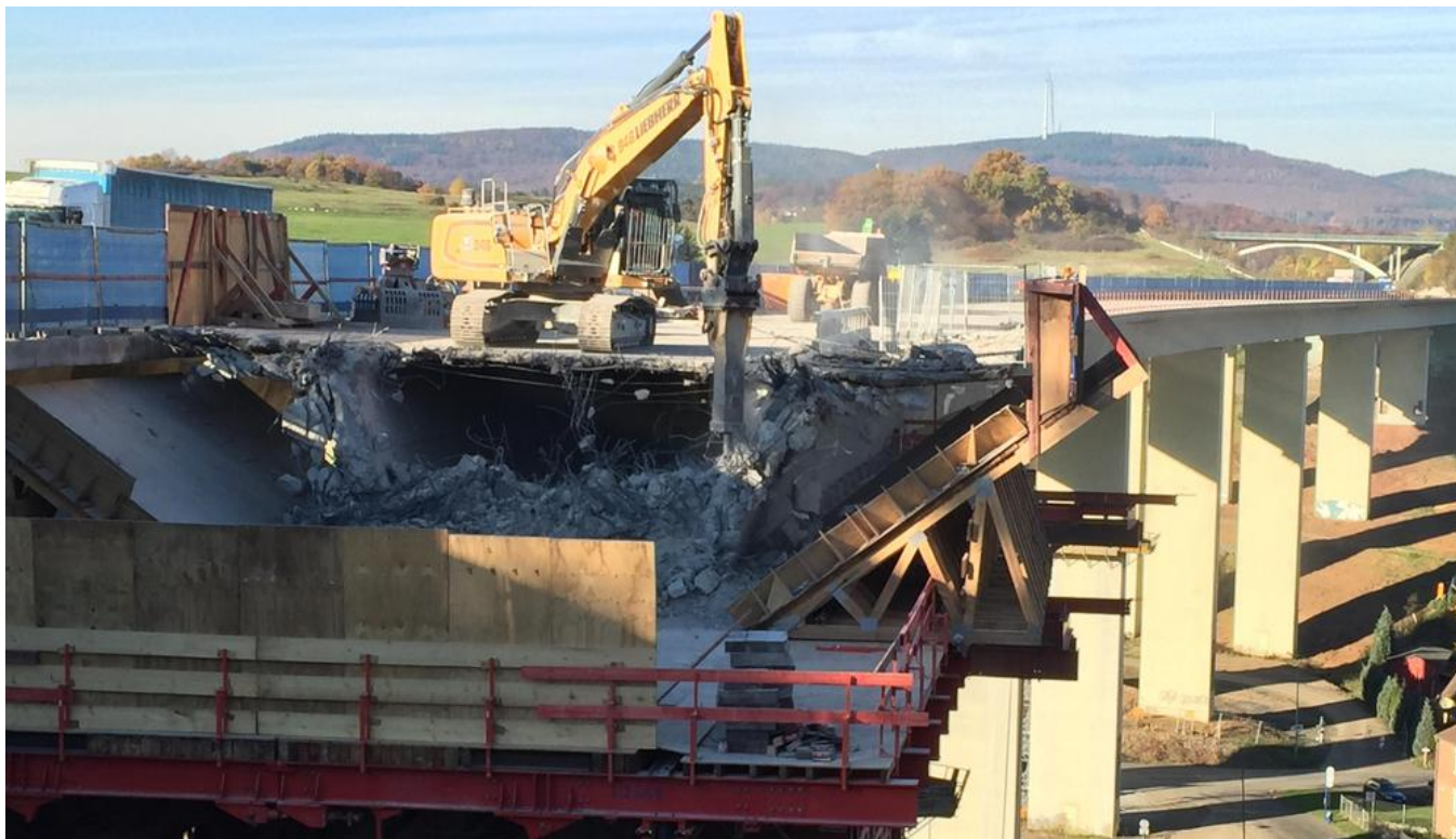
Die Abbrucharbeiten erfolgten mittels Bagger. Bild: PORR AG
