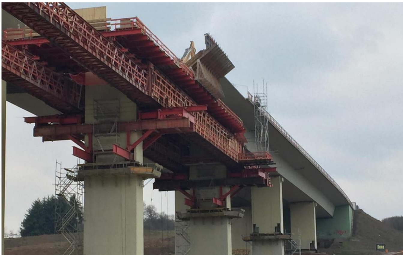
Rückbau des Spannbetonhohlkastens auf dem Abbruchgerüst. Bild: PORR AG
