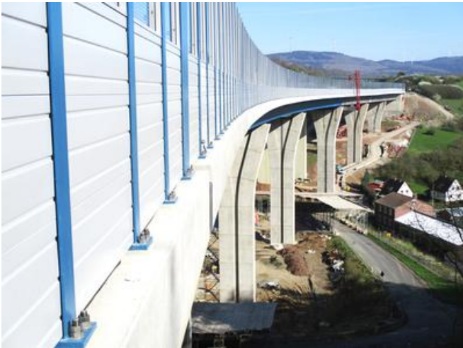
Im Frühjahr wurden die letzten Brückenabdichtungen und Schutzeinrichtungen wie die Lärmschutzwand im Teilbauwerk 1 fertiggestellt. Bild: PORR AG
