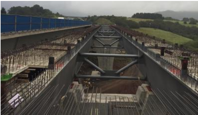
Die verschobene Stahlkonstruktion in Endlage auf den Brückenpfeilern. Bild: PORR AG
