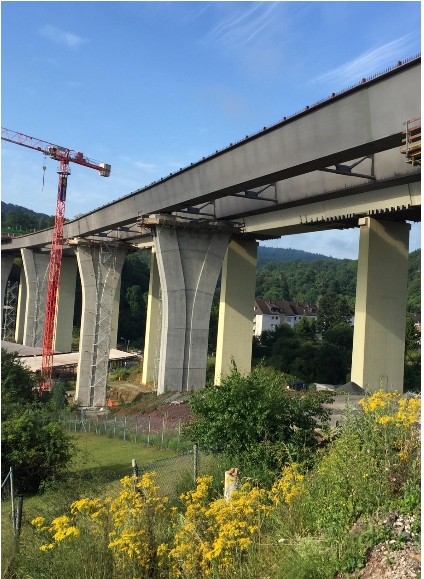
Herstellung der neuen Fahrbahnplatte mit Schalwagen. Bild: PORR AG
