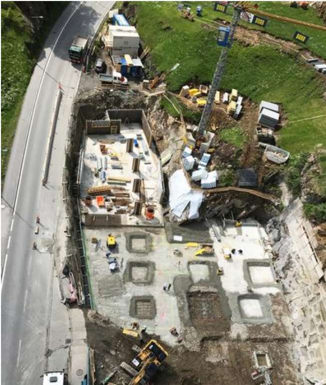
Die Erdbauarbeiten wurden aufgrund unterschiedlicher Bodenbeschaffenheiten zu einer aufwendigen Aufgabe. Bild: PORR AG
