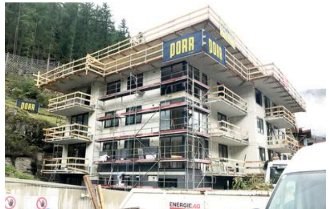
Alle tragenden Wände und Decken des Apartmenthauses wurden in Stahlbeton errichtet. Bild: PORR AG
