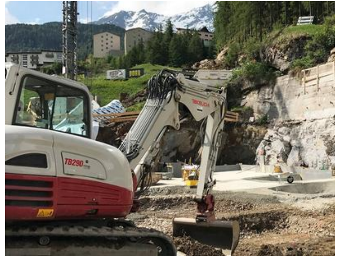
Die Baugrube wurde mit Spritzbeton gesichert. Bild: PORR AG
