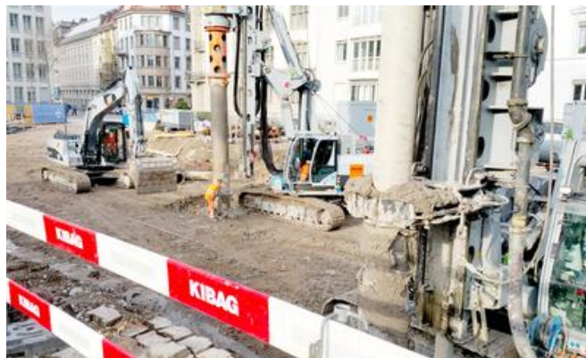
Gründungsarbeiten bis in 17 m Tiefe: Da das Baufeld im Bereich einer nicht tragfähigen Seeablagerung liegt, entschied sich die Bauherrin gegen eine umfassende Sanierung und für einen Ersatzneubau. Bild: PORR AG
