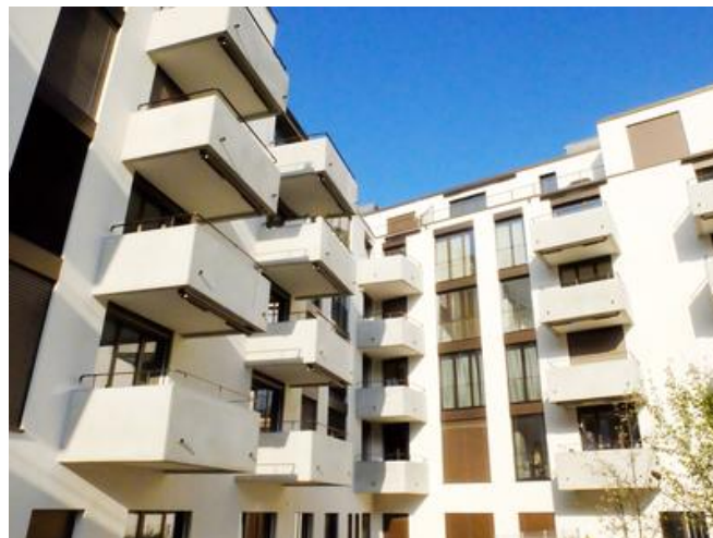
Das Projekt wurde nach dem Schweizer Minergie-Standard errichtet und verfügt damit über eine höhere Energieeffizienz als gesetzlich gefordert. Bild: PORR AG
