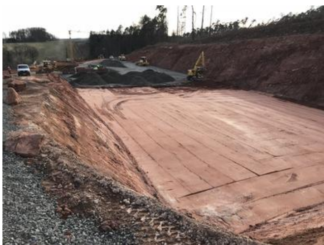
Für den Taktkeller musste ein Aushub von rund 25.000 m 3 gelöst und zur Wiederverfüllung seitlich gelagert werden. Quelle: PORR
