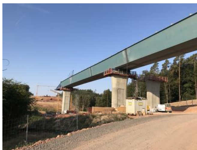
Vor dem erfolgreichen Vers Schub waren sechswöchige Schlosser- und Schweißarbeiten nötig. Quelle: PORR
