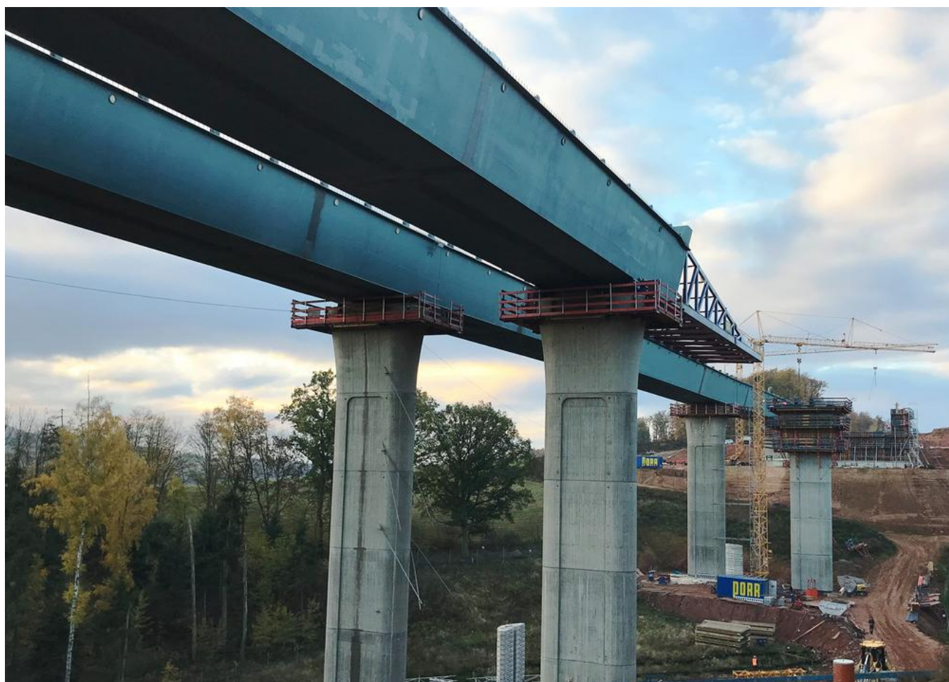
Die Talbrücke Goldbach ist planmäßig im Herbst 2019 fertig. Quelle: PORR
