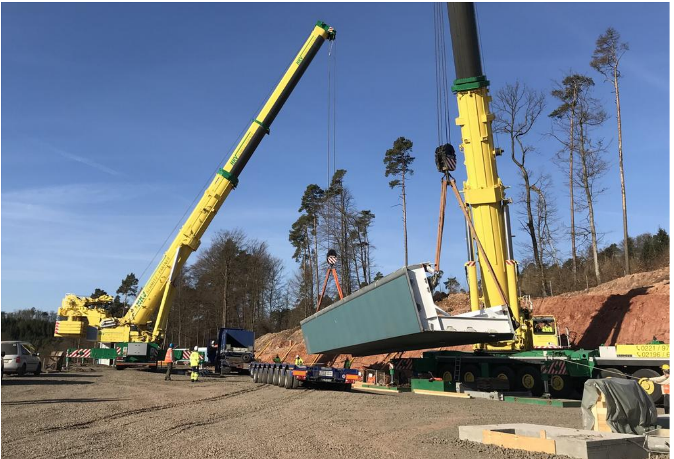
Die 85 t schweren Stahlbauteile für die Goldbachtalbrücke bei der Entladung. Quelle: PORR
