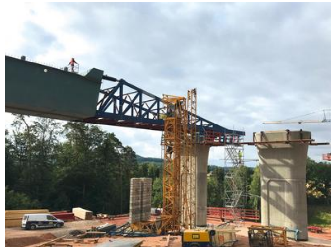
Bauteile wie Verschubwippen, ein Vorbauschnabel für das Schieben der einzelnen Abschnitte (Bild) oder eine Zuganlage mit selbst konzipierten, horizontal arbeitenden Litzenhebern wurden neu entwickelt und können jetzt auch für andere Projekte verwendet werden. Quelle: PORR
