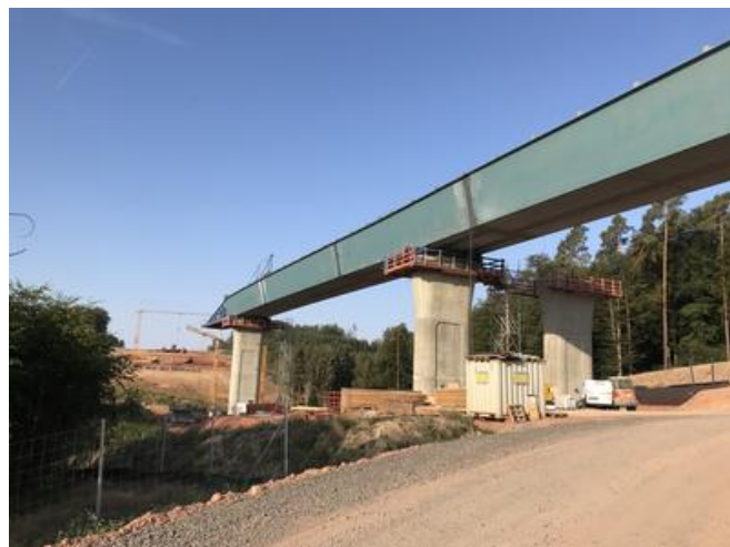
Vor dem erfolgreichen Vershub waren sechswöchige Schlosser- und Schweißarbeiten nötig. Quelle: PORR
