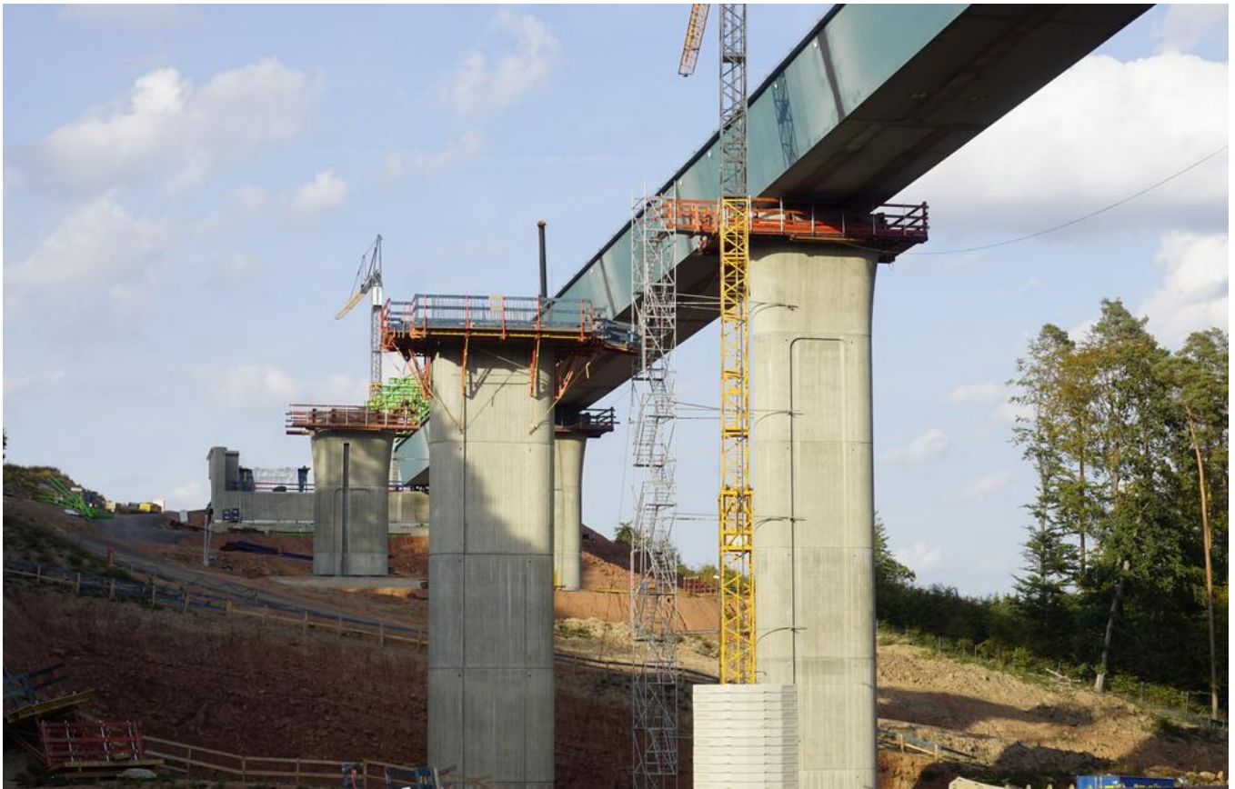
Die Pfeiler haben eine Höhe von knapp 30 m. Bildquelle: PORR
