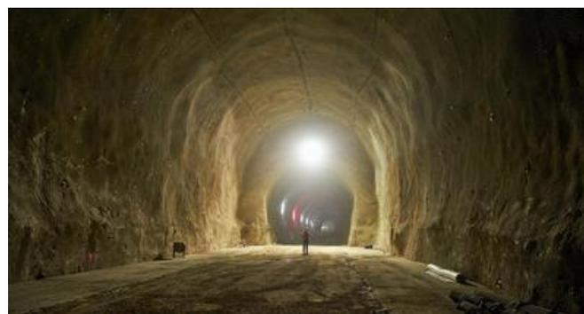
Demontagekaverne Südröhre mit einem Ausbruchsquerschnitt von 170 m<sup>2</sup> mit der Blickrichtung Klagenfurt in den bereits hergestellten Vortrieb des Fahrtunnels. Quelle: Toni Rappersberger
