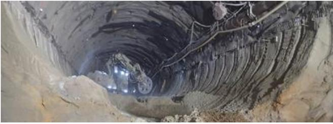
Das bestehende Kalottensohlgewölbe wurde vorausseilend mit einem Tunnelbagger mit angebautes Schneidrad vorgeschritten. Quelle: PORR
