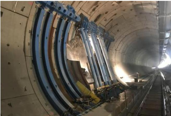
Vor dem Durchschlag der Querschläge wird im Neogenabschnitt die Tübbingröhre mit einer Stahlaussteifung gesichert. Quelle: PORR AG
