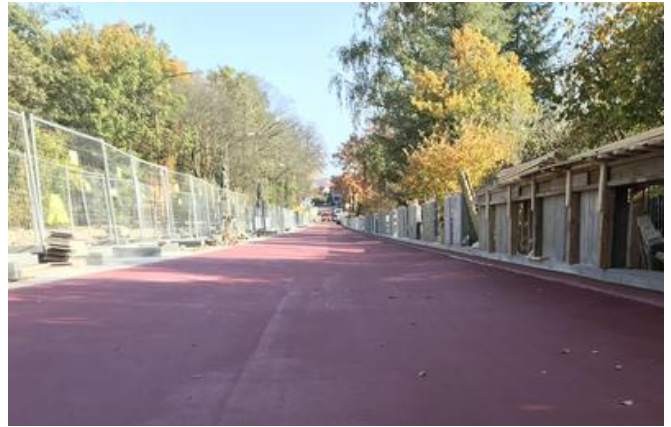
Der Brückenfahrbahnbelag wurde ebenso wie die historischen Betongeländer ausgetauscht. Quelle: PORR
