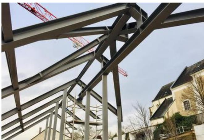
Der neue Dachstuhl erforderte eine Stahlkonstruktion, da sich über dem obersten Gesimse des alten Rathauses ein durchgängiges Lichtband befindet. Quelle: PORR
