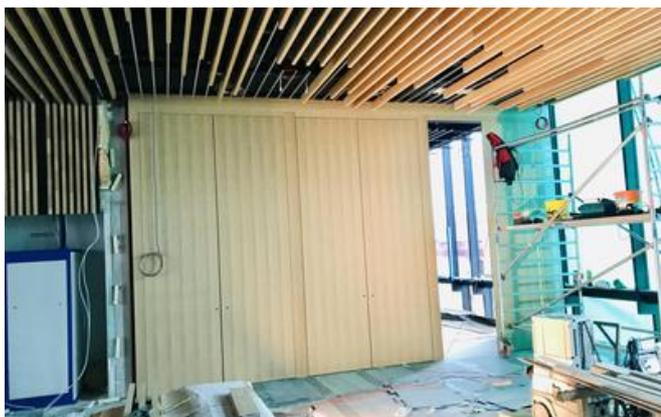
Jeder einzelne Flügel der raumhohen Massivholztüren wiegt rund 400 kg. Quelle: PORR
