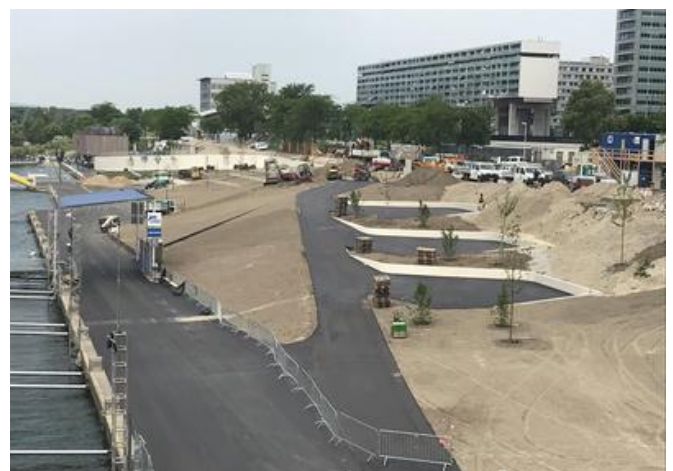
Im Böschungsbereich errichtete die PORR mehrere unregelmäßig gekrümmte Stützmauern. Die größte Stützmauer beginnt am Kai und läuft an der Böschungsoberkante aus (Bildhintergrund). Quelle: PORR
