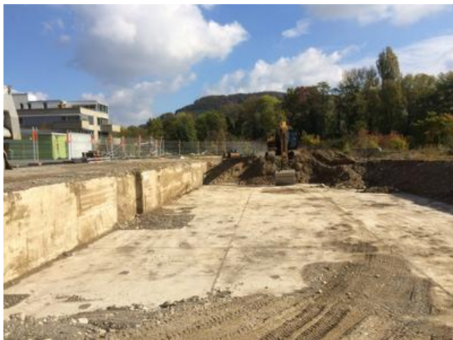
Die trockene Baugrube mit alten Gebäudestrukturen, die belassen wurden. Das neue Untergeschoss wurde in die alte Struktur hineingebaut und zur Weißen Wanne abgedichtet. Quelle: PORR AG
