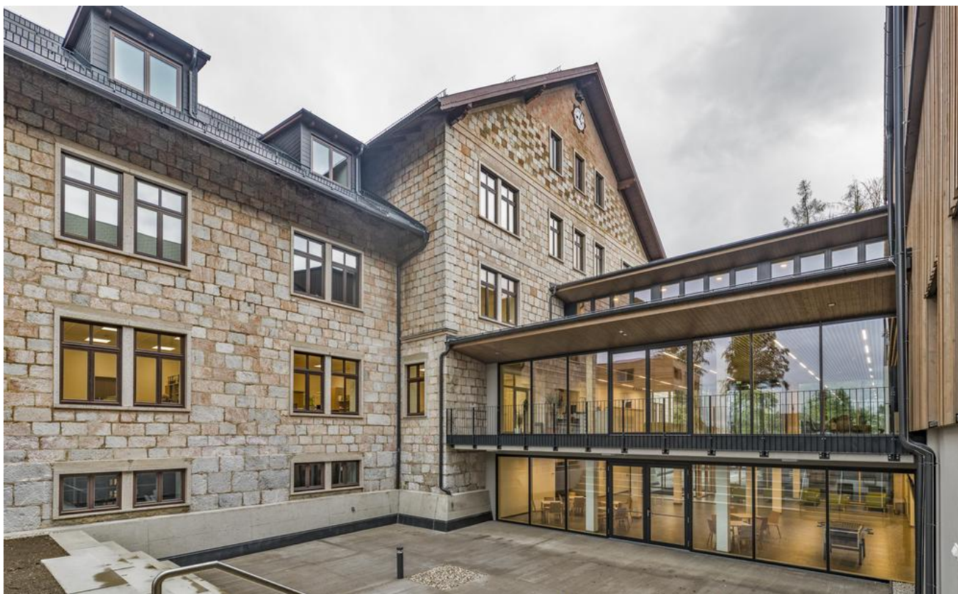
Verglaste Gänge verbinden das denkmalgeschützte Jagdschloss mit den neu errichteten Schul- und Wohngebäuden. Quelle: Gerd Kressl
