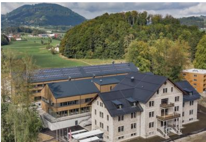
Der neue Schulcampus: Im Vordergrund das Bestandsgebäude, dahinter die neuen Gebäude in Holzbauweise inklusive Photovoltaikanlagen am Dach. Quelle: Gerd Kressl
