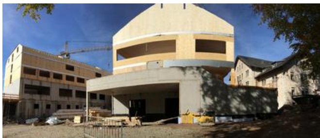
Zwei Wochen später: Beginn der Vorarbeiten für den Dachstuhl. Quelle: Gerd Kressl
