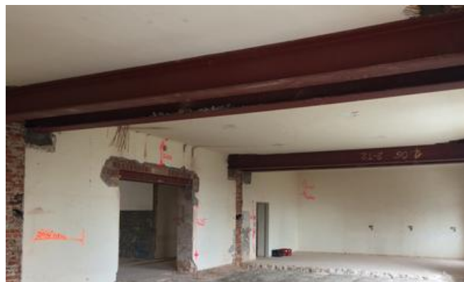
Im großen Festsaal mussten tragende Innenwände entfernt und die Decke mit Stahlträgern gesichert werden. Quelle: PORR
