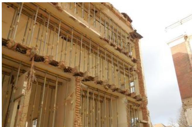
Die Decken mussten im Zuge der Abbrucharbeiten mehrfach lastmäßig umgelagert und durch Unterstellungen abgesichert werden. Quelle: PORR
