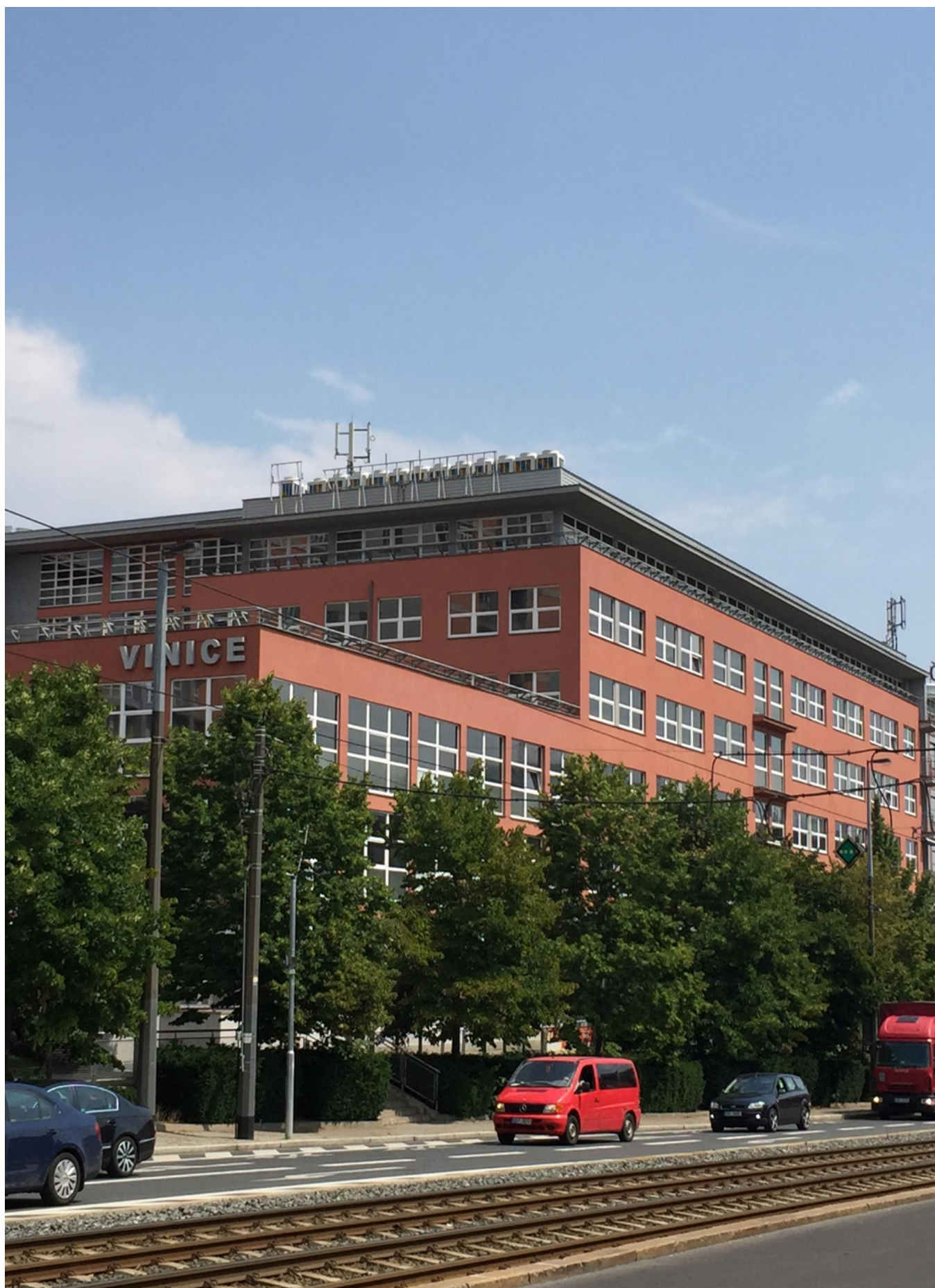
Aus einem alten Bürogebäude aus den 90er-Jahren macht die PORR das neue Zuhause für ein führendes Medienunternehmen der Tschechischen Republik. Quelle: PORR
