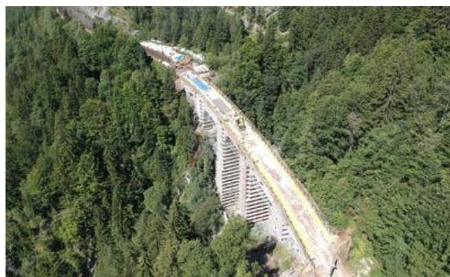
Die gesamte Tragwerkssanierung musste innerhalb einer zweiwöchigen Streckensperre im August durchgeführt werden. Quelle: PORR
