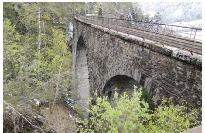
Das Schmiedobelviadukt vor Baubeginn Quelle: PORR
