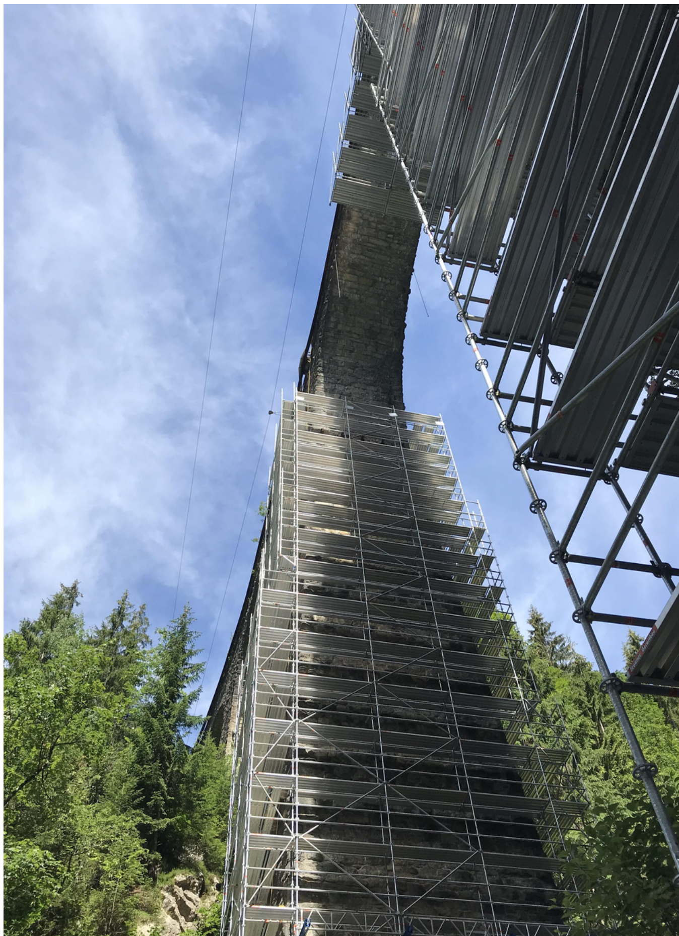
Der Gerüstbau am Pfeiler mittels Seilkrane. Quelle: PORR
