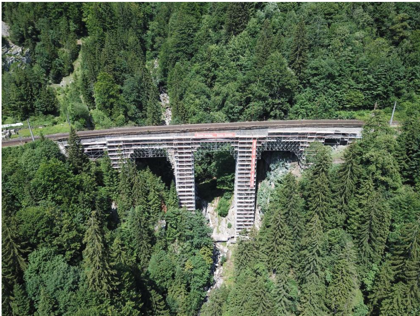
Das Schmiedtobelviadukt wurde mit insgesamt 320 t Gerüstmaterial eingerüstet. Quelle: PORR
