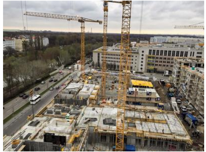
Zu den Spitzenzeiten kamen auf der Baustelle bis zu vier hoch dimensionierte Kräne zum Einsatz. Quelle: PORR
