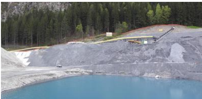
In einer so genannten Seitenentnahme werden Zuschlagsstoffe gewonnen und vor Ort aufbereitet. Quelle: ARGE GKI Maria Stein
