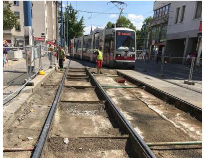
Die vorgefertigten Betondecken und das Kiesbett wurden fachgerecht demontiert. Bildquelle: PORR AG
