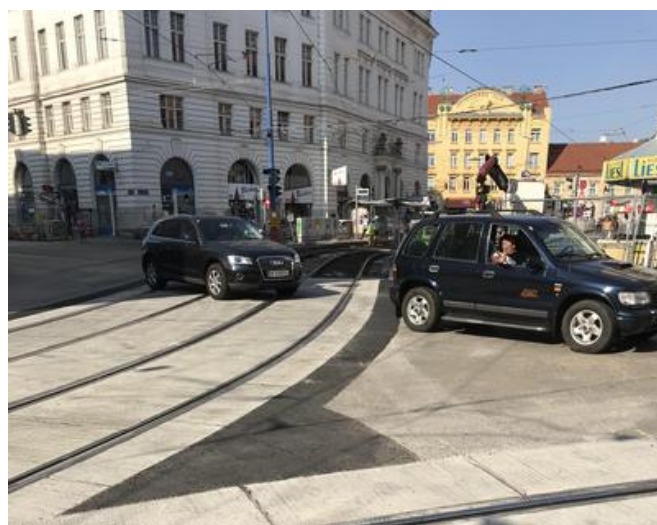
Die Straße war schon bald nach dem Einbau des Fahrbahnbetons nutzbar. Quelle: PORR AG
