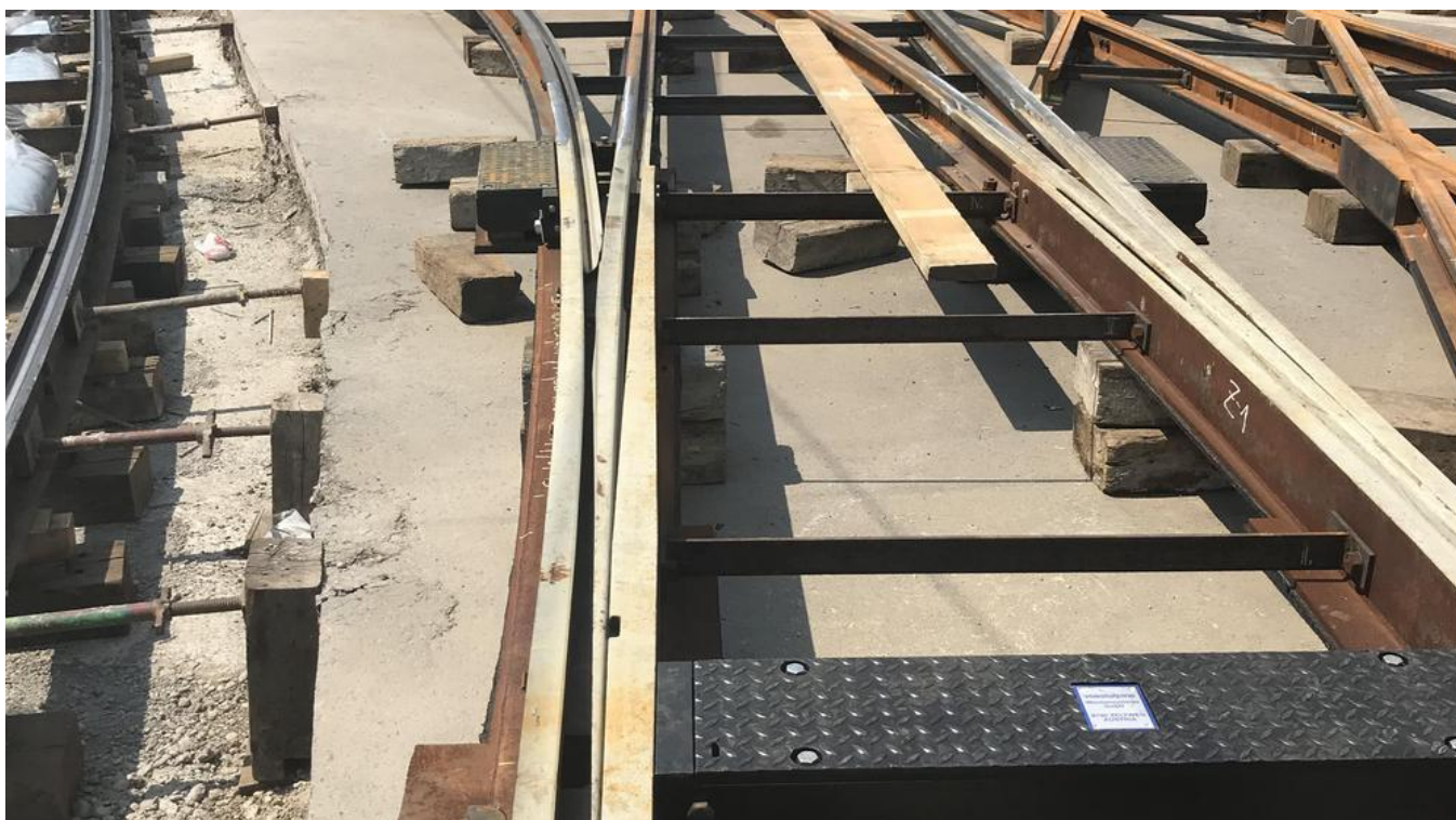
Die Rillenschienenweichen für den Kreuzungsbereich wurden vormontiert. Quelle: PORR AG
