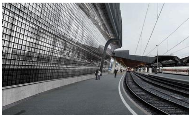
Die gekrümmte Glasbausteinfassade der „Gleisarena“ ist eine spektakuläre Eigenentwicklung der PORR. Quelle: PORR
