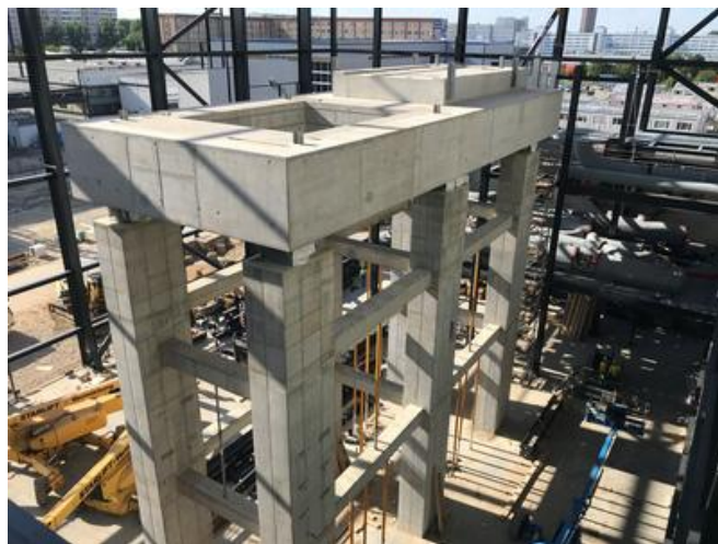
Der Turbinentisch nach erfolgreicher Fertigstellung. Quelle: PORR/Fabian Hemauer
