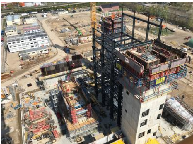
Um den Wochentakt zu erreichen, wurde der Treppenturm am Wochenende beheizt und in Frostschutzmatten gepackt. Quelle: PORR/Fabian Hemauer
