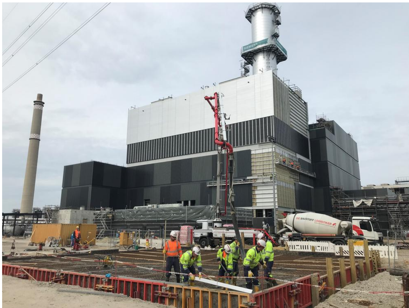
Betonage Bodenplatte Freilager für das Heizkraftwerk Marzahn. Quelle: PORR/Fabian Hemauer
