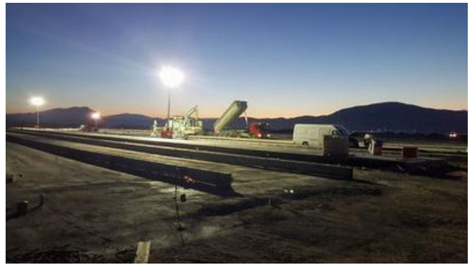
Feste Stahlträger wurden zur Schalung der Betonschicht eingesetzt. Quelle: PORR Construct
