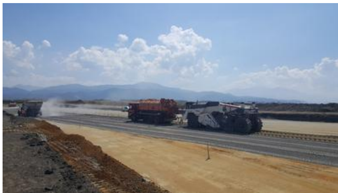
Auf die untere Schotterschicht von Rollbahn und Vorfeld wurde eine weitere 25 cm dicke stabilisierte Schotterschicht aufgetragen. Quelle: PORR Construct
