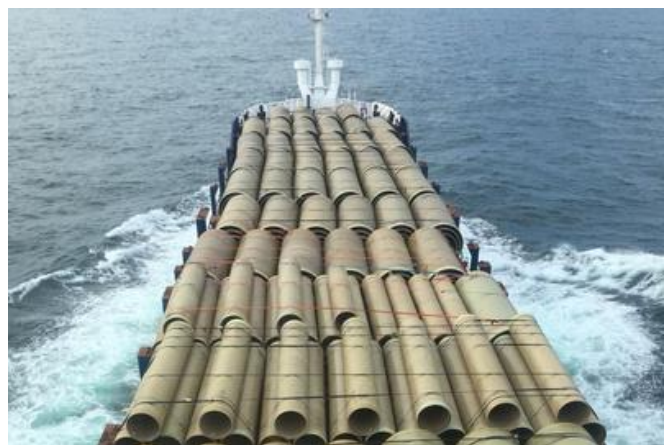
Die Rohre für die Regenwasserkanalisation wurden mit zwei Schiffen aus der Türkei angeliefert. Quelle: PORR Construct
