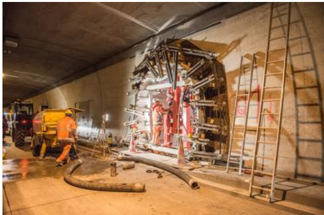
Insgesamt wurden fünf befahrbare und 15 begehbbare Querschläge errichtet. Quelle: Thomas Exel
