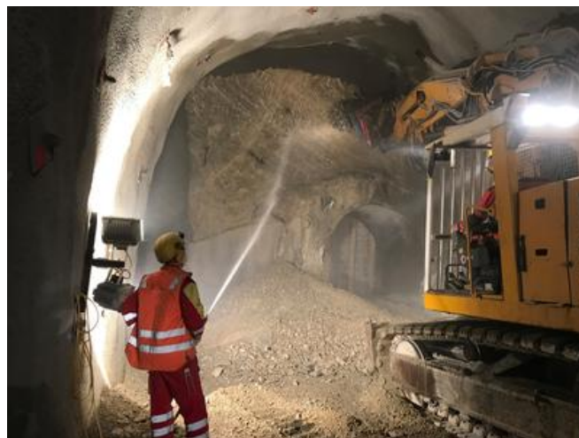
Die letzten Meter vor Erreichen der Weströhre wurde nur noch mechanisch mit einem Bagger vorgetrieben. Quelle: Thomas Exel
