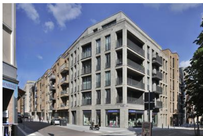
Dem Schlossquartier Kiel mussten drei Bestandsgebäude in desolatem Zustand weichen. Quelle: PORR/Arne Biederbeck
