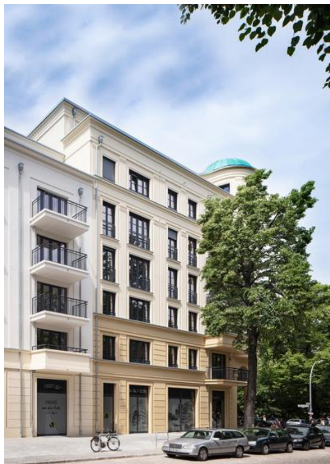
Die Kupferdachkuppel macht das Wohnprojekt zu einem besonderen Blickfang. Quelle: PORR / Markus Löffelhardt
