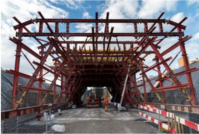
Schalwagen und Nachlaufwagen während der Montage für den Einsatz der nächsten 32 Deckenetappen. Quelle: PORR
