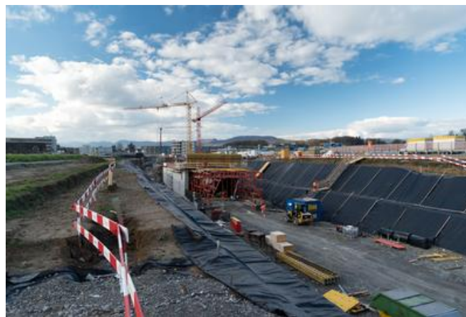
Start der 1. Betonieretappe der Tunneldecke und des Tunnelportals mit Schalwagen und Nachbehandlungswagen. Quelle: PORR
