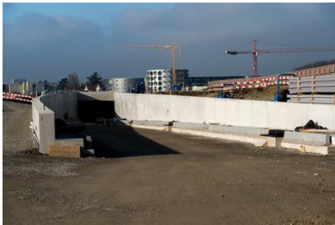
Die fertig erstellte Rampe Horner im Bereich mit Streifenfundamenten und erstelltem Bankett. Quelle: PORR
