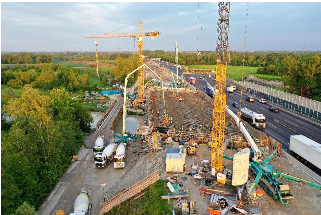
Die Anlieferung des Betons für die Betonage des Überbaus gestaltete sich aufgrund des hohen Verkehrsaufkommens als echte Herausforderung. Quelle: PORR
