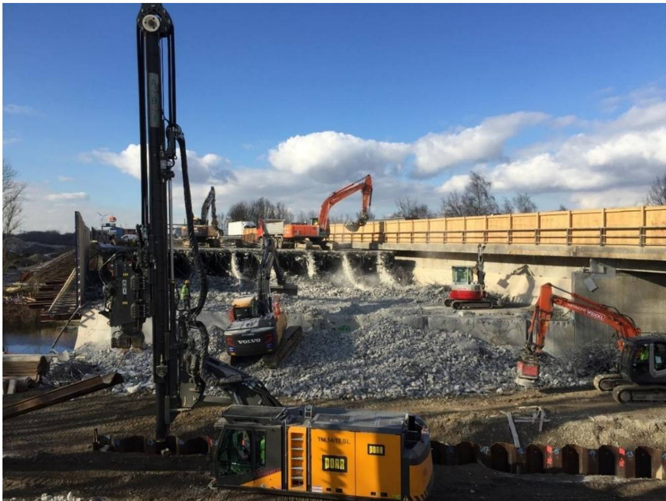
Im Hintergrund wird das bestehende Tragwerk abgebrochen, im Vordergrund werden die Spundungsarbeiten für den Neubau durchgeführt. Quelle: PORR
