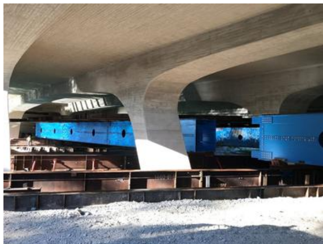
Blick unter die neue Brücke beim Umsetzen der Rüstung. Quelle: PORR
