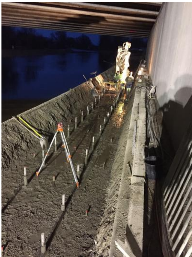
Die Kleinbohrpfähle für die Verschubbahnen wurden von der Porr Grundbau hergestellt. Quelle: PORR
