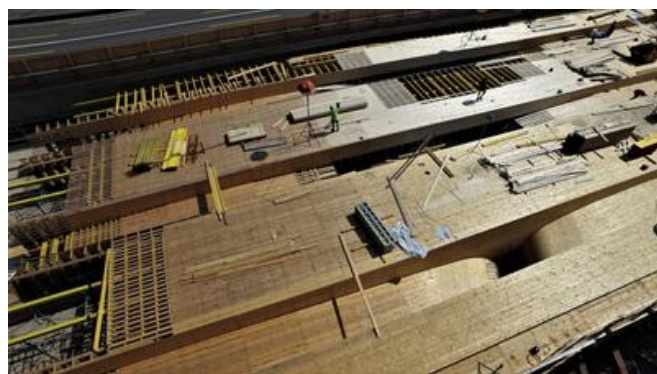
Die Tragwerksschalung wurde mit parabelförmigen Längsträgern und konischen Pfeilern hergestellt. Quelle: PORR
