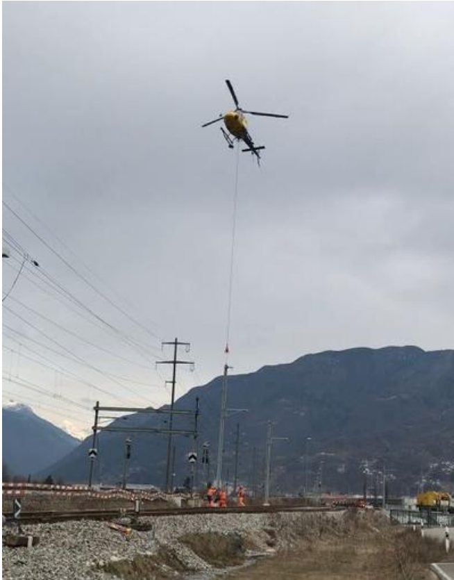
Vom Hubschrauber aus wurden die Fahrleistungsmasten auf offener Strecke platziert. Quelle: CPC/Petzold
