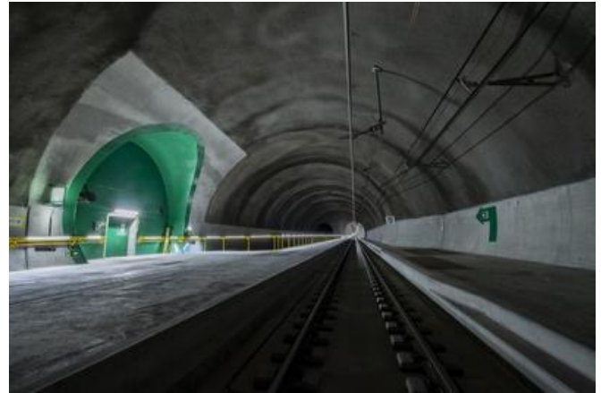
Mit einer Maximalgeschwindigkeit von 250 km/h werden ab Dezember 2020 Personenzüge den Ceneri-Basistunnel durchqueren. Quelle: Alptransit Gotthard AG
