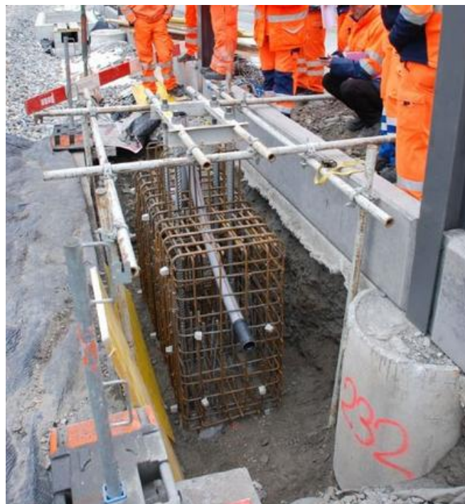
Die Fundamentarbeiten für die Masten auf offener Strecke wurden zu einer echten Herausforderung, weil die Plangrundlagen nicht den örtlichen Gegebenheiten entsprachen. Quelle: CPC/Chladek
