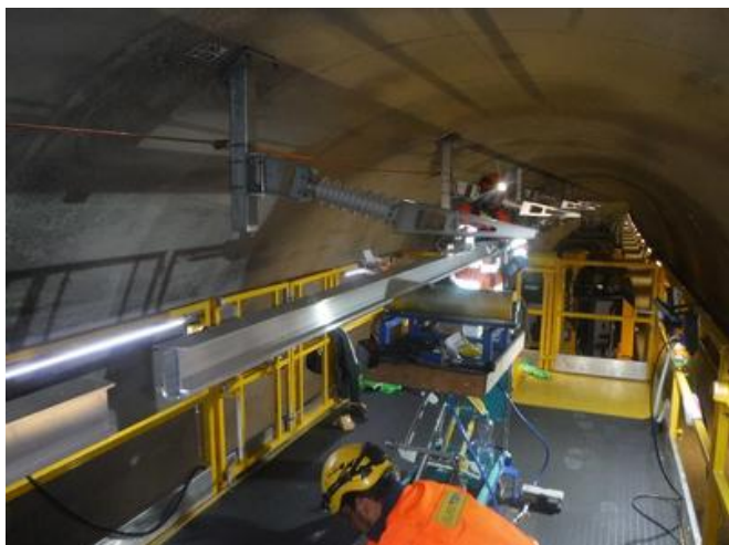
Für die Montage der Deckenstromelemente wurde ein eigenes Verfahren entwickelt. Quelle: CPC/Petzold
