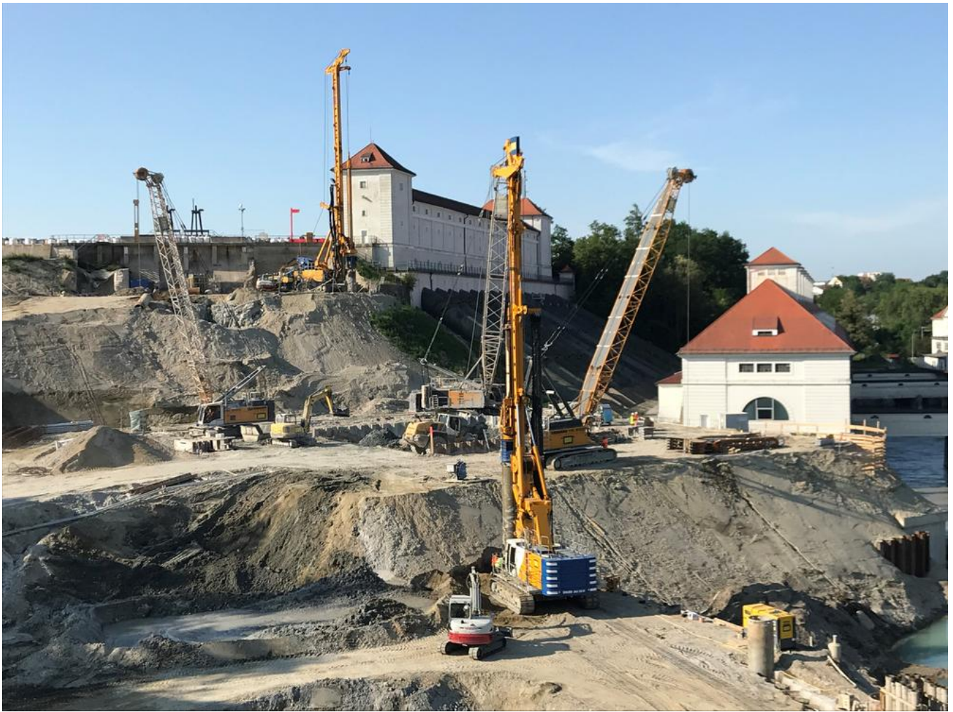
Die Herstellung der Hauptbaugrube umfasst beinahe sämtliche Gewerke des Spezialtiefbaus. Quelle: Markus Trinkl
