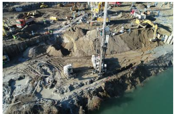
Die von der PORR geplante alternative Ausführung der Baugrube wurde in einem Großversuch in Himberg vorab auf ihre Tauglichkeit getestet. Quelle: Markus Trinkl
