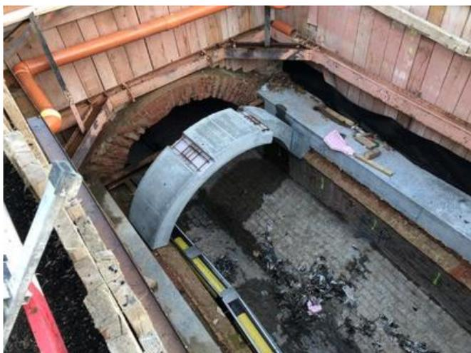
Versetzen der Betonfertigteile zum Verschließen des Ziegelgewölbes des Krottenbachkanals. Quelle: PORR
