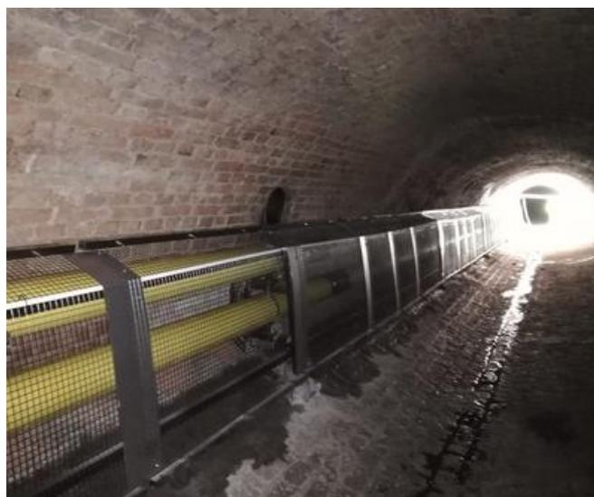
Die fertigverlegte und mittels Edelstahl-Gitterkonstruktion verkleidete Stahlleitung im Krottenbachkanal. Quelle: PORR
