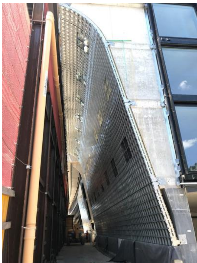
Die seitliche Ansicht zeigt die hohe geometrische Komplexität der Glasbausteinfassade. Quelle: PORR
