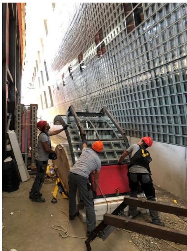
Das Einheben der Elemente wurde aufgrund der beengten Platzverhältnisse zu einer echten Herausforderung. Quelle: PORR
