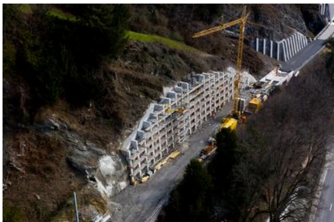
In Abschnitt 3 hat das Team umfangreiche Stützbauwerke errichtet. Quelle: PORR
