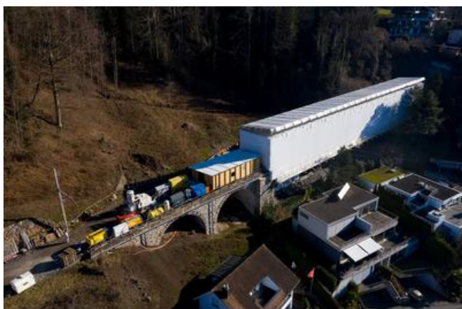
Die Stahlbrücken mussten für die Korrosionsschutzarbeiten eingehaust werden. Quelle: PORR
