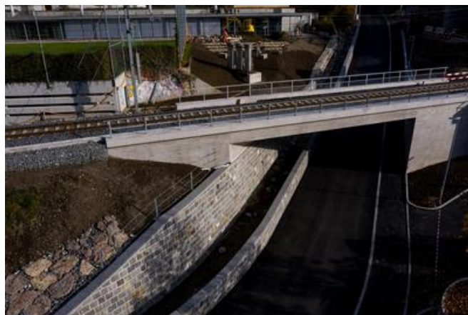
Die fertiggestellte Brücke über den Mänibach. Quelle: PORR
