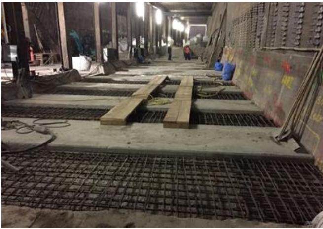
Die Tunnelsanierung erfolgte im Pilgerschrittverfahren in 1,5 m langen Abschnitten. Quelle: PORR/Abraham
