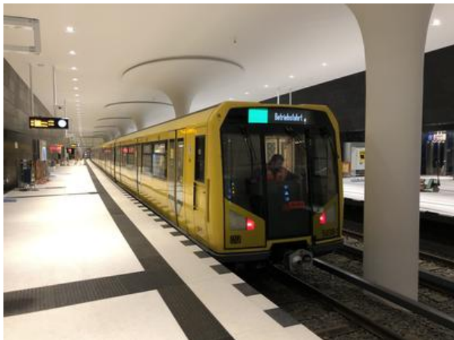
Der U-Bahnhof zeichnet sich durch markante Pilzkopfstützen und mit Terrazzoplatten verkleidete Wände aus. Quelle: Eick/PORR
