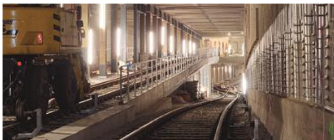
Ein Blick in den sanierten Tunnel zeigt den Gleisbau. Quelle: PRGU5
