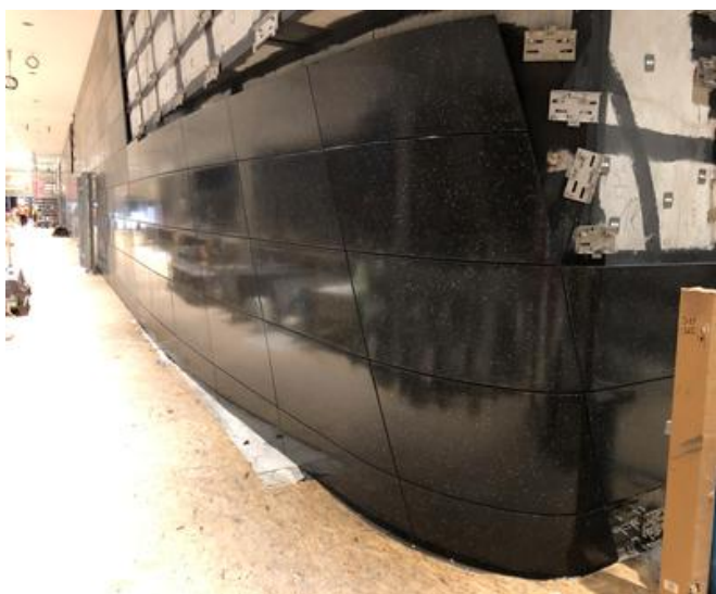
Wie in einem riesigen Puzzle hat jede Fassadenplatte ihren fixen Platz. Quelle: PORR/Ilmmert
