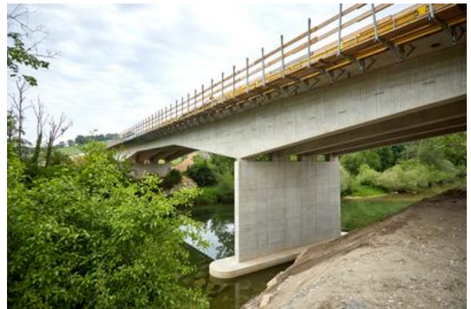
Entlang der Strecke realisiert die ARGE 14 von 17 neuen Brückenobjekten, darunter mehrere Kleinbrücken sowie die Erlaufbrücken Nord und Süd. Quelle: PORR
