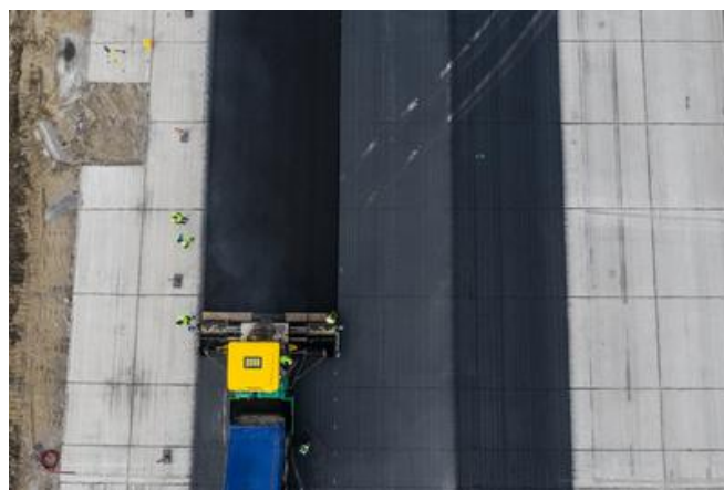
Asphaltierungsarbeiten auf der 45 m breiten Piste. Quelle: PORR
