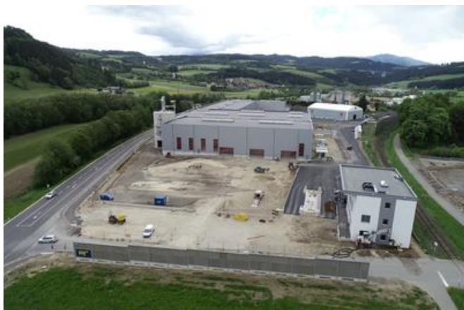
Der Einbau von 10.000 t Asphaltmischgut im Zuge der Errichtung der Außenanlage wurde zur logistischen Herausforderung. Quelle: PORR
