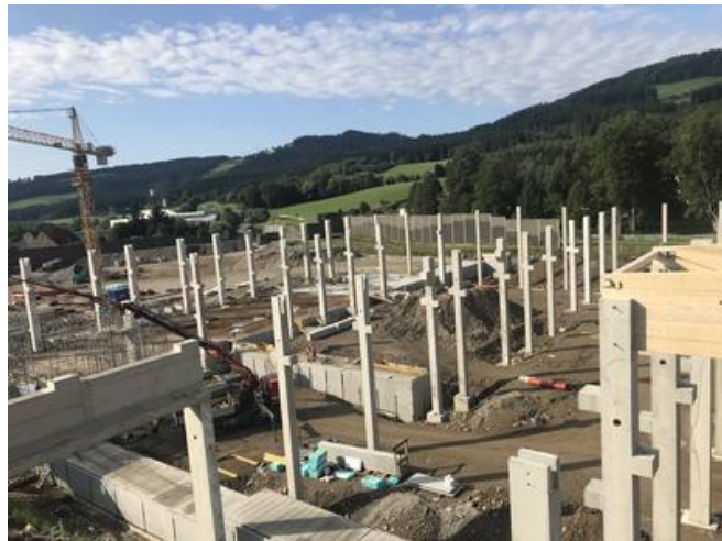
Die Vermessungsarbeiten für die 144 Köcher und Stützen führte die PORR selbst durch. Quelle: PORR
