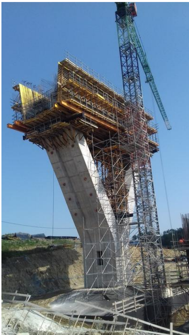
Die Y-förmigen Pfeiler der längsten Brückenfelder wurden für die Errichtung in die drei Bereiche „Pfeilerschacht“, „Kopf“ und „Arme“ unterteilt. Quelle: PORR
