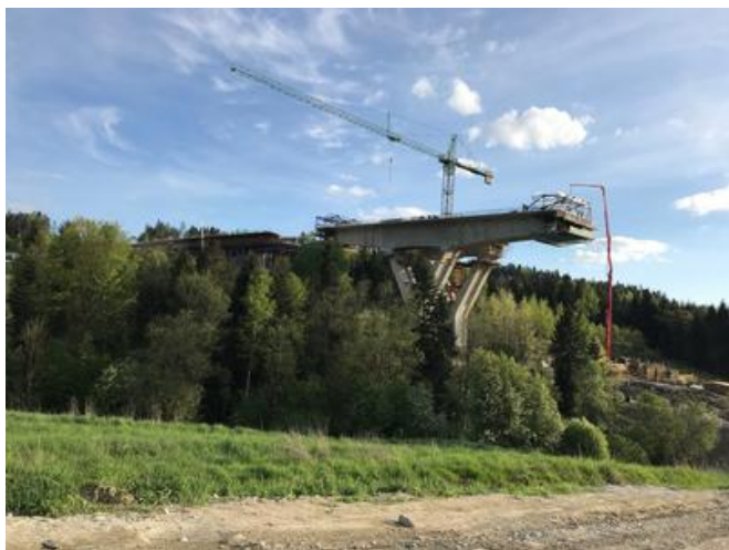
An der höchsten Stelle ist die Brücke rund 50 m hoch. Quelle: PORR
