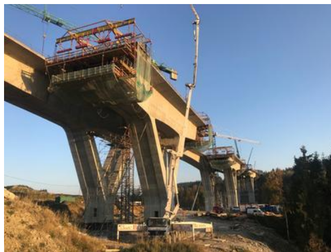
Mit Hilfe von Schiebevorrichtungen wurden die einzelnen Segmente der Brücke betoniert. Quelle: PORR
