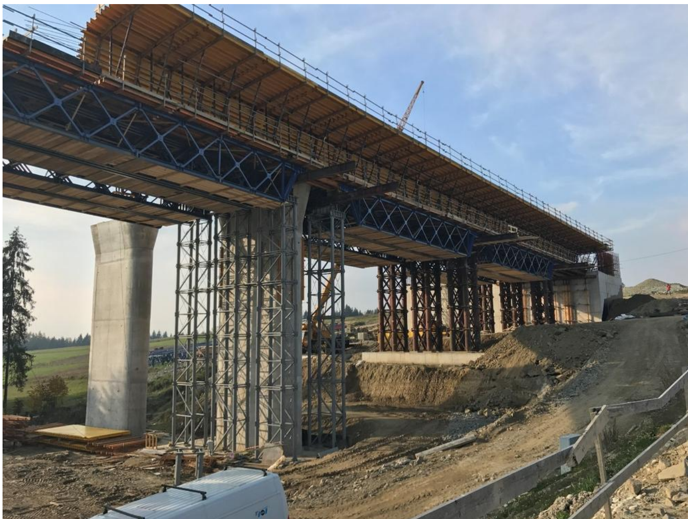
Schalungsarbeiten für die Tragstruktur der Brücke. Quelle: PORR
