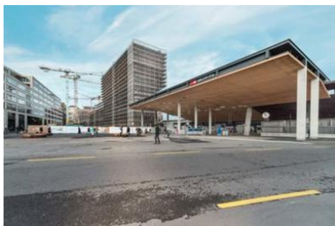
Der neue Aufgang zur Europaallee. Quelle: PORR
