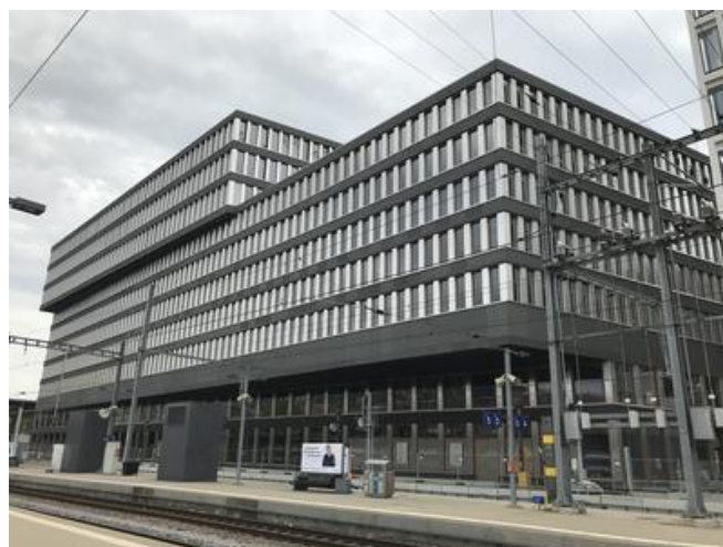
Über dem ersten Obergeschoss wurde eine große Auskragung errichtet, in die Lasten aus acht darüber liegenden Geschossen eingeleitet werden. Quelle: PORR
