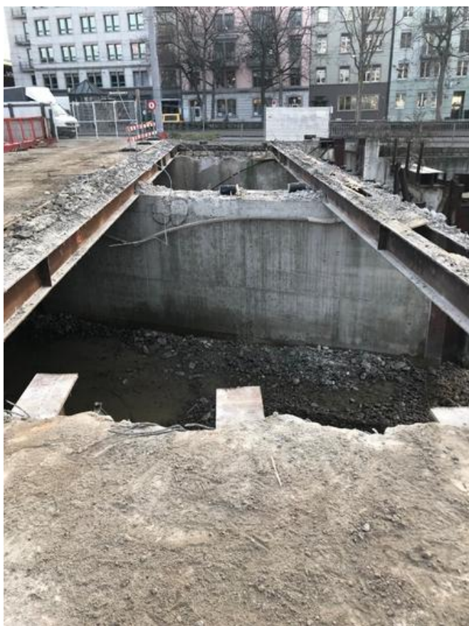
Beim Rückbau der alten Postbrücke wurden insgesamt rund 380 t Stahl ausgebaut. Quelle: PORR
