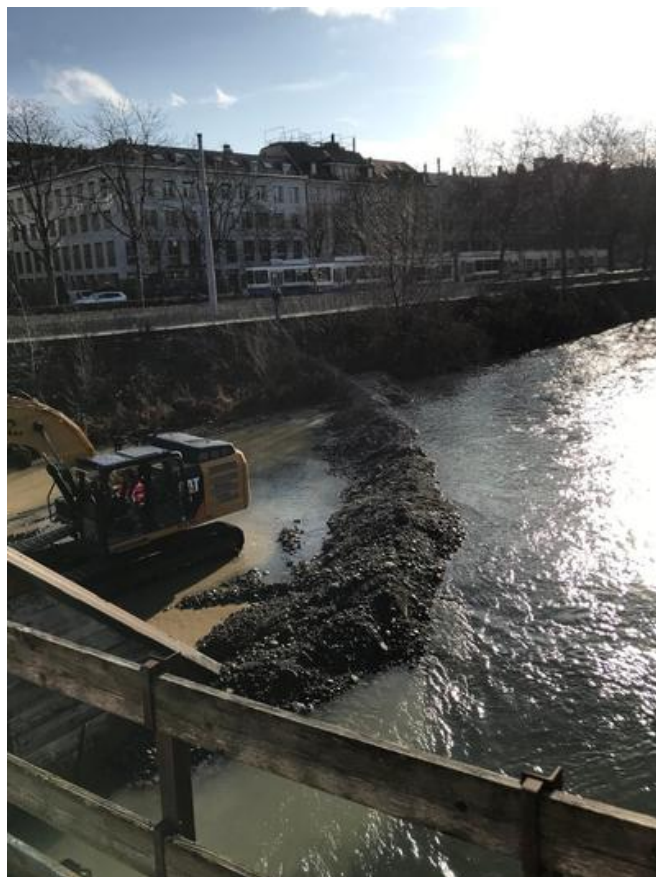
Für den reibungslosen Rückbau wurden überströmbare Dämme zur Trockenlegung der einzelnen Brückendurchlässe aufgeschüttet. Quelle: PORR
