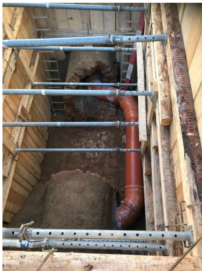
Ein extra angelegter Bypass stellte die dauerhafte Kanalversorgung sicher. Quelle: PORR
