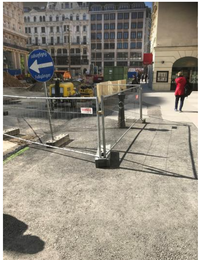
Über 1.000 m Bauzaun im Baustellenbereich. Quelle: PORR
