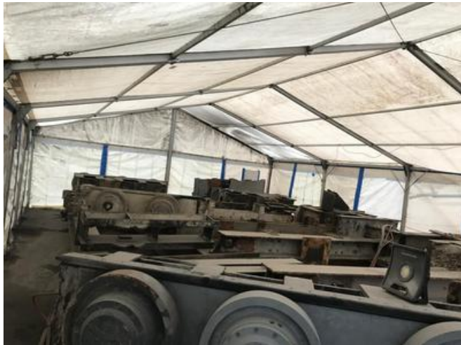
Im staubdichten Behandlungszelt hat das Team die Stahlteile entschichtet. Quelle: PORR
